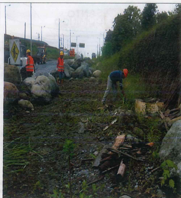
Retiro de escombros del área del puente sobre el By pass Quito - Quevedo
