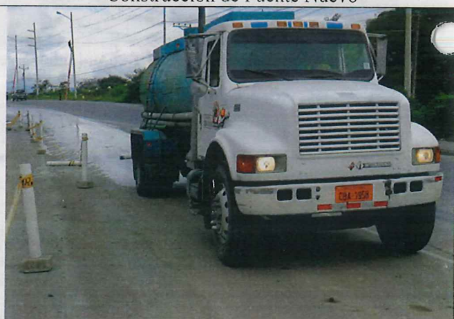
Limpieza de vía mediante tanquero de agua – KFC
