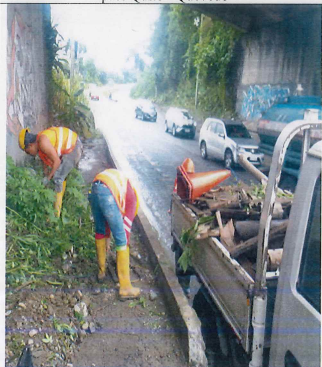
Retiro de escombros del área del puente sobre el By pass Quito - Quevedo
