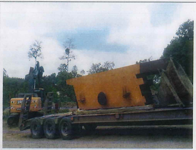
Retiro de maquinaria de las áreas de trabajo ()
