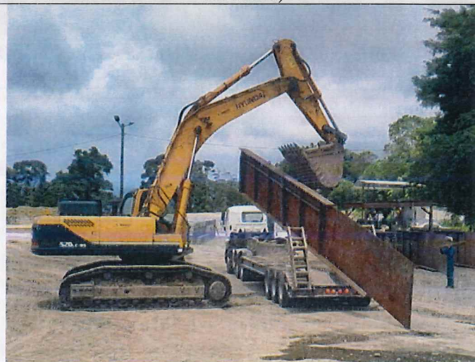
Desalojo de estructuras ajenas al proyecto
