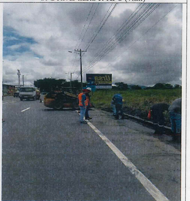
Limpieza de cunetas desde el Redondel del Sueño de Bolívar hasta el KFC (7km)
