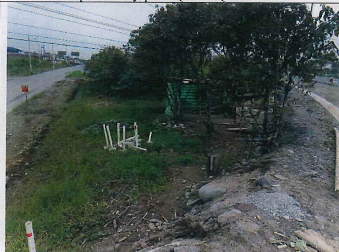
Campamento temporal para trabajos de construcción de puente By pass Quito -Quevedo
