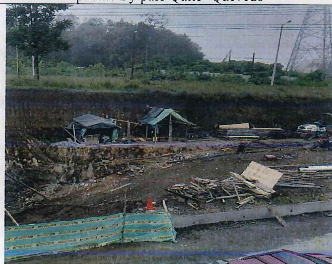
Campamento temporal para trabajos de construcción de puente By pass Quito -Quevedo
