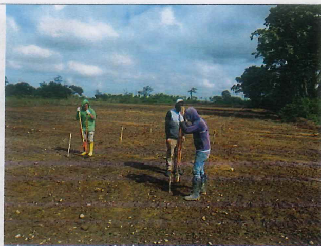
Preparación de terreno (desbroce, balizado y excavación de hoyos) para siembra
