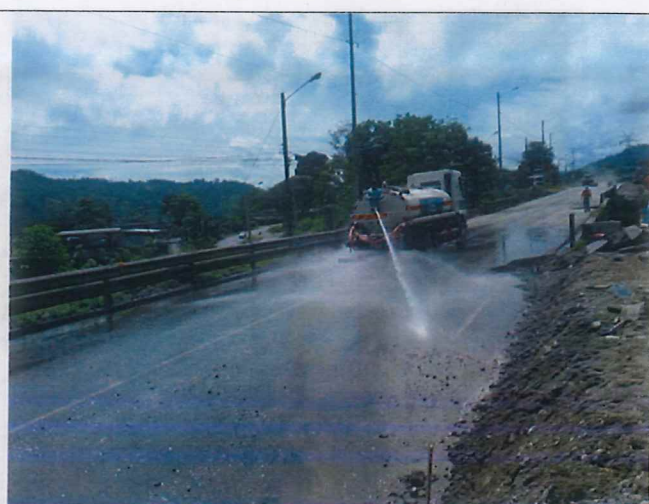
Limpieza de vía mediante tanquero de agua - Sector Construcción de Puente Nuevo
