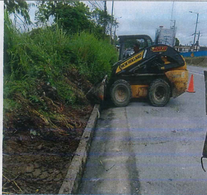
Limpieza de cunetas desde el Redondel del Sueño de Bolívar hasta el KFC (7km)
