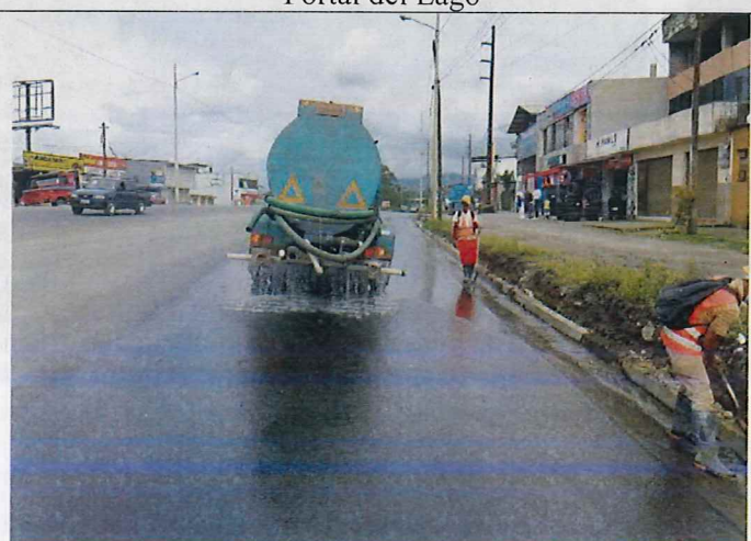
Limpieza de vía mediante tanquero de agua – Sector Redondel del Sueño de Bolívar
