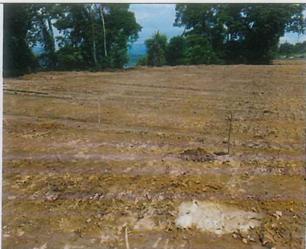
Preparación de terreno (desbroce, balizado y excavación de hoyos) para siembra
