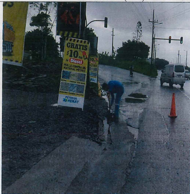
Limpieza de cunetas desde el Redondel del Sueño de Bolívar hasta el KFC (7km)
