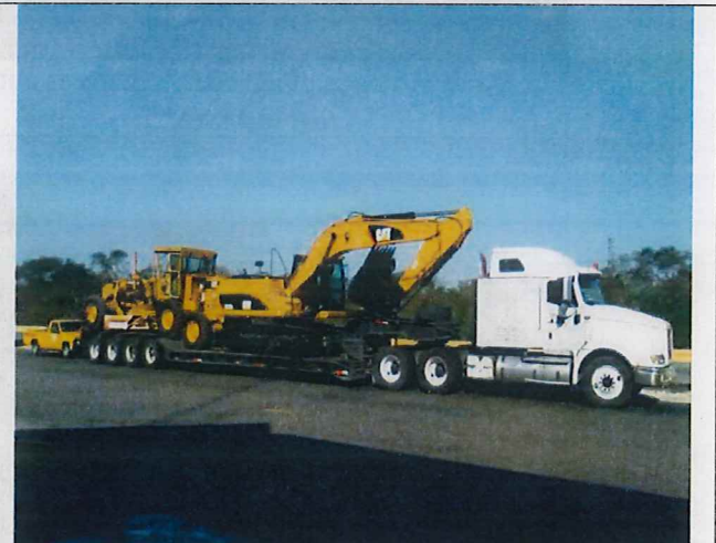
Retiro de maquinaria de las áreas de trabajo (retroexcavadora – excavadora - motoniveladora)
