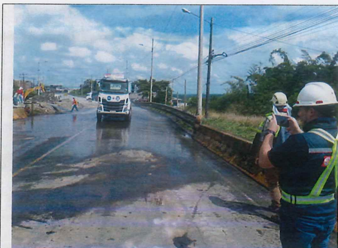
Limpieza de vía mediante tanquero de agua - Sector Construcción de Puente Nuevo
