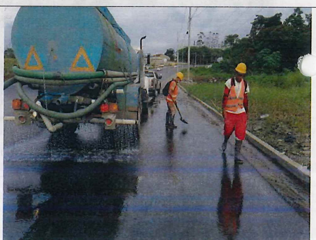
Limpieza de vía mediante tanquero de agua – Sector Entrada a la Av. 9 de diciembre
