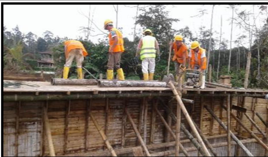
Trabajadores con los equipos minimos de seguridad.
