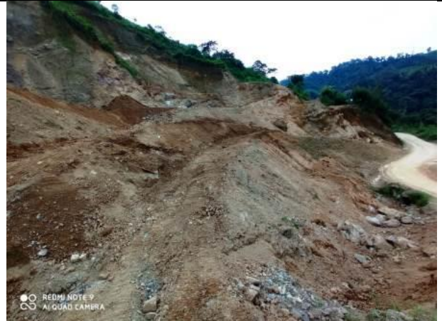
Fotografía No 6: Estabilización de taludes previa preparación de terreno y siembra de plantas
