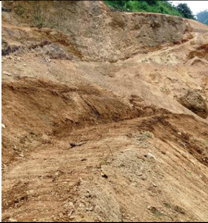
Fotografía No 7: Estabilización de taludes previa preparación de terreno y siembra de plantas
