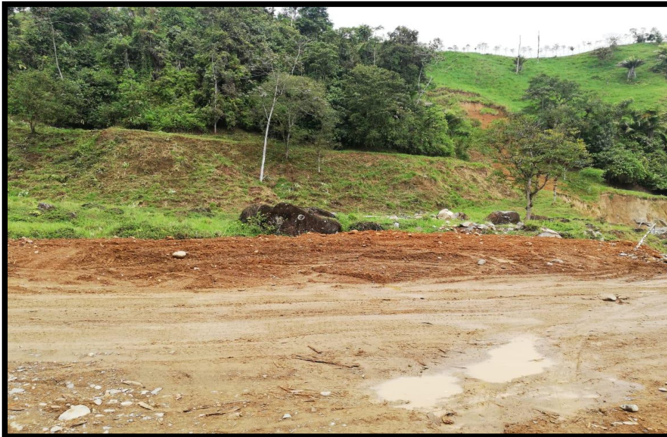
Fotografía 1 y 2 Área destina para el material desbrozado
