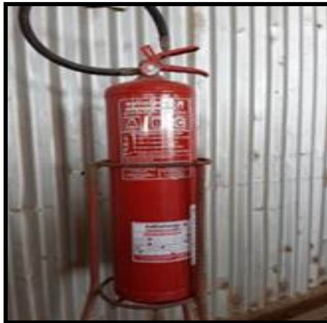
Fotografía 12 y 13 Simulacros de incendios
