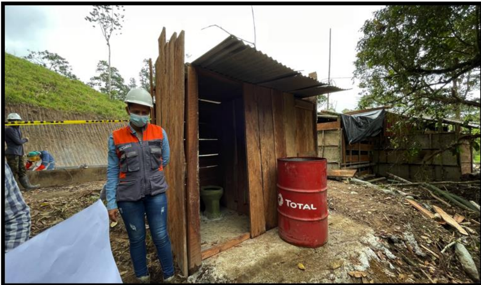
Fotografía 5 . Baños y Letrinas.
