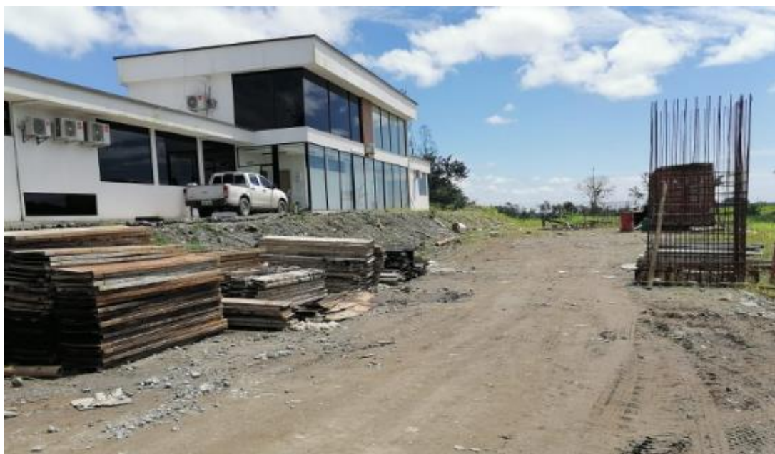
Orden y limpieza del campamento
