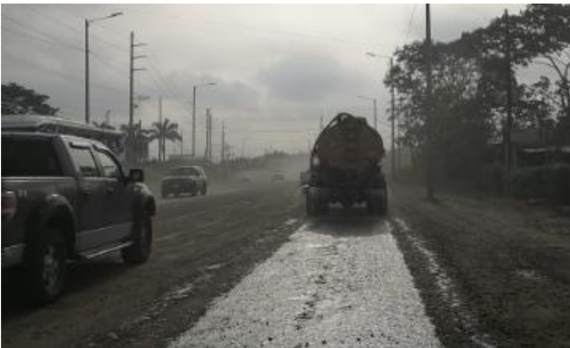
Control de polvo en la vía
