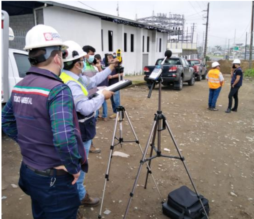
Monitoreo de ruido ambiente en la intervención de la colocación de la alcantarilla ármico abscisa 100+515
