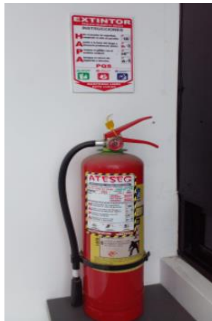
Colocación de extintor de 10 lbs clase ABC (PQS) como medio de extinción
