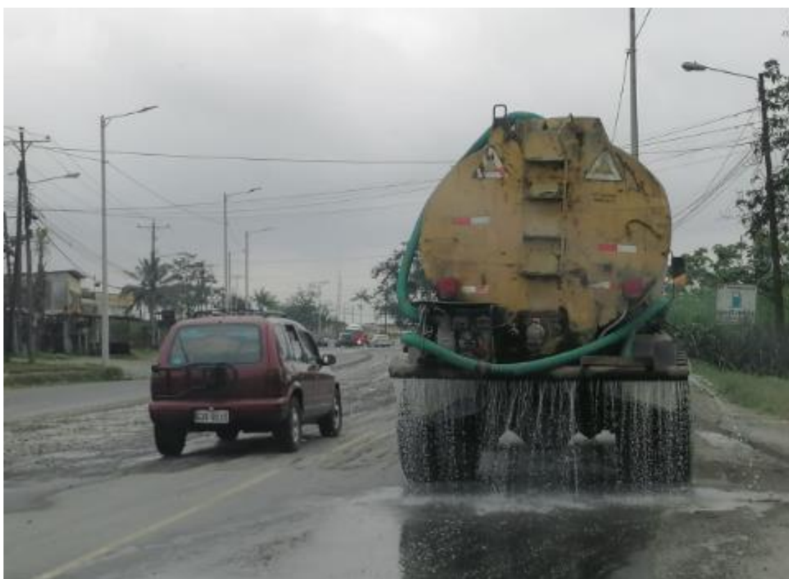
Control de polvo en la vía
