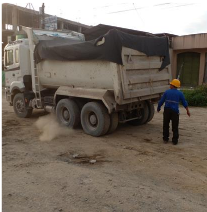
Volquete transportando el material pétreo para el relleno de la alcantarilla abscisa 100+515
