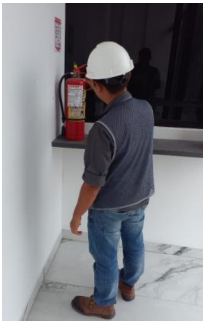
Colocación de extintor de 10 lbs clase ABC (PQS) como medio de extinción
