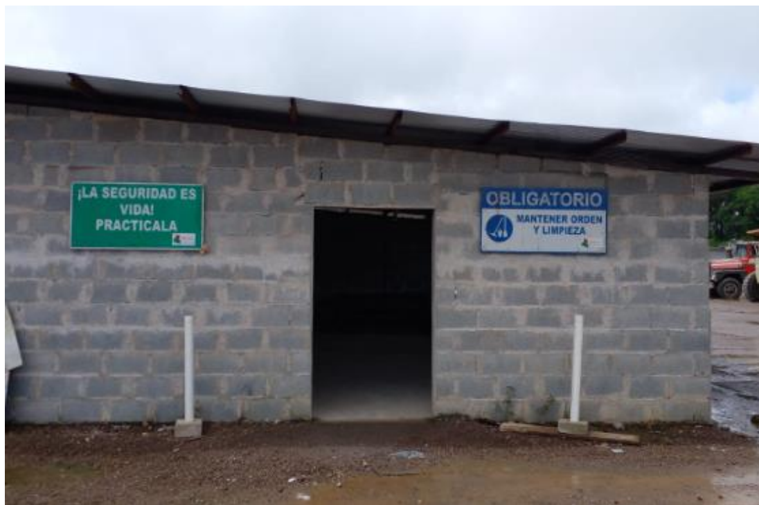
Orden y limpieza del campamento
