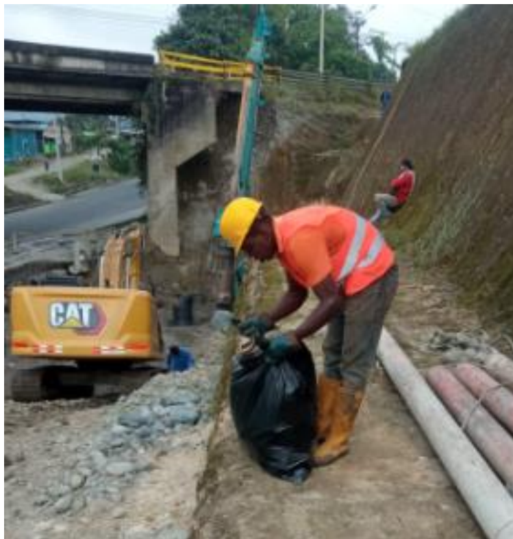
Recolección de los desechos sólidos generados en obra para posterior ser entregados al carro recolector de basura
