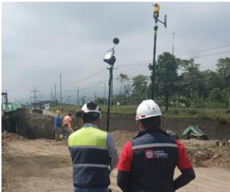
Monitoreo de ruido ambiente en la intervención de la fundición del puente sobre el by pass quito - quevedo
