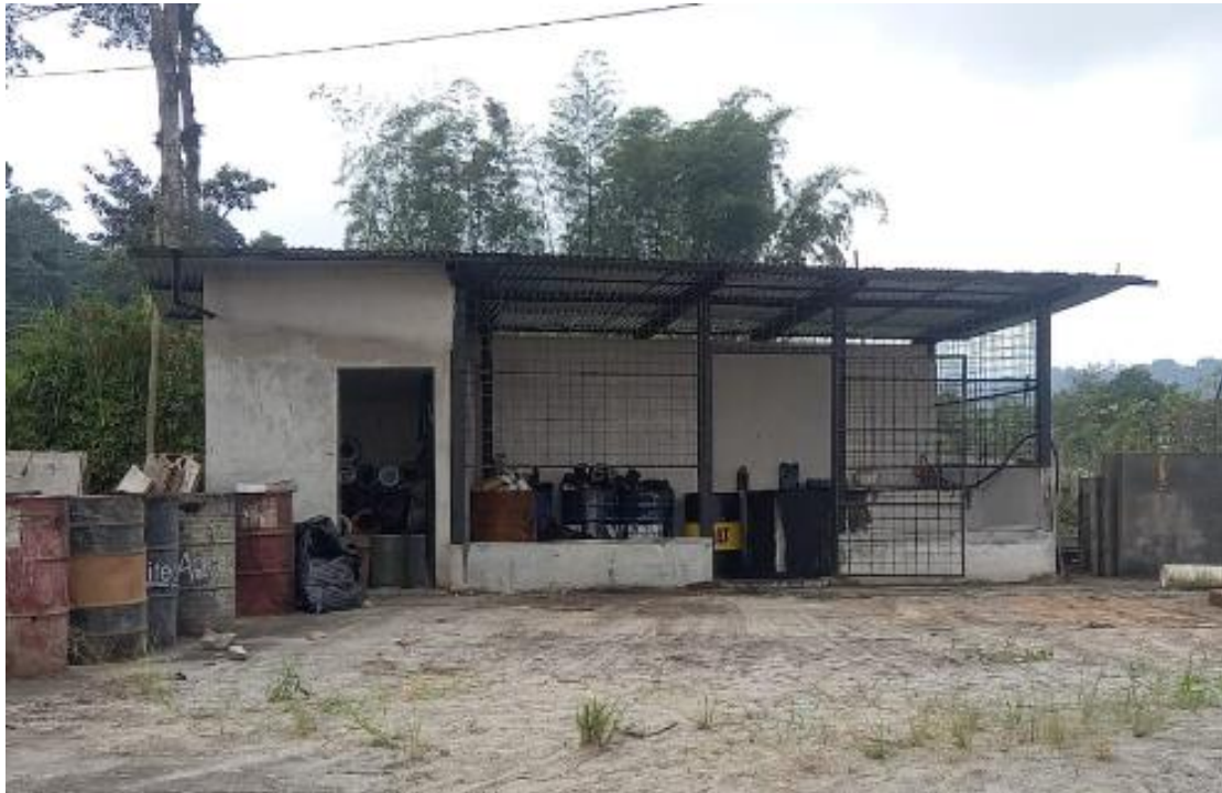
Área de almacenamiento temporal de desechos peligrosos
