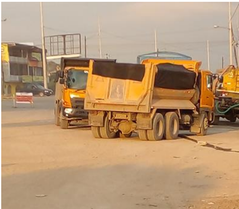
Volquete transportando el material pétreo para el relleno de la alcantarilla abscisa 100+515
