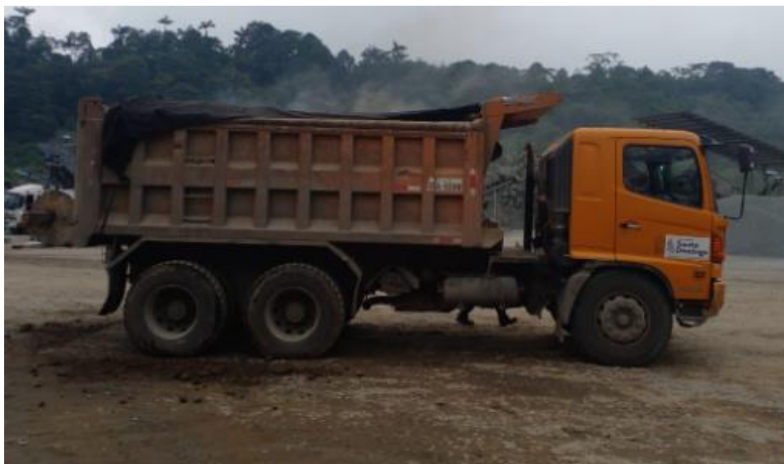
Volquete transportando el material pétreo para el relleno de la cajonera sector plaza Asturias
