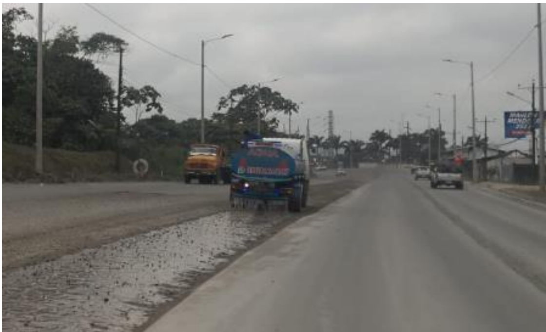
Control de polvo en la vía
