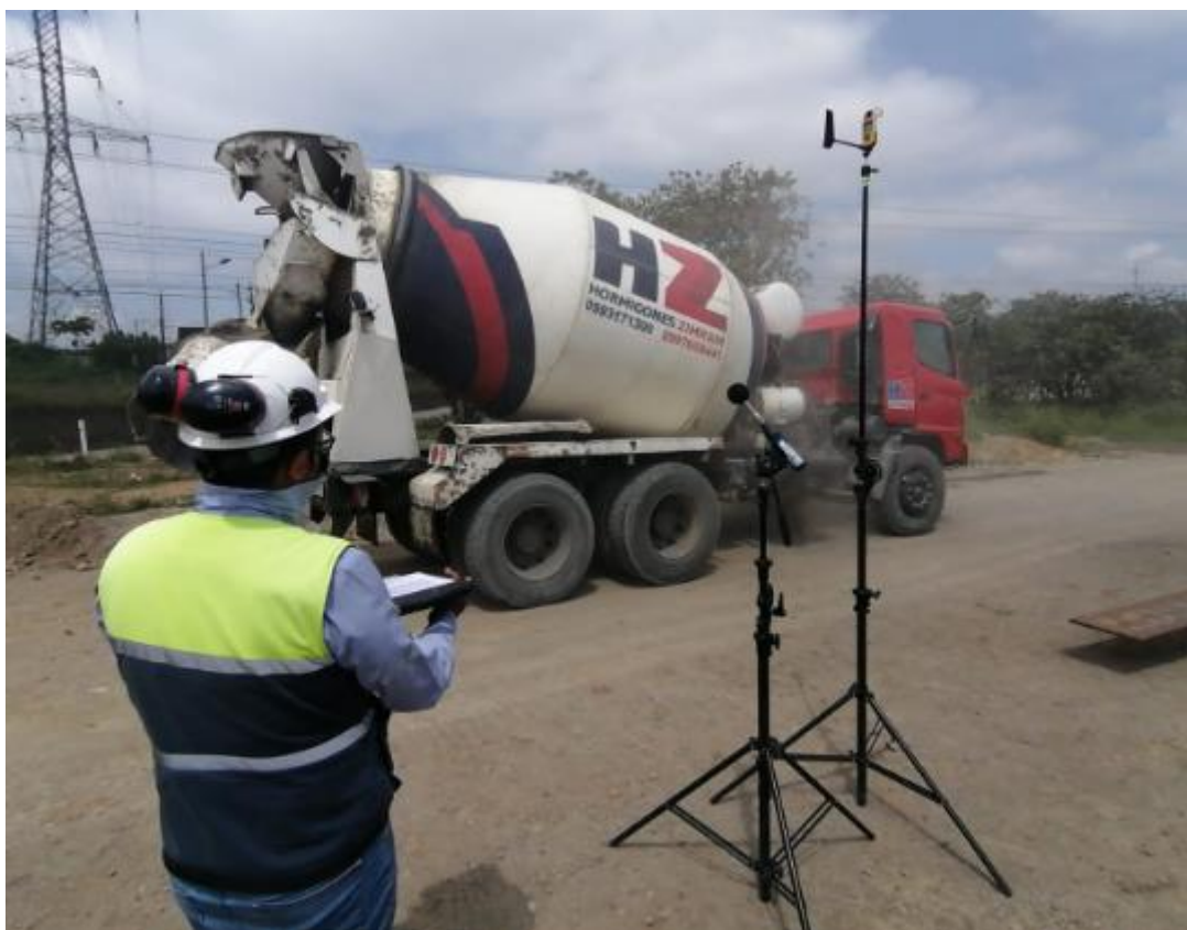
Monitoreo de ruido ambiente en la intervención de la fundición del puente sobre el by pass quito - quevedo
