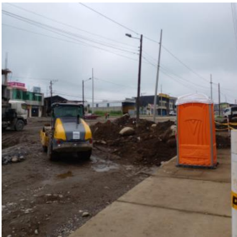
Batería sanitaria móvil empleada en obra
