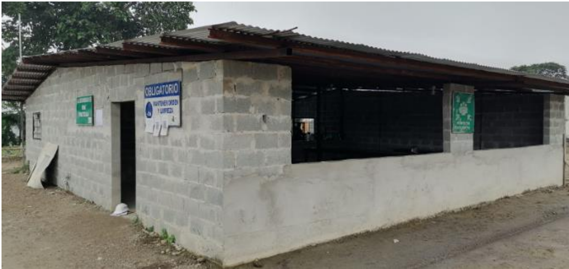
Señalización de salvamento e informativa
