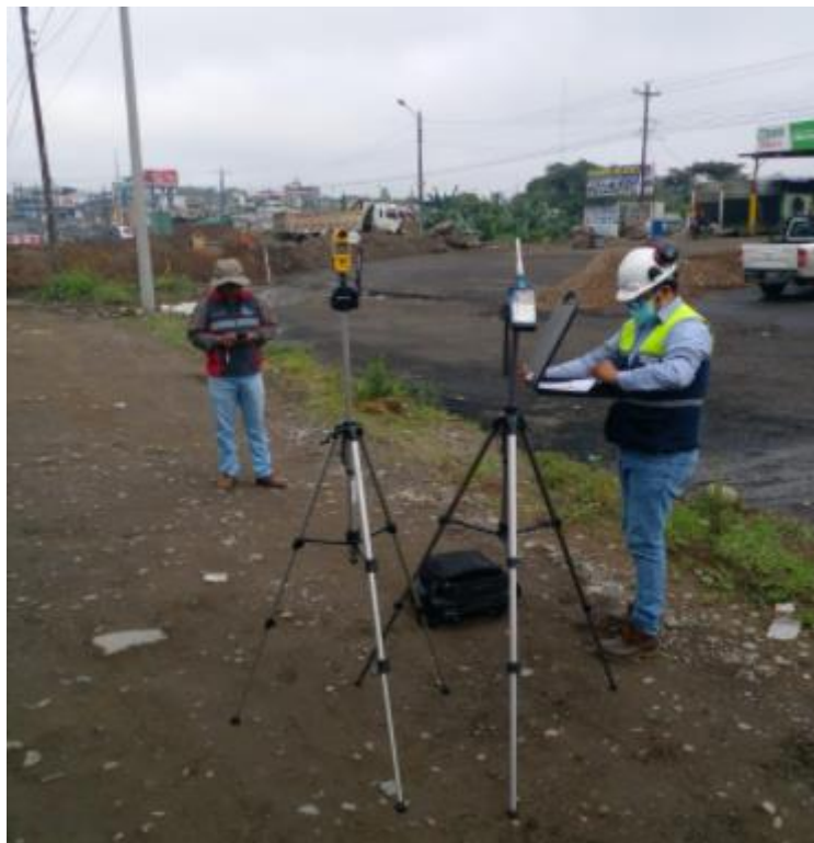
Monitoreo de ruido ambiente en la intervención de la colocación de la alcantarilla ármico abscisa 100+515
