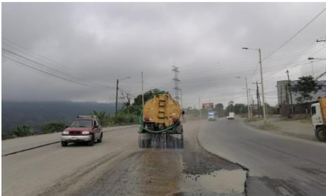
Control de polvo en la vía
