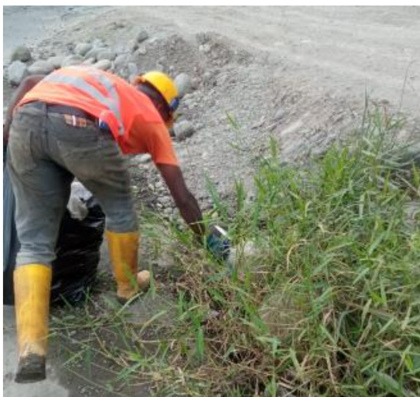
Recolección de los desechos sólidos generados en obra para posterior ser entregados al carro recolector de basura
