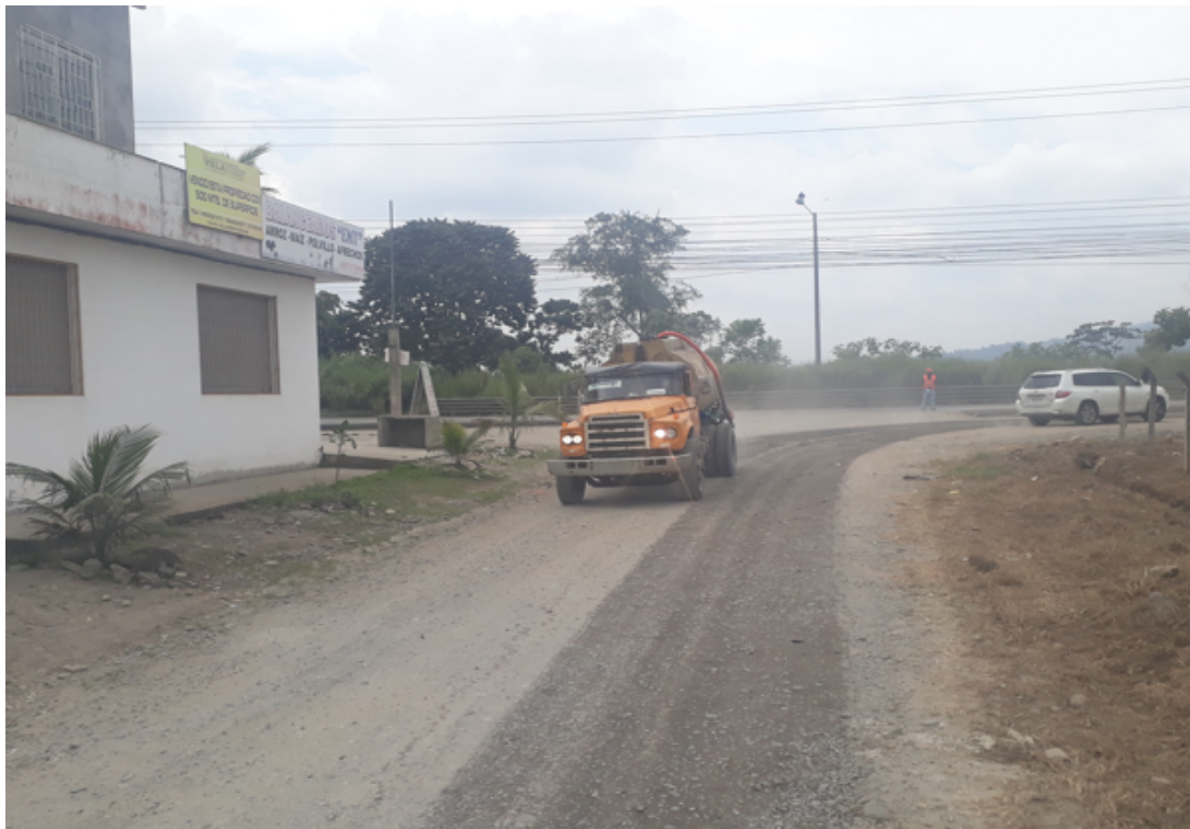
Control de polvo en el sector de la ANT abscisa 97+284 por efecto de la apertura de la alcantarilla
