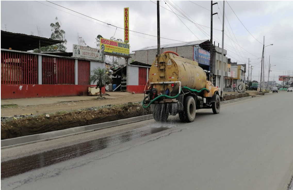
Control de polvo en el sector de la Urbanización Chiguilpe – trabajos de bordillo-cuneta
