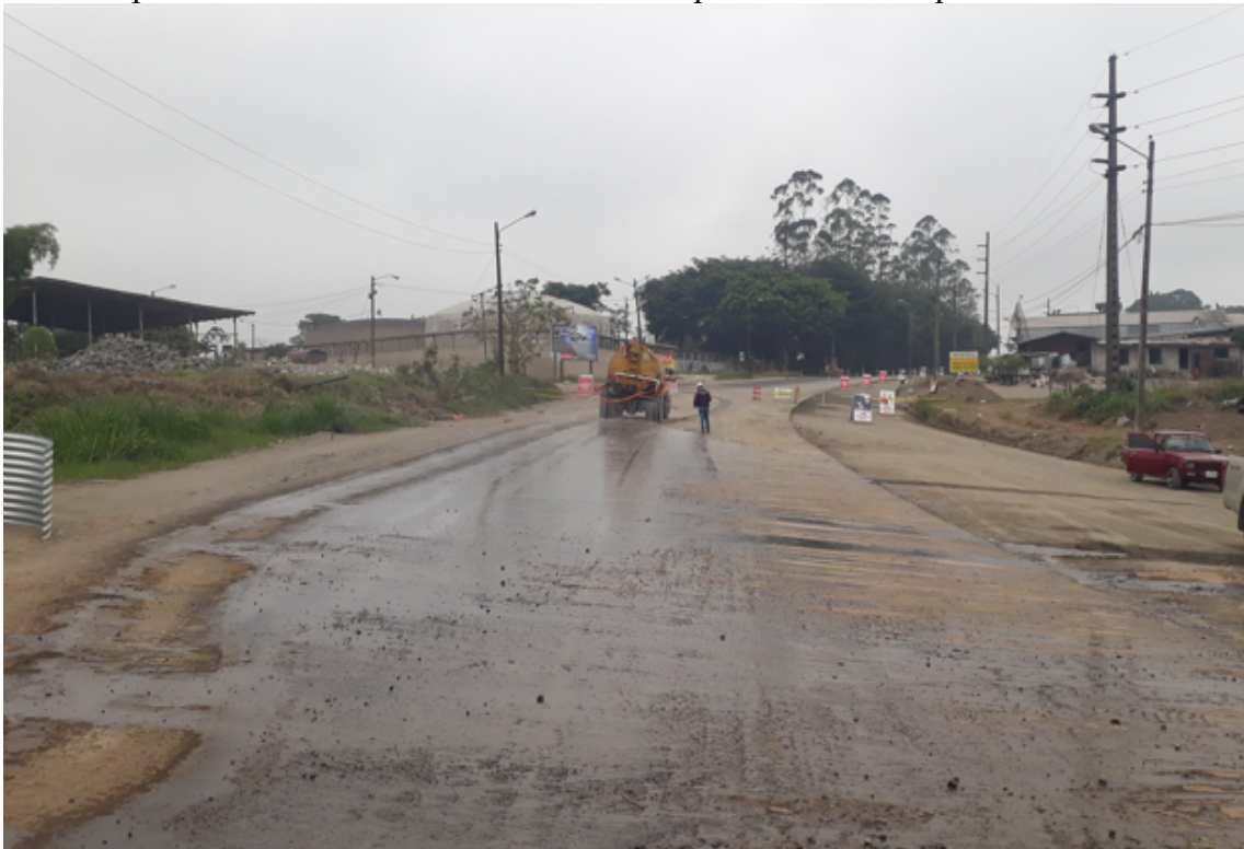
Control de polvo en la abscisa 99+990 por efectos de la apertura de la alcantarilla ármica
