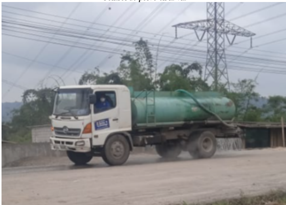
Control de polvo en la vía
