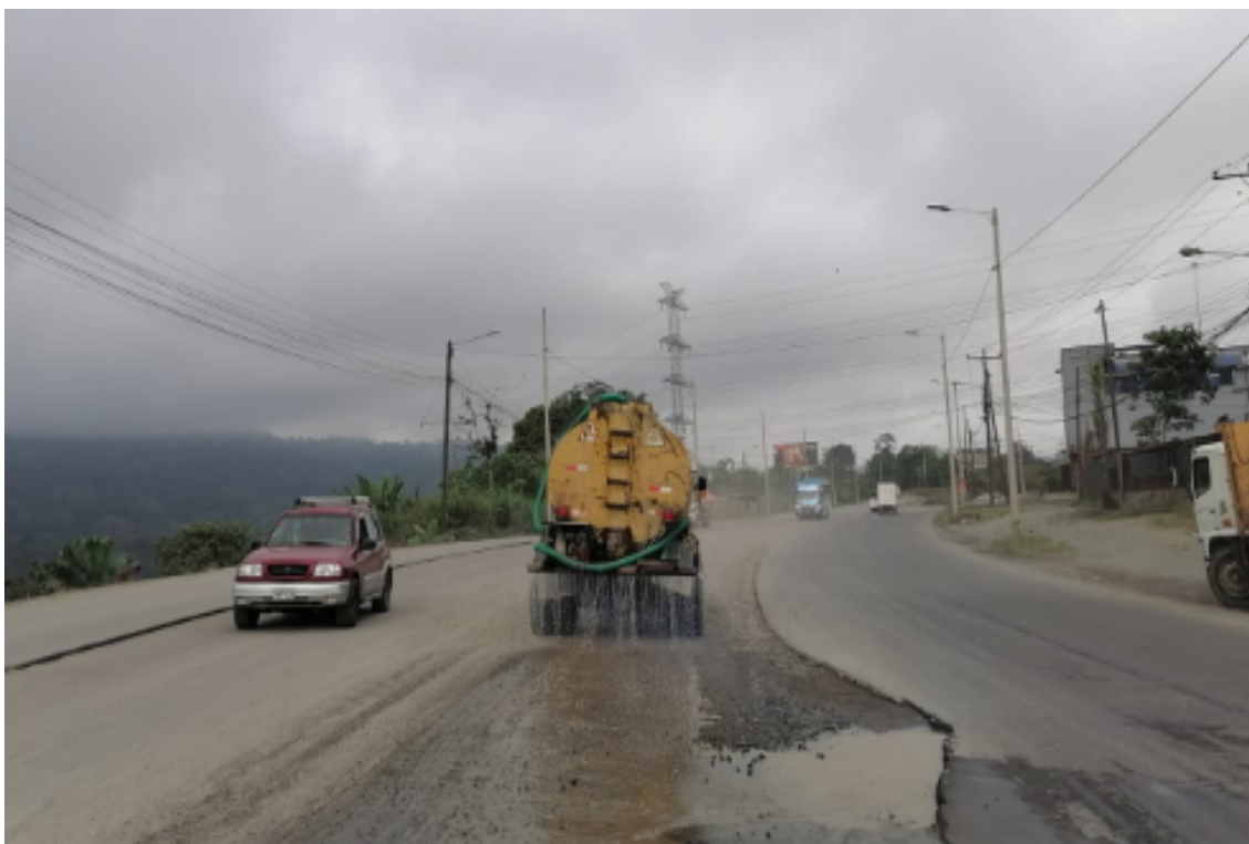
Control de polvo en la vía
