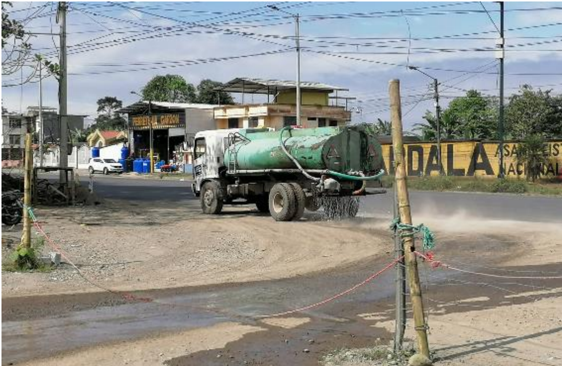
Control de polvo en la vía
