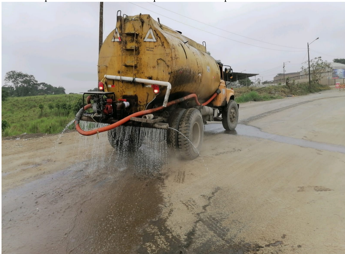
Control de polvo en la abscisa 99+990 por efectos de la apertura de la alcantarilla ármica
