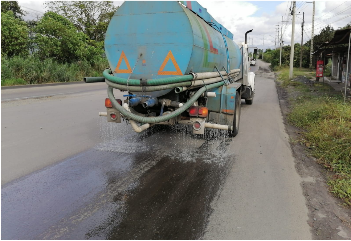
Control de polvo en la vía
