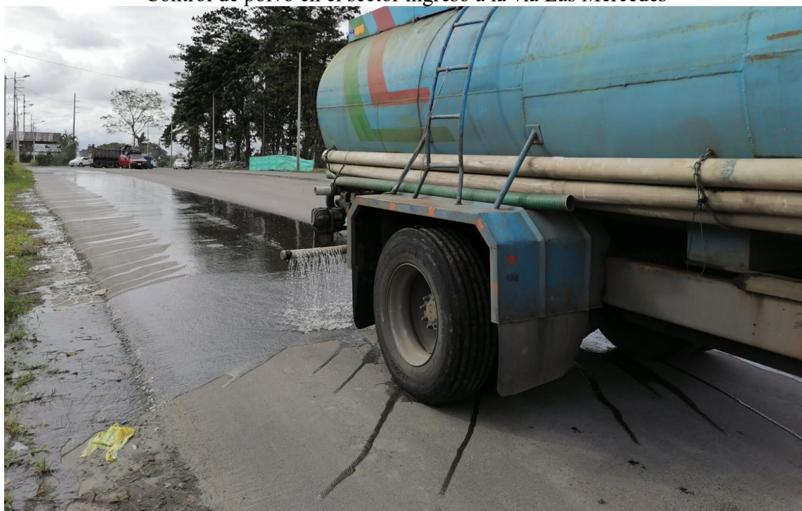
Control de polvo en el sector ANT
