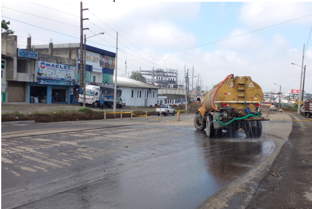
Control de polvo en el sector cooperativa “El Edén – sueño de bolívar” abscisa 100+450 por efecto de la apertura de la alcantarilla
