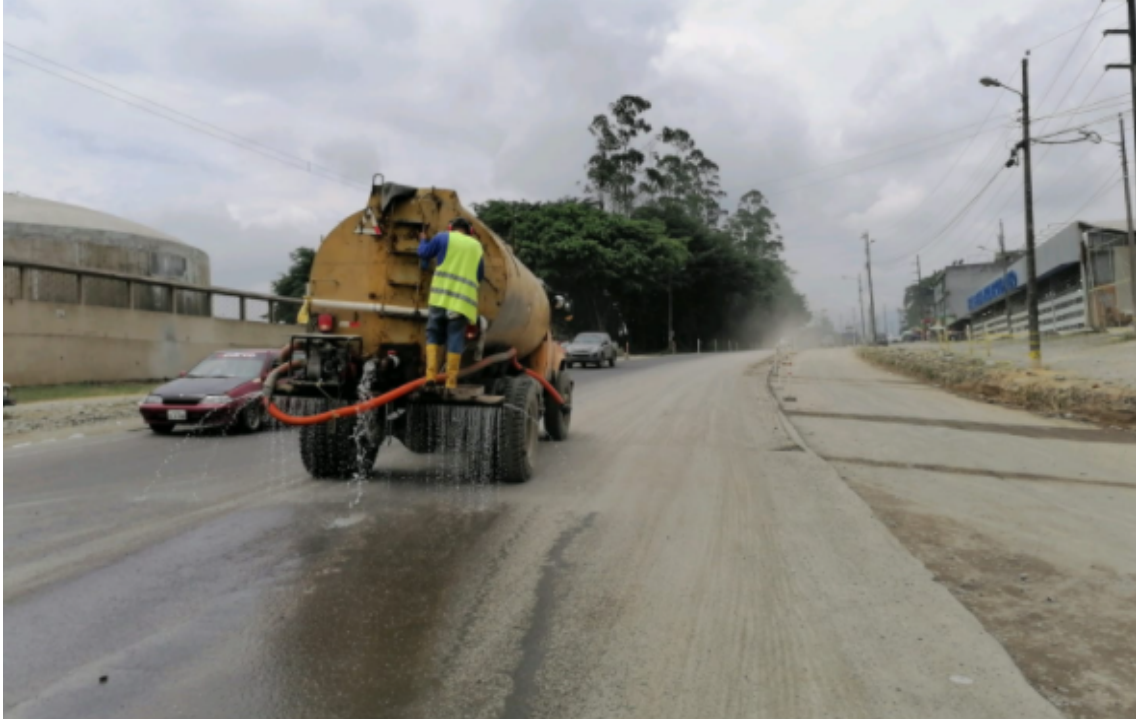
Control de polvo en el sector de la Feria de Pelileo por efecto de la apertura de la alcantarilla
