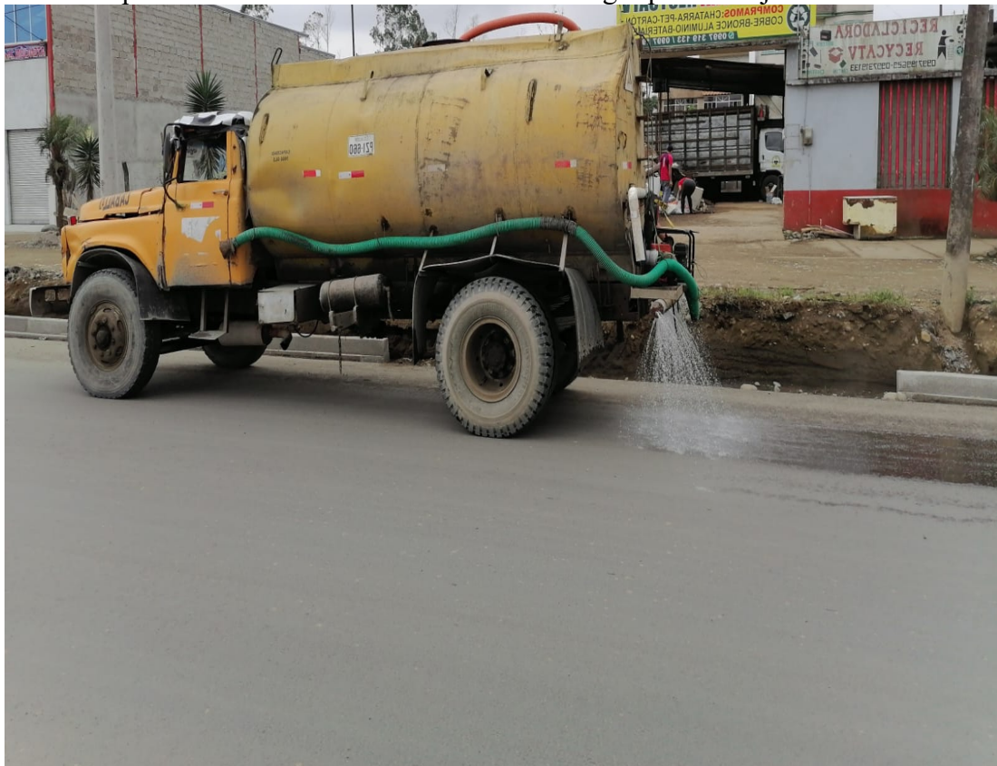
Control de polvo en el sector de la Urbanización Chiguilpe – trabajos de bordillo-cuneta
