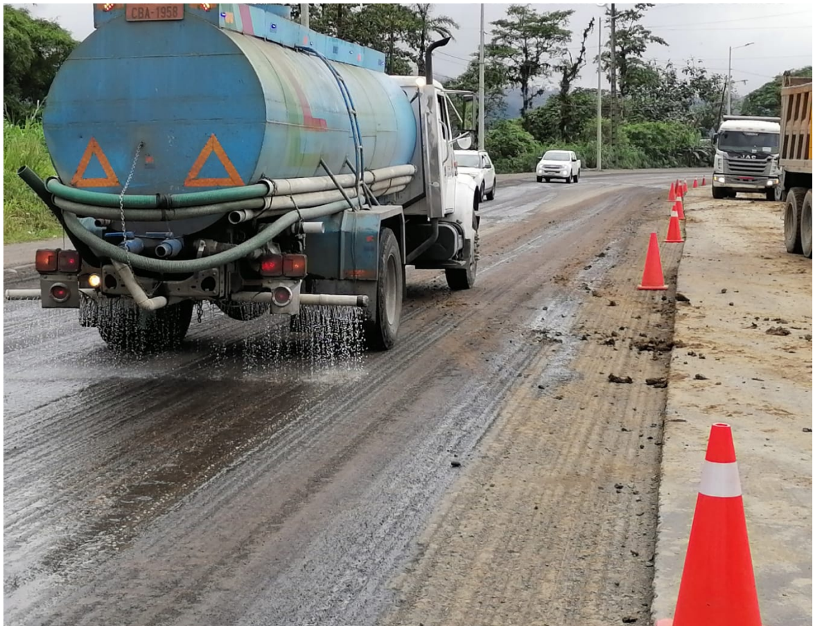
Control de polvo en el sector ANT
