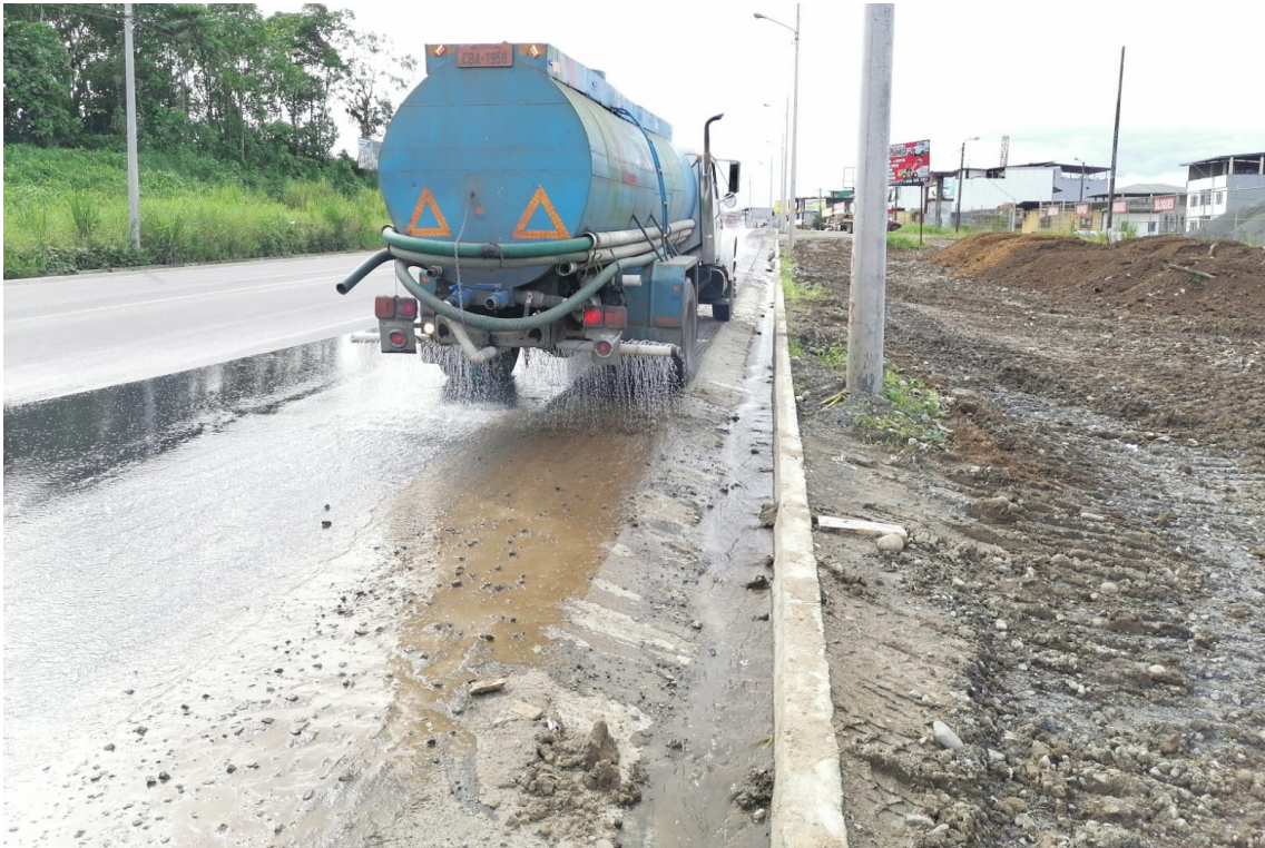
Control de polvo en la vía
