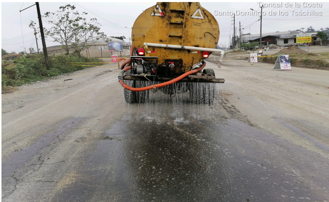
Control de polvo en la abscisa 99+990 por efectos de la apertura de la alcantarilla ármica
