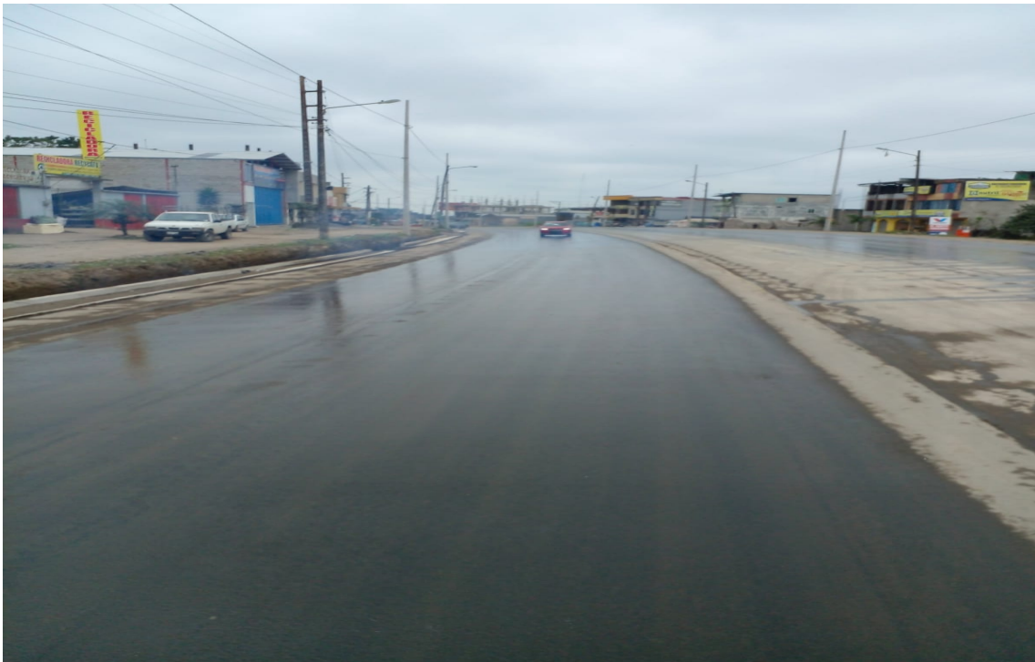
Control de polvo en el sector cooperativa “El Edén – sueño de bolívar” abscisa 100+450 por efecto de la construcción de cunetas
