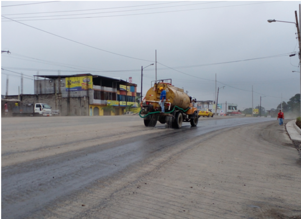
Control de polvo en el sector cooperativa “El Edén – sueño de bolívar” abscisa 100+450 por efecto de la apertura de la alcantarilla
