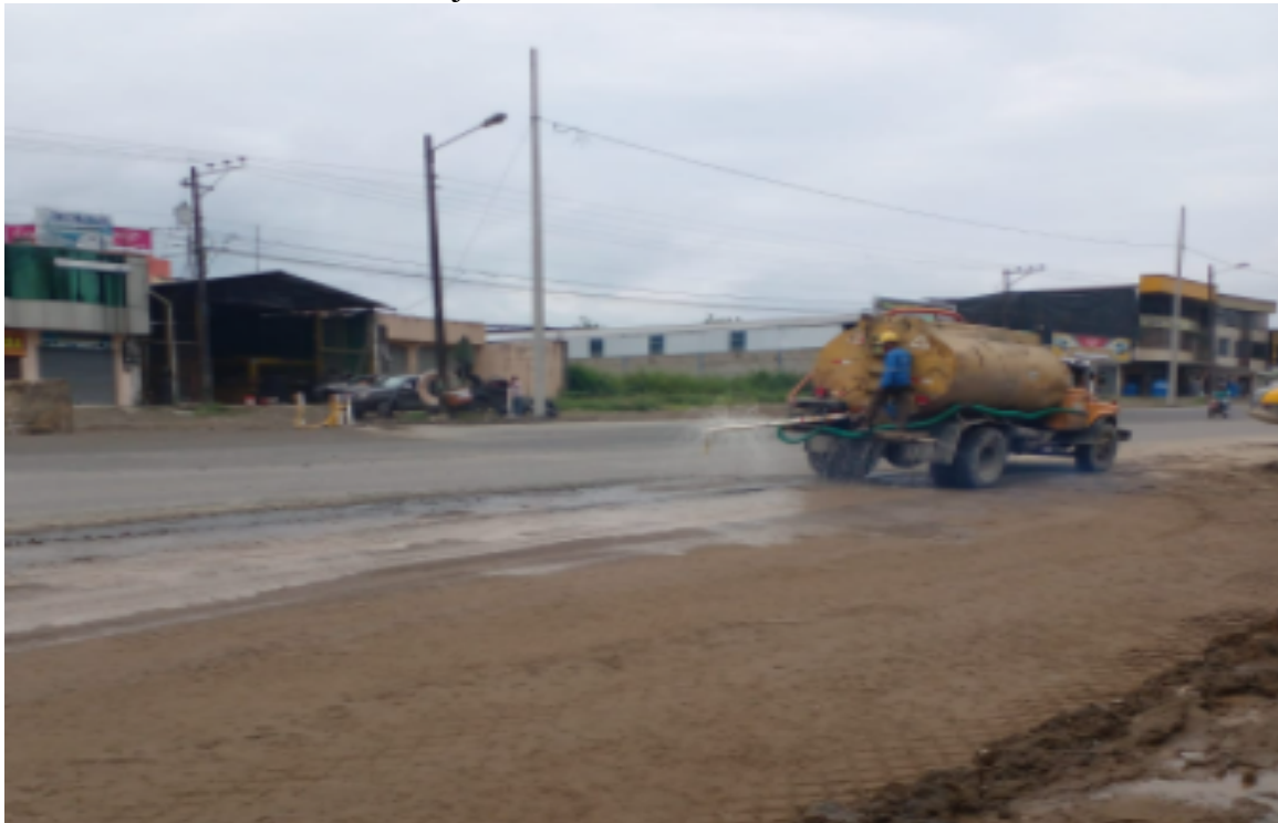
Control de polvo en el sector sueño de bolívar abscisa 100+600 por efecto del corte de la cajonera a los laterales de la vía existente.
