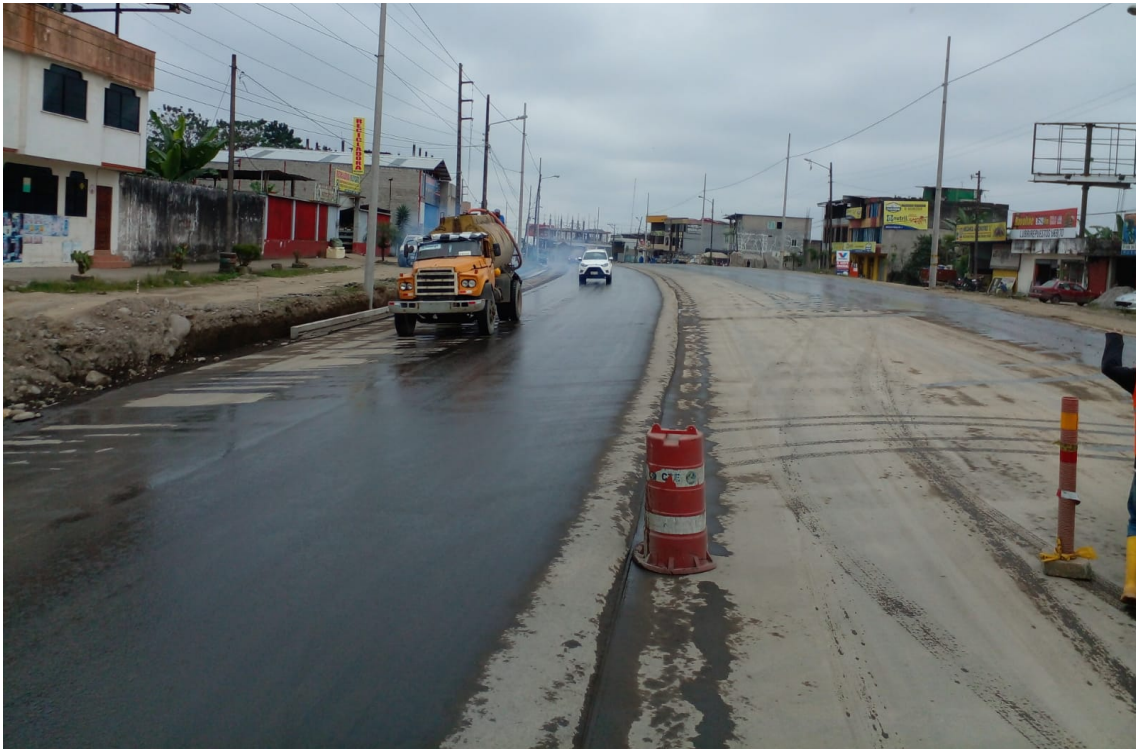
Control de polvo en el sector cooperativa “El Edén – sueño de bolívar” abscisa 100+450 por efecto de la construcción de cunetas
