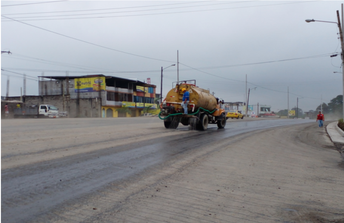
Control de polvo en el sector cooperativa “El Edén – sueño de bolívar” abscisa 100+450 por efecto del corte de la cajonera a los laterales de la vía existente.
