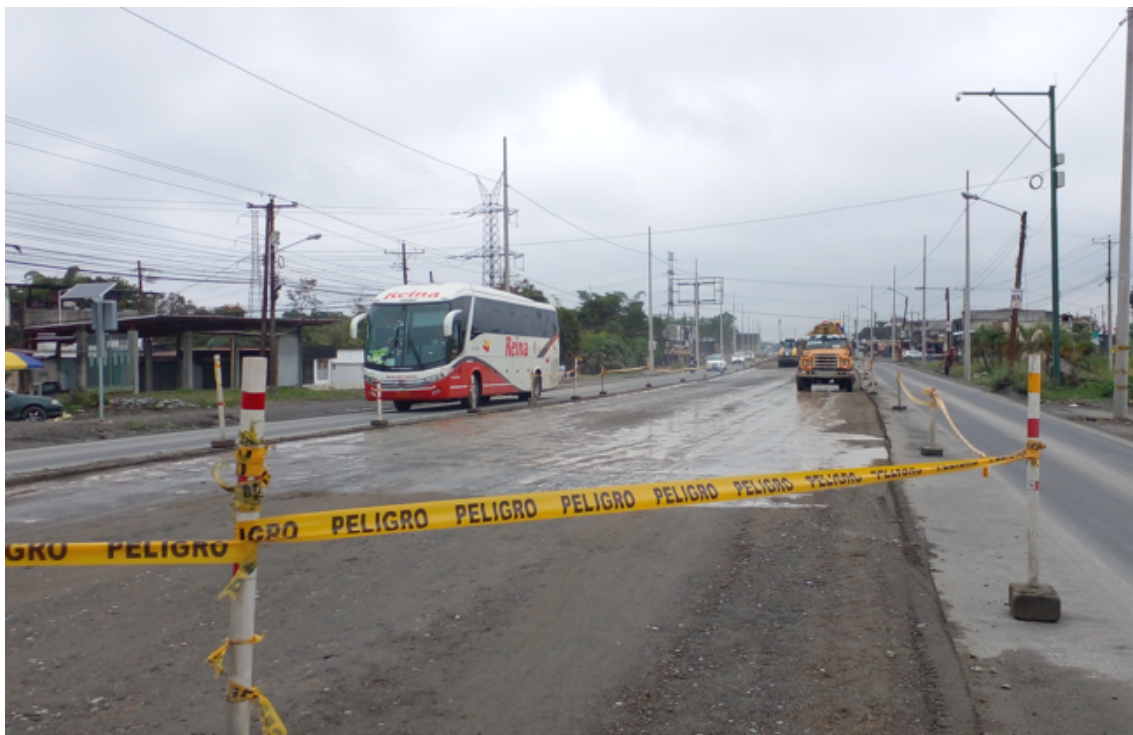
Control de polvo en el sector KFC por efecto del corte y relleno de la cajonera
