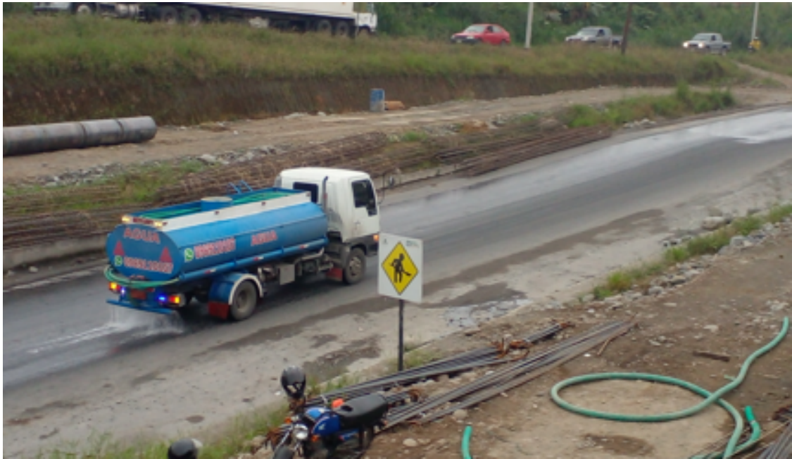
Control de polvo en la vía
