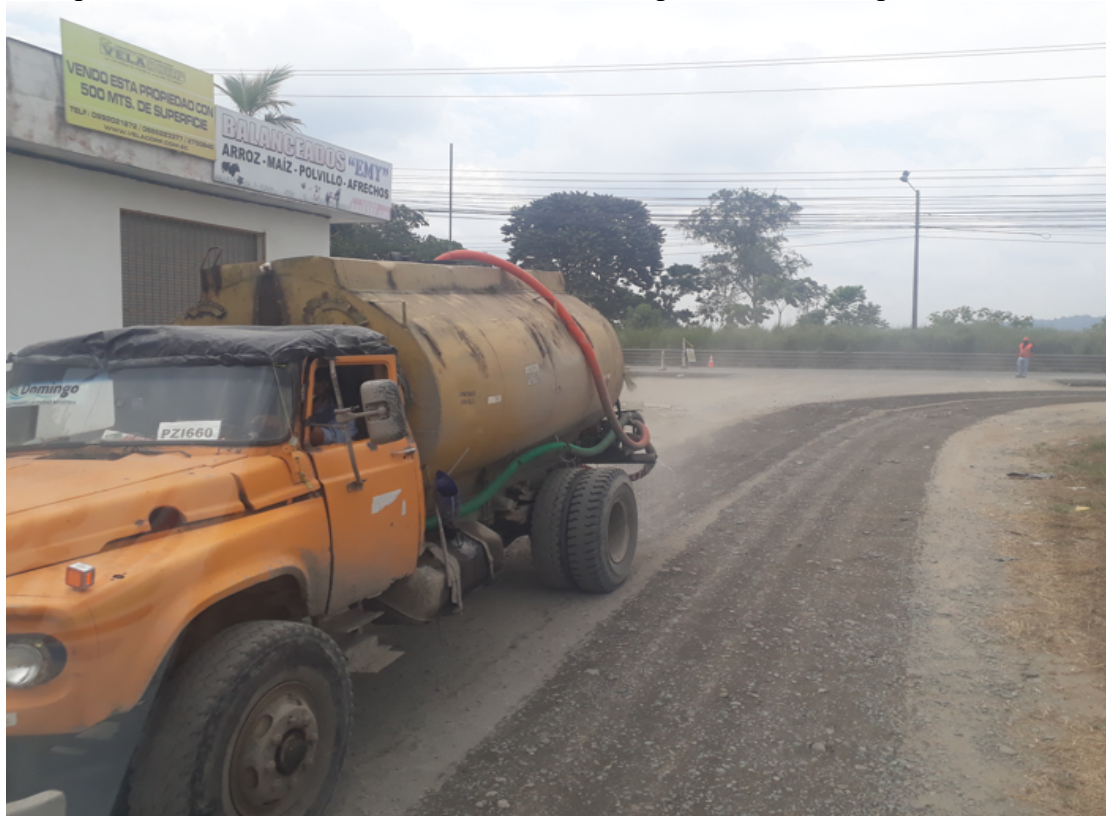
Control de polvo en el sector de la ANT abscisa 97+284 por efecto de la apertura de la alcantarilla
