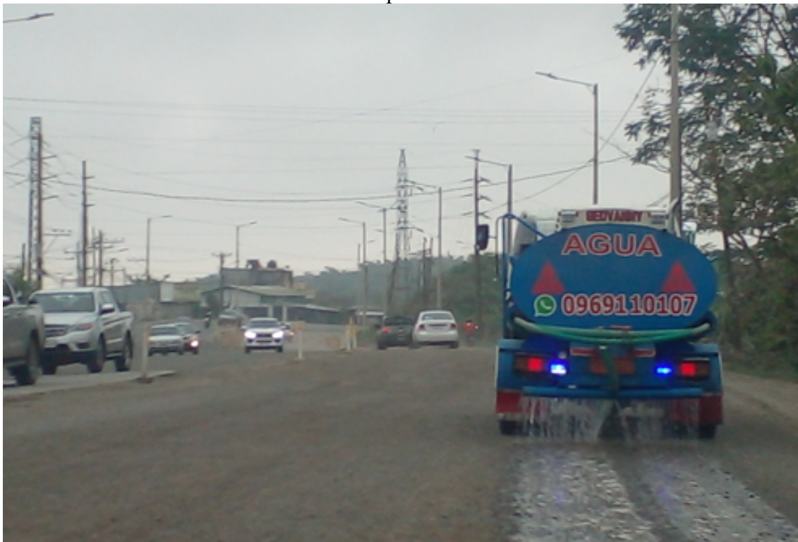
Control de polvo en la vía
