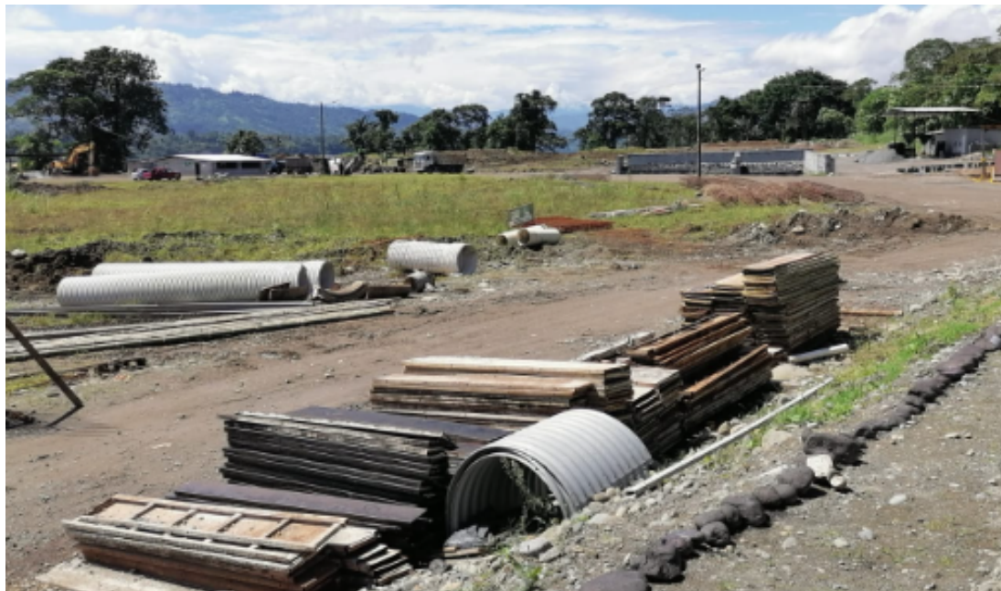
Orden y limpieza del campamento
