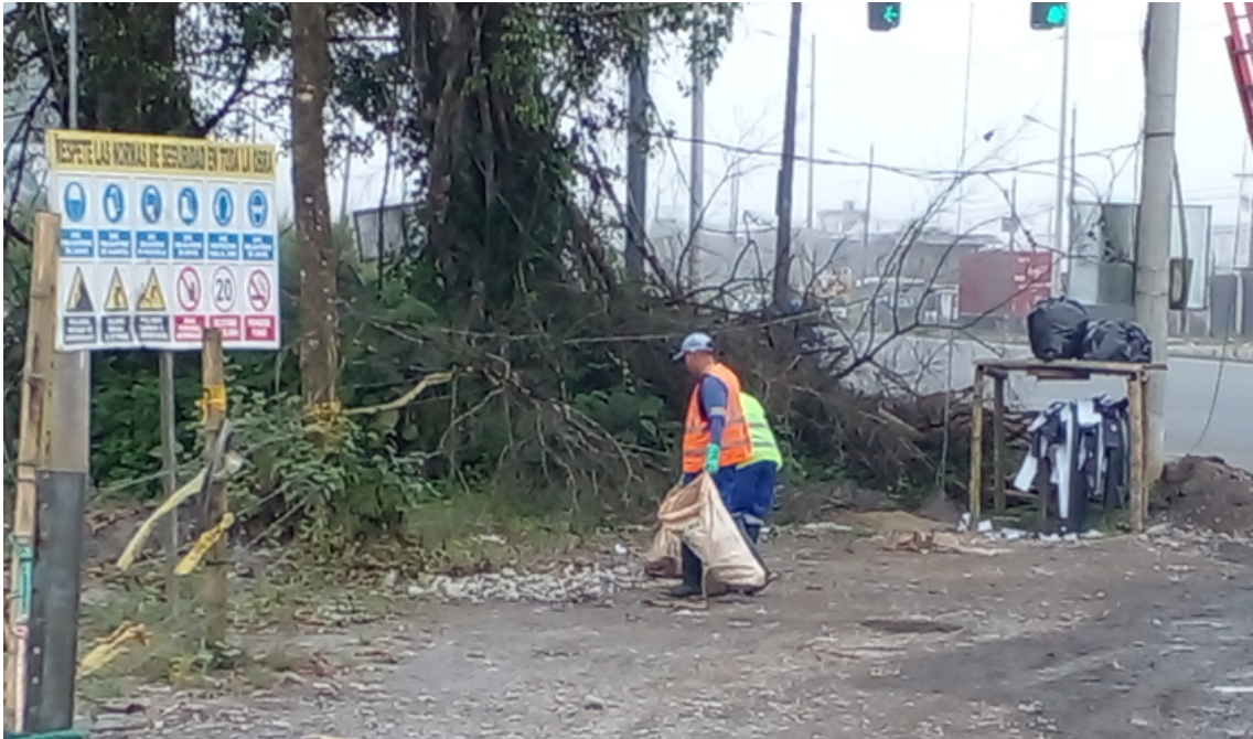
Recolección de los desechos sólidos generados en obra para posterior ser entregados al carro recolector de basura
