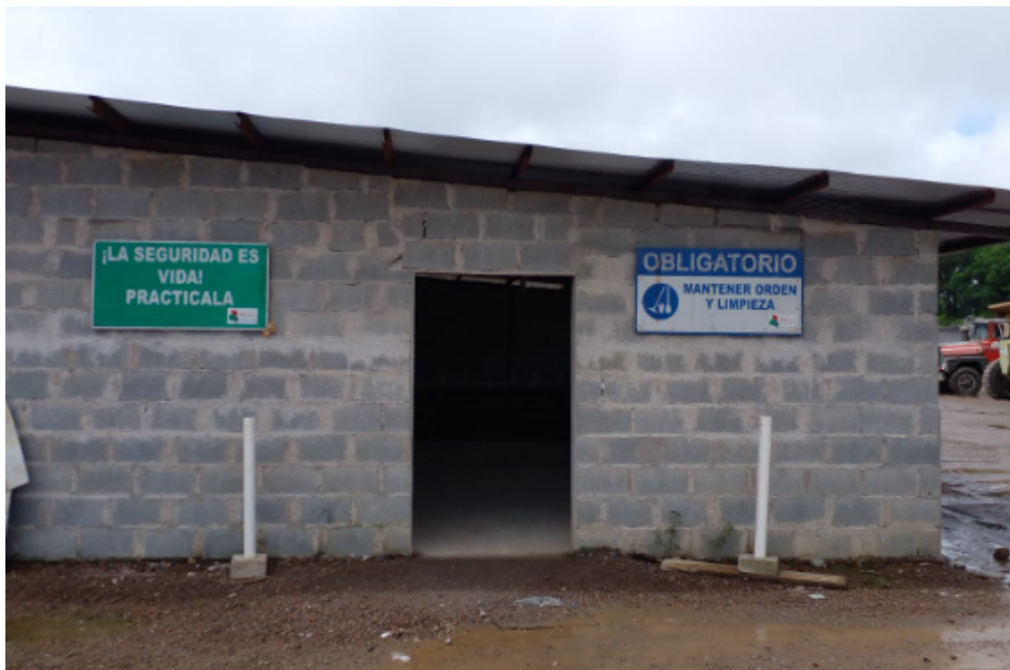
Orden y limpieza del campamento
