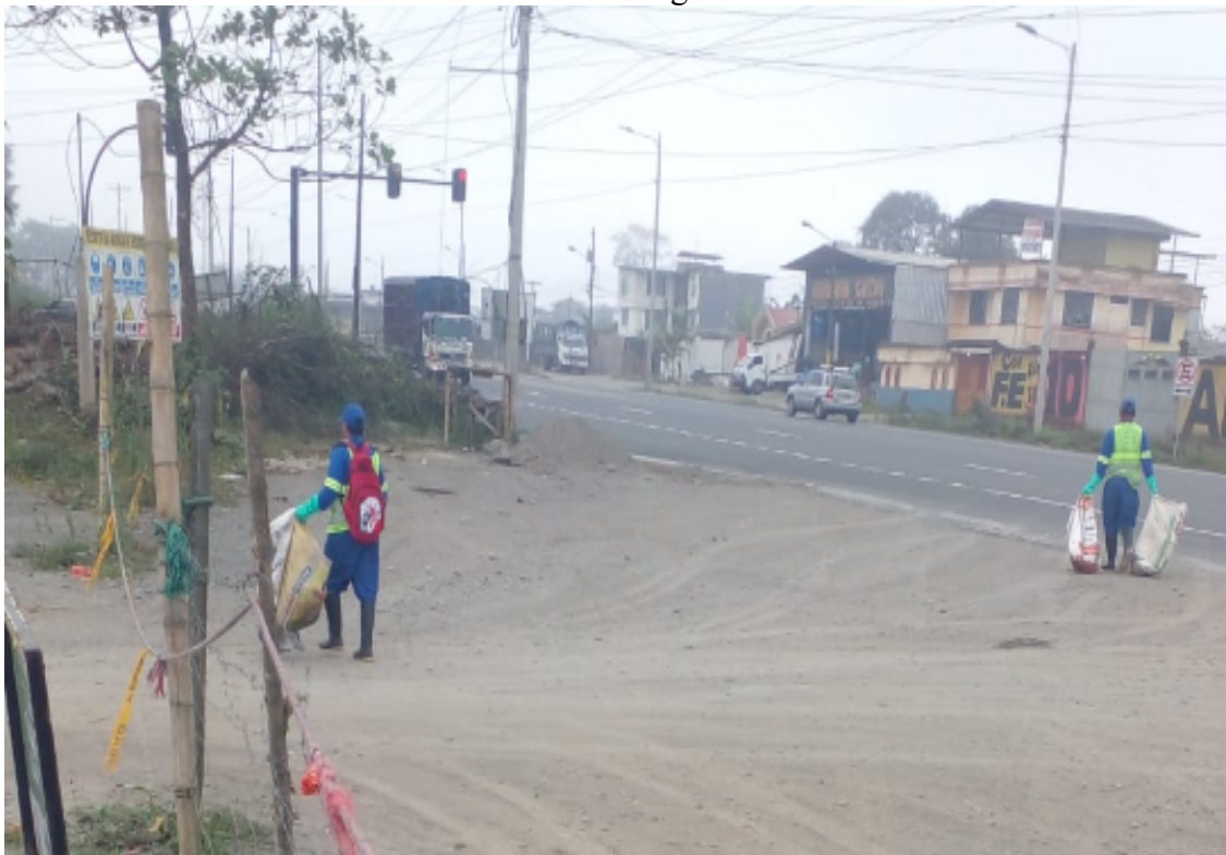
Recolección de los desechos sólidos generados en obra para posterior ser entregados al carro recolector de basura
