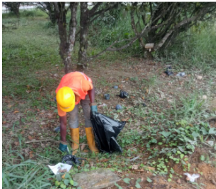
Recolección de los desechos sólidos generados en obra para posterior ser entregados al carro recolector de basura
