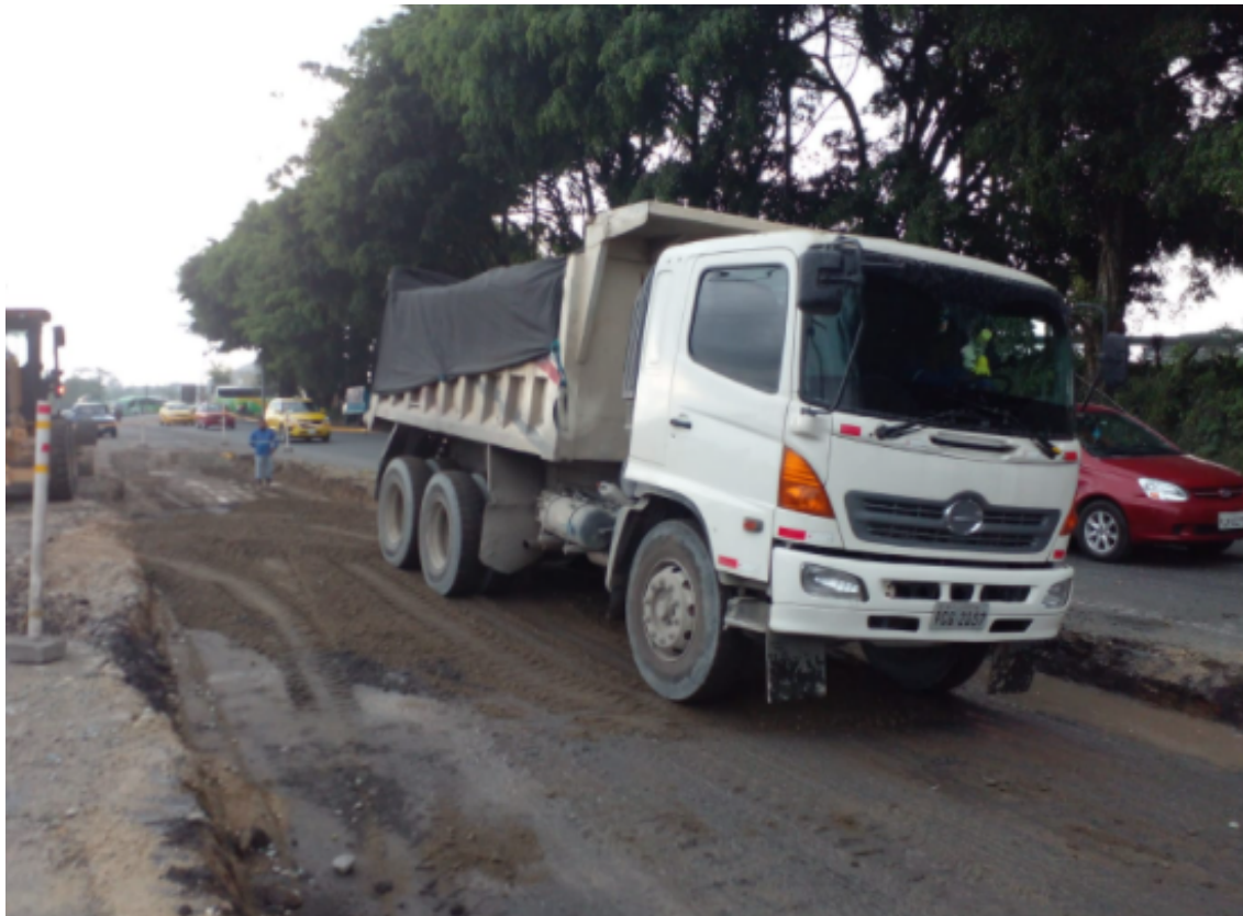
Volqueta transportando el material pétreo para el relleno de la cajonera de la entrada a la Av. Yamboya.
