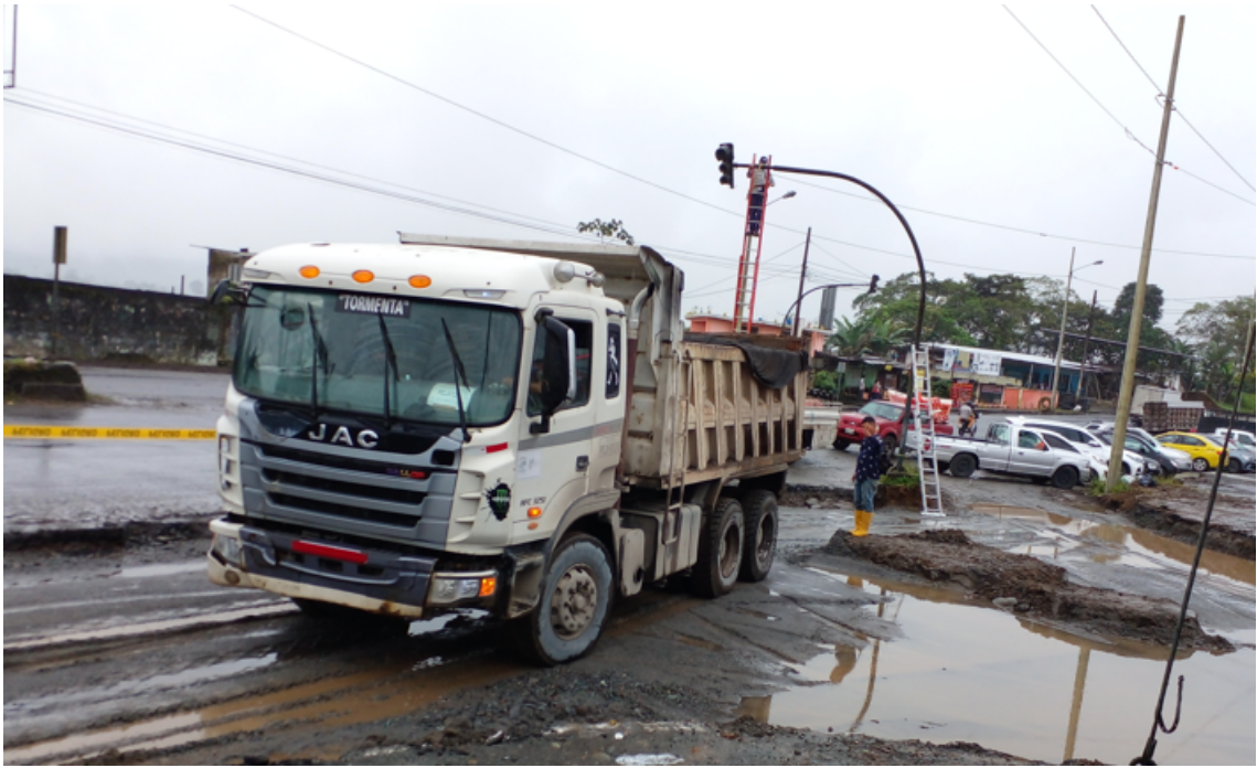
Volqueta transportando el material pétreo para el relleno con base de la vía Sector ANT.
