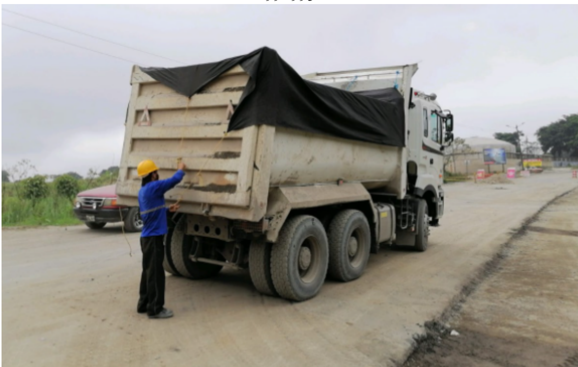
Volquete transportando el material pétreo para el relleno de la alcantarilla abscisa 99+995
