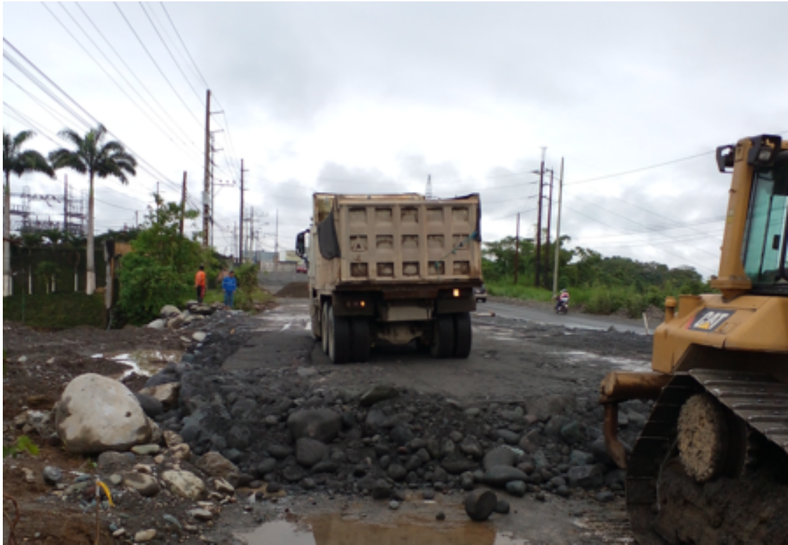
Volqueta transportando el material pétreo para el relleno de la cajonera sector Los Ocampo
