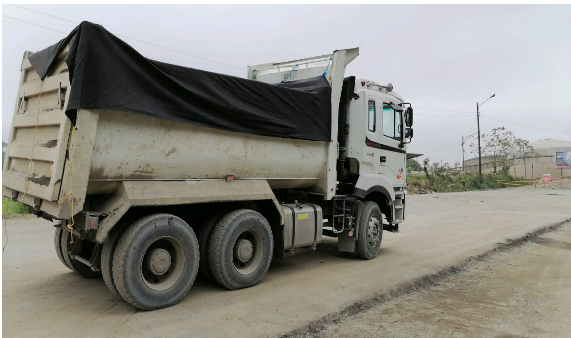
Volqueta transportando el material pétreo (subbase) para cunetas desde abscisa 97+900 hasta la abscisa 100+634.
