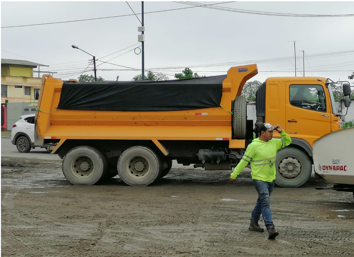
Volqueta transportando el material pétreo (subbase) para cunetas desde abscisa 97+900 hasta la abscisa 100+634.
