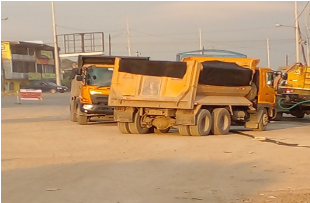
Volquete transportando el material pétreo para el relleno de la alcantarilla abscisa 100+515
