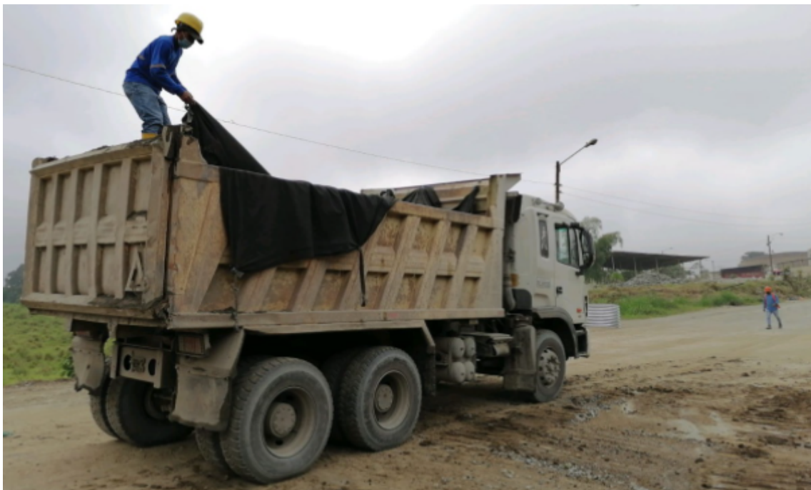
Volqueta transportando el material pétreo para el relleno de la alcantarilla abscisa 99+995
