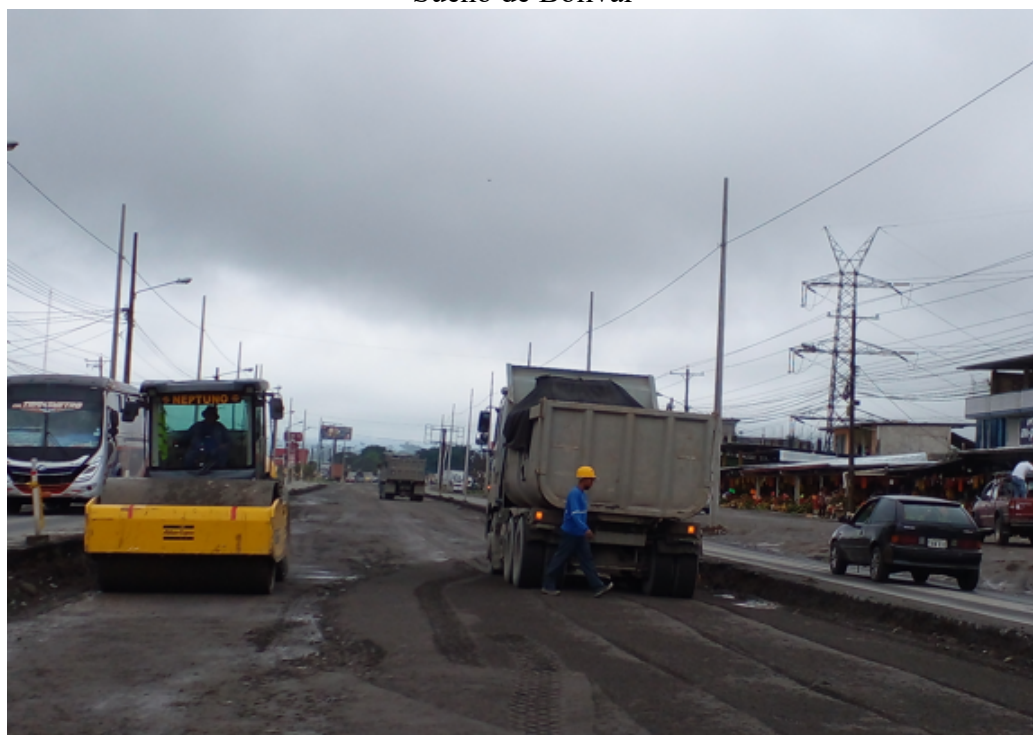
Volqueta transportando el material pétreo para el relleno de la cajonera sector KFC – Sueño de Bolívar
