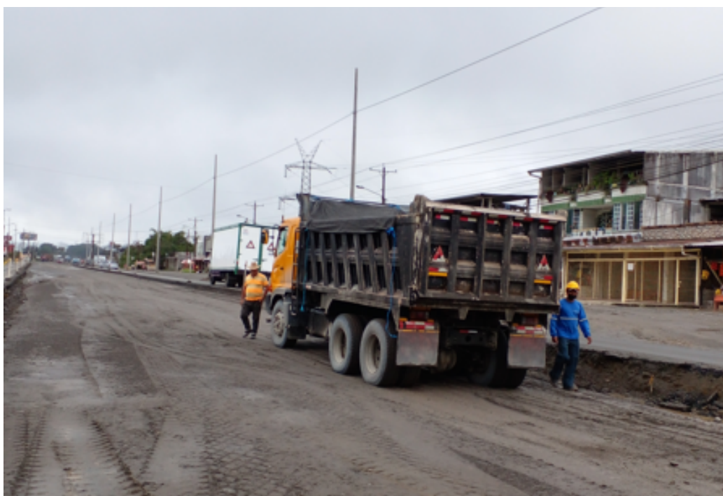
Volqueta transportando el material pétreo para el relleno de la cajonera sector KFC – Sueño de Bolívar
