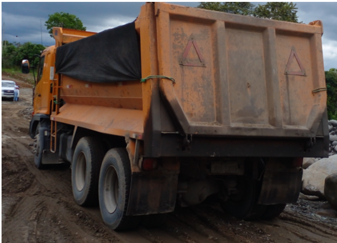
Volquete transportando el material pétreo para el relleno construcción del puente
