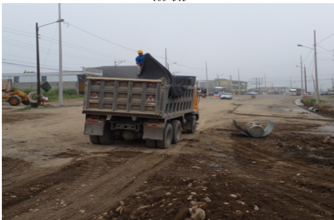
Volqueta transportando el material pétreo para el relleno de la alcantarilla abscisa 100+515
