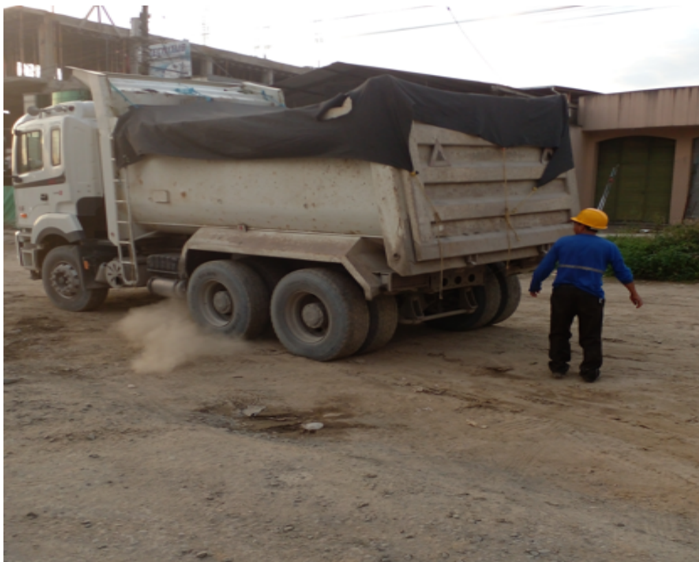
Volquete transportando el material pétreo para el relleno de la alcantarilla abscisa 100+515
