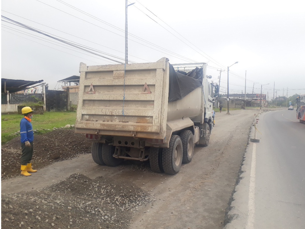
Volqueta transportando el material pétreo al proyecto con su respectiva lona
