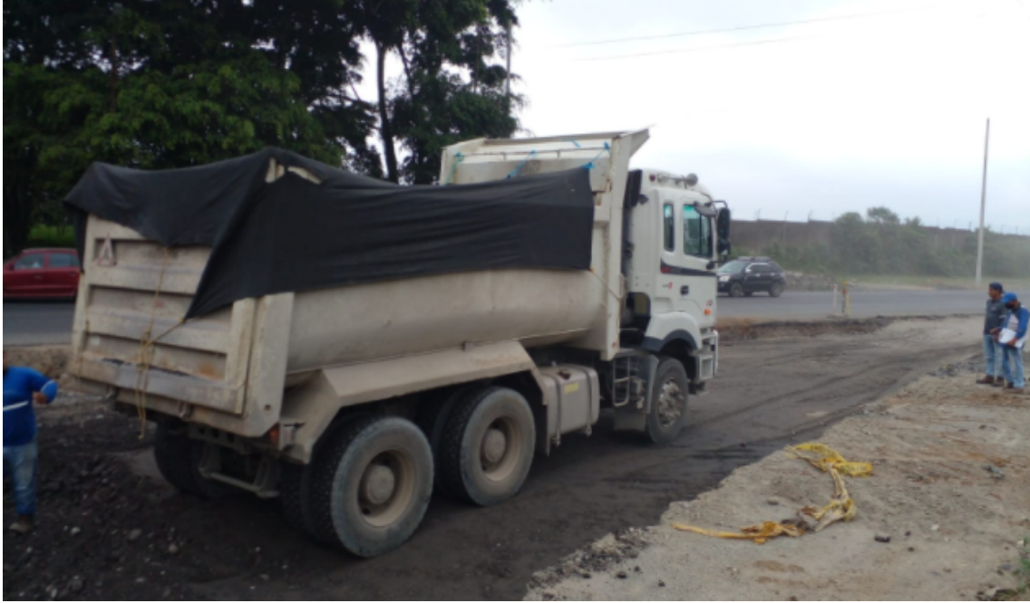
Volqueta transportando el material pétreo para el relleno de la cajonera de la entrada a la Av. Yamboya.
