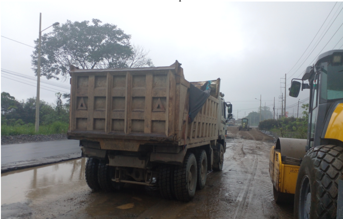
Volqueta transportando el material pétreo para el relleno de la cajonera sector Los Ocampo
