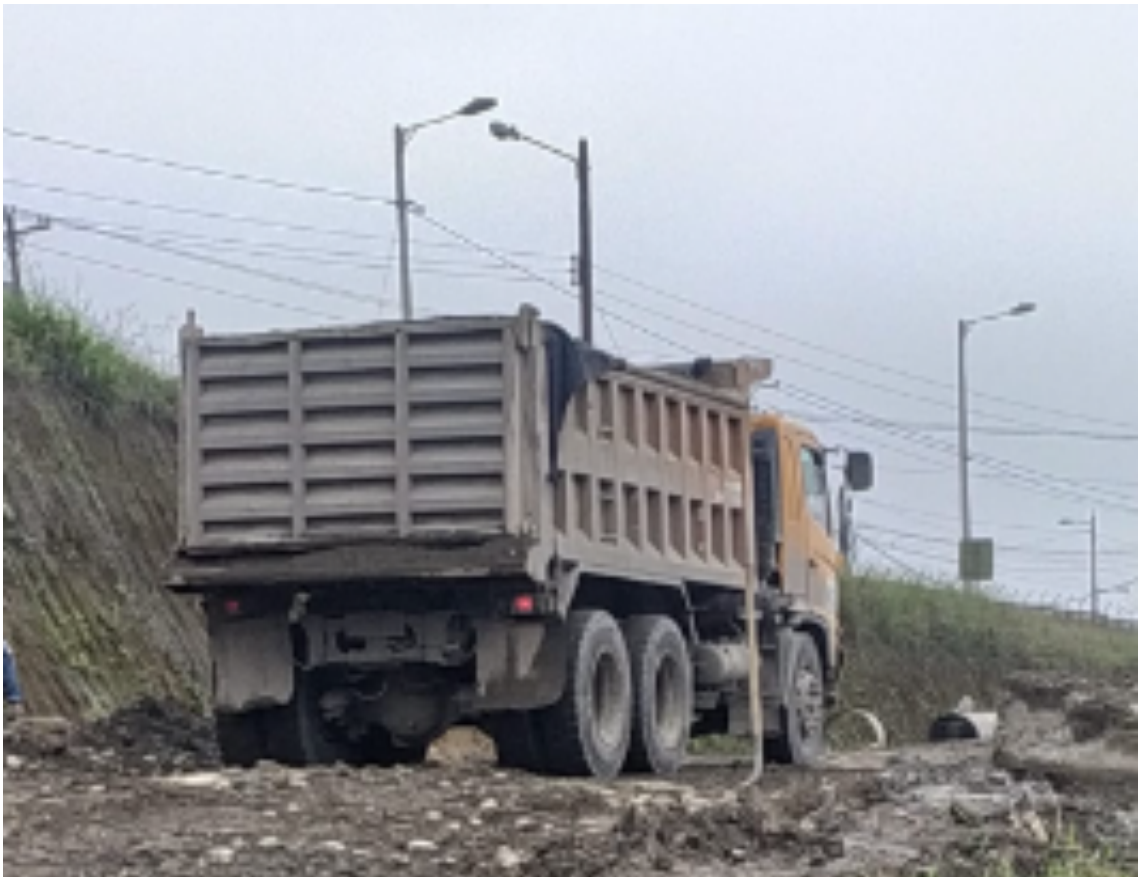
Volqueta transportando el material pétreo para el relleno de la cajonera sector El Paraíso
