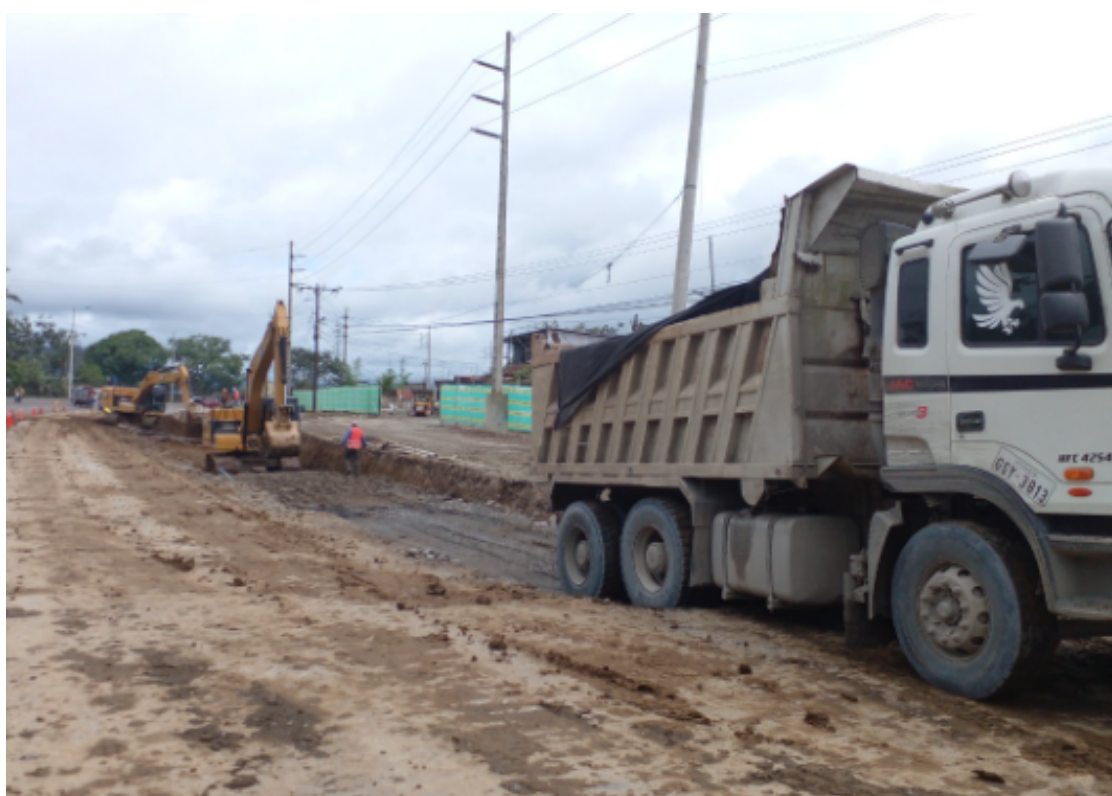
Volqueta transportando el material pétreo para el relleno de la cajonera sector el Colibrí
