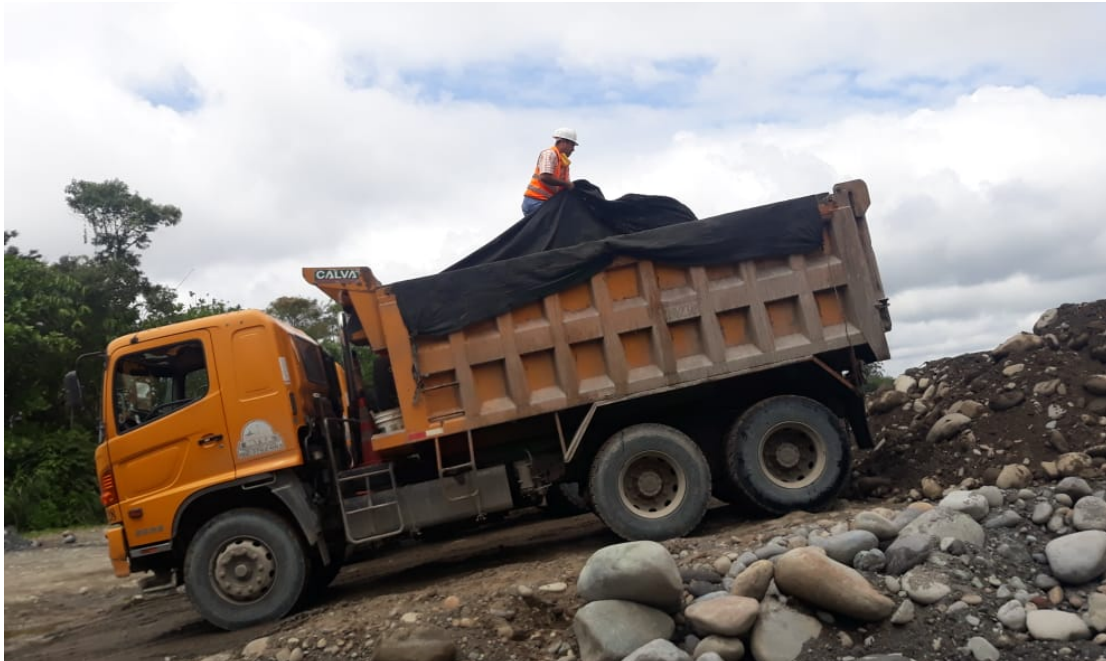
Volquete transportando el material pétreo para el relleno en la construcción del puente
