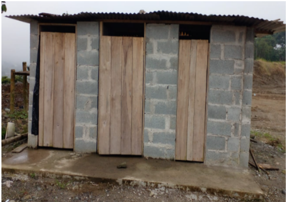
Baterías sanitarias fijas empleadas en el campamento
