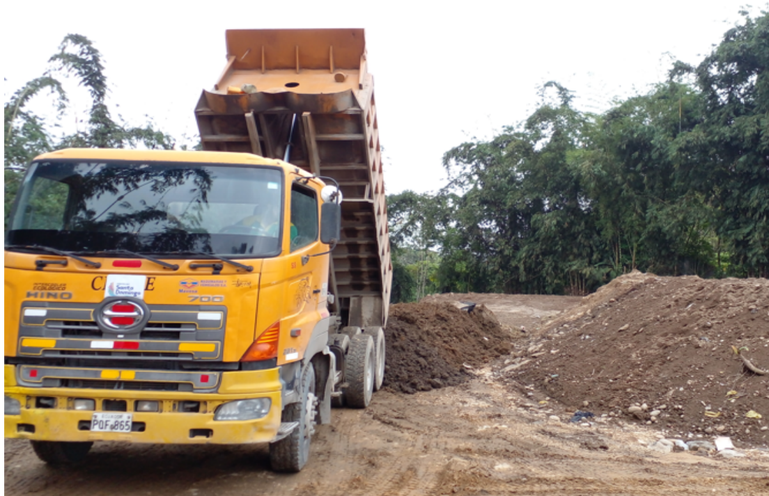
Escombrera autorizada desalojo de escombros (tierra)
