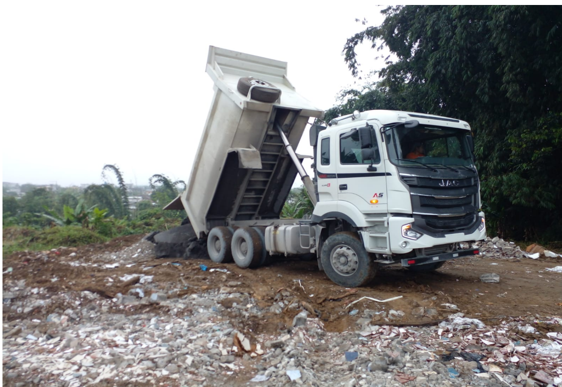
Escombrera autorizada desalojo de escombros (restos de asfalto)
