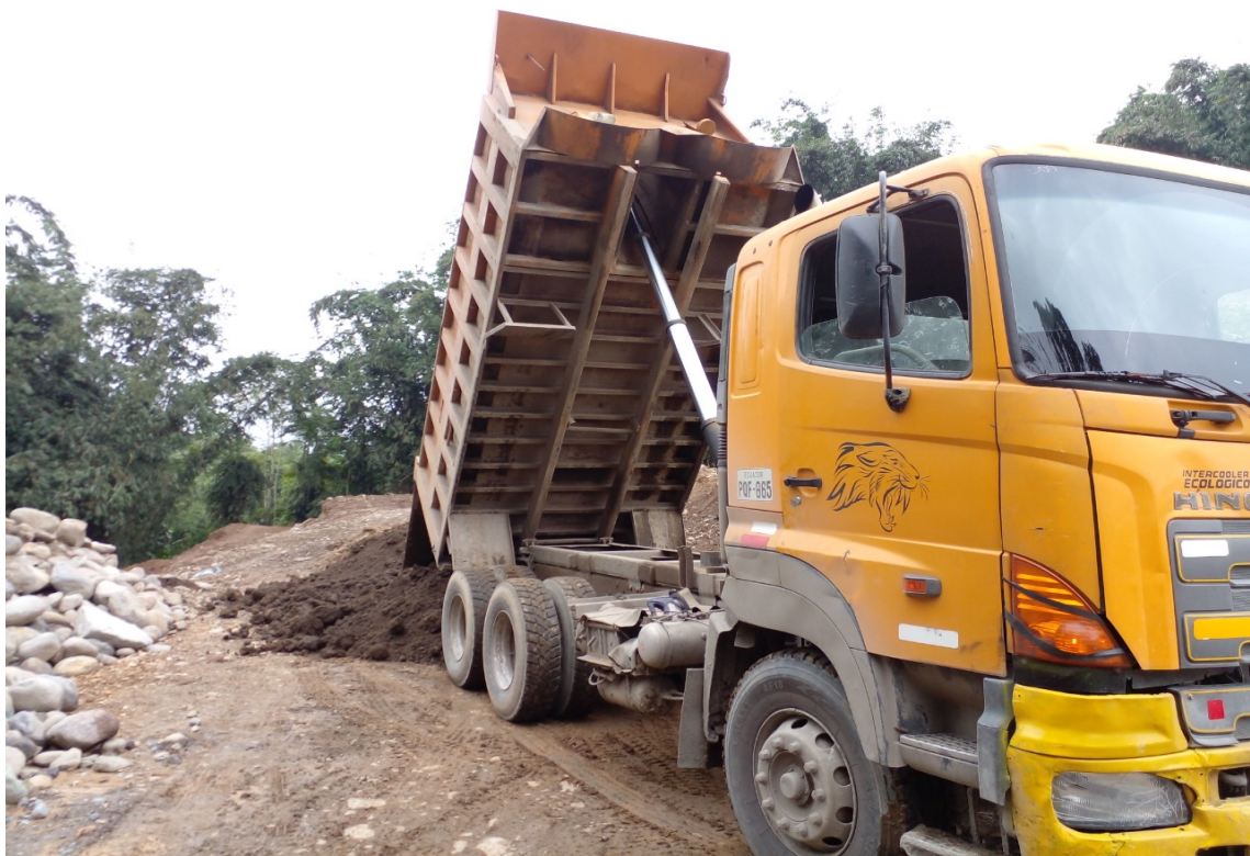
Escombrera autorizada desalojo de escombros (tierra)
