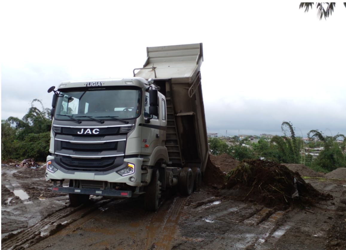
Escombrera autorizada desalojo de escombros (tierra)
