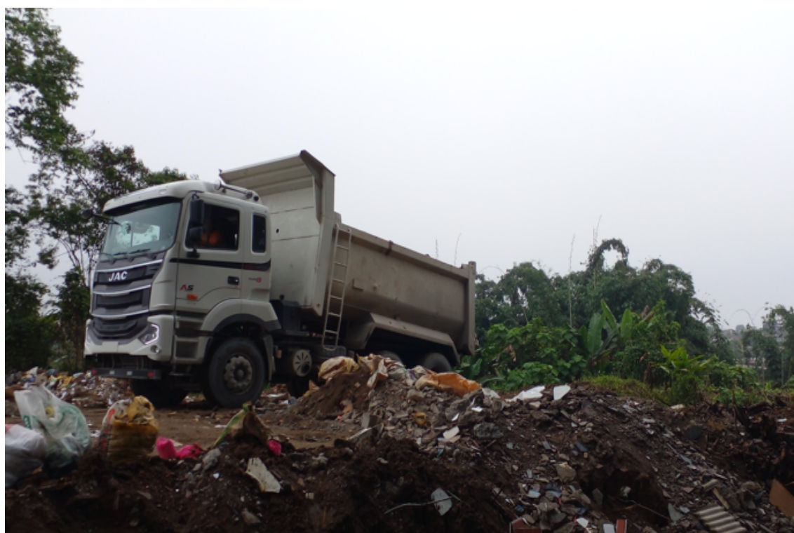
Escombrera autorizada desalojo de escombros (tierra)
