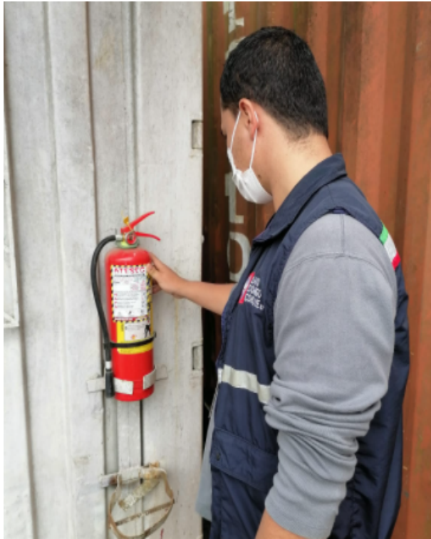
Colocación de extintor de 10 lbs clase ABC (PQS) como medio de extinción
