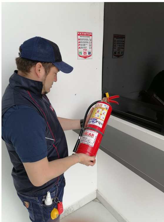
Inspección visual de extintor de 10 lbs clase ABC (PQS) como medio de extinción
