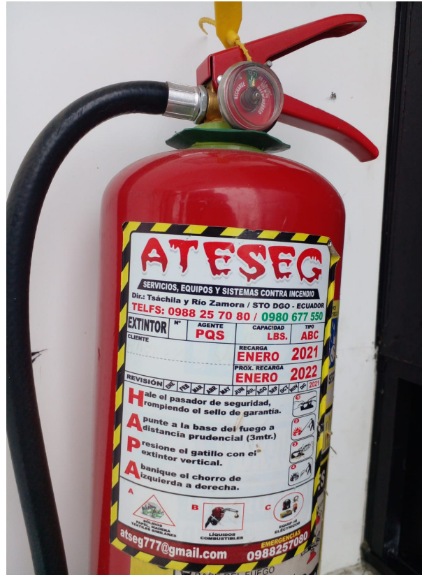
Extintor de 10 lbs clase ABC señalizado y vigente
