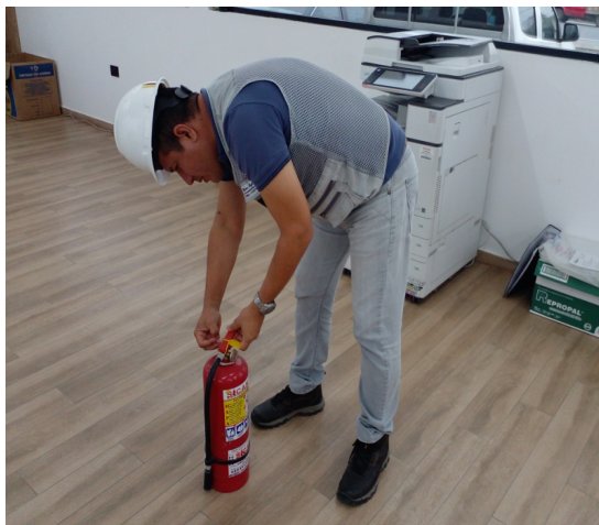
Colocación de extintor de 10 lbs clase ABC (PQS) como medio de extinción
