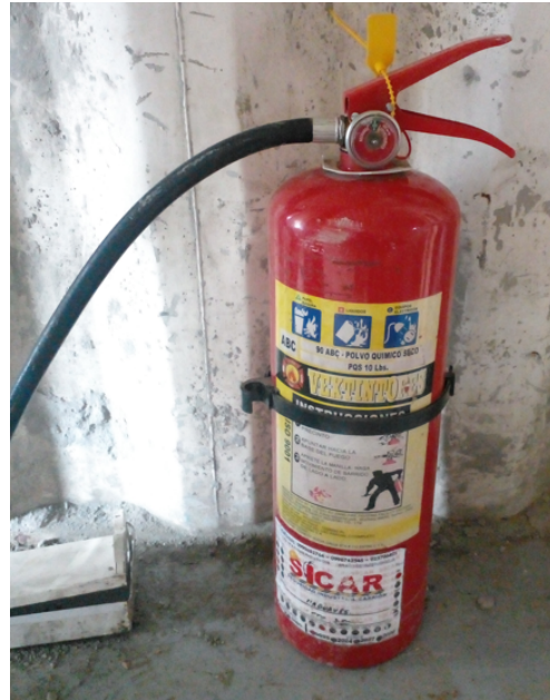
Extintor de 10 lbs clase ABC señalado y vigente
