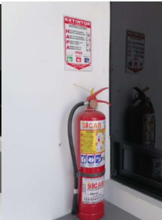
Inspección visual de extintor de 10 lbs clase ABC (PQS) como medio de extinción
