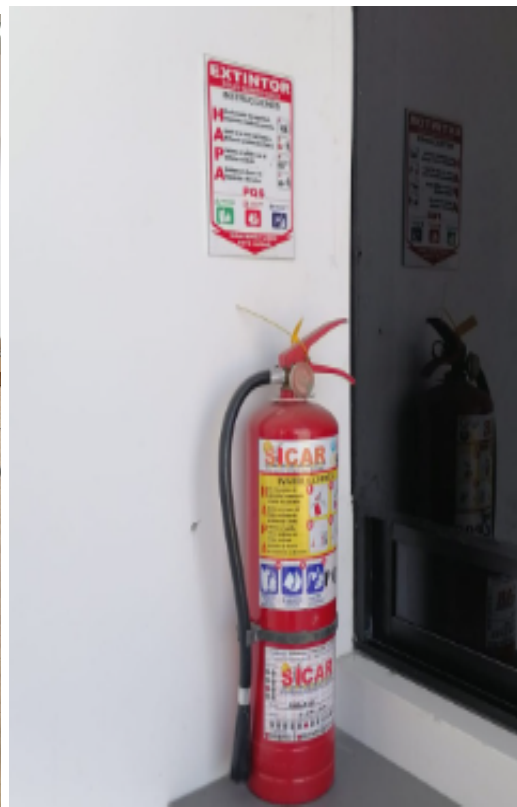
Extintor de 10 lbs clase ABC señalizado y vigente
