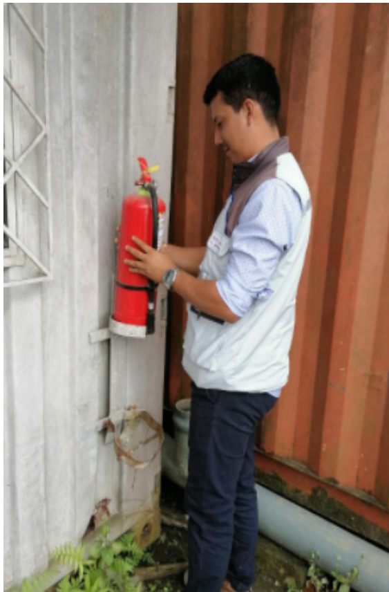
Extintor de 10 lbs clase ABC señalizado y vigente
