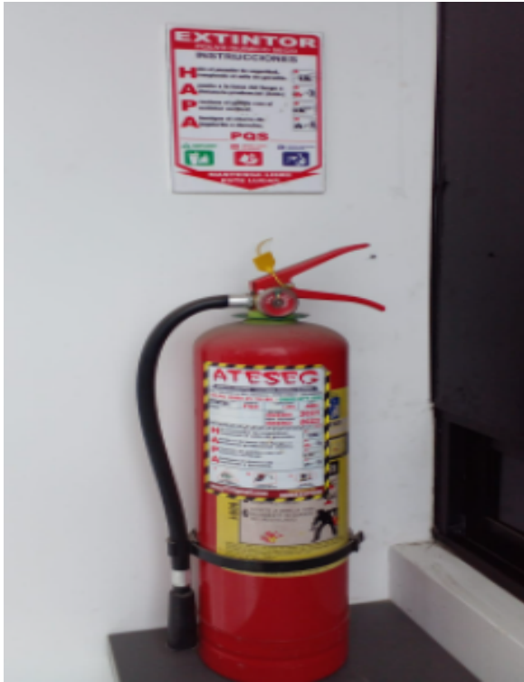
Colocación de extintor de 10 lbs clase ABC (PQS) como medio de extinción
