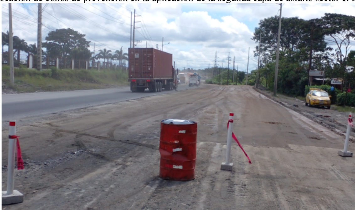
Colocación de señalización prevención en la conformación de la base para posterior asfaltado
