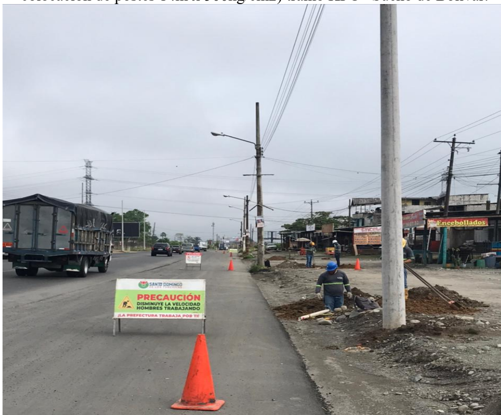
Colocación de conos en la vía en el frente de obra (excavación de huecos para colocación de postes 14m x 500kg/cm 2 ) tramo KFC –Sueño de Bolívar.
