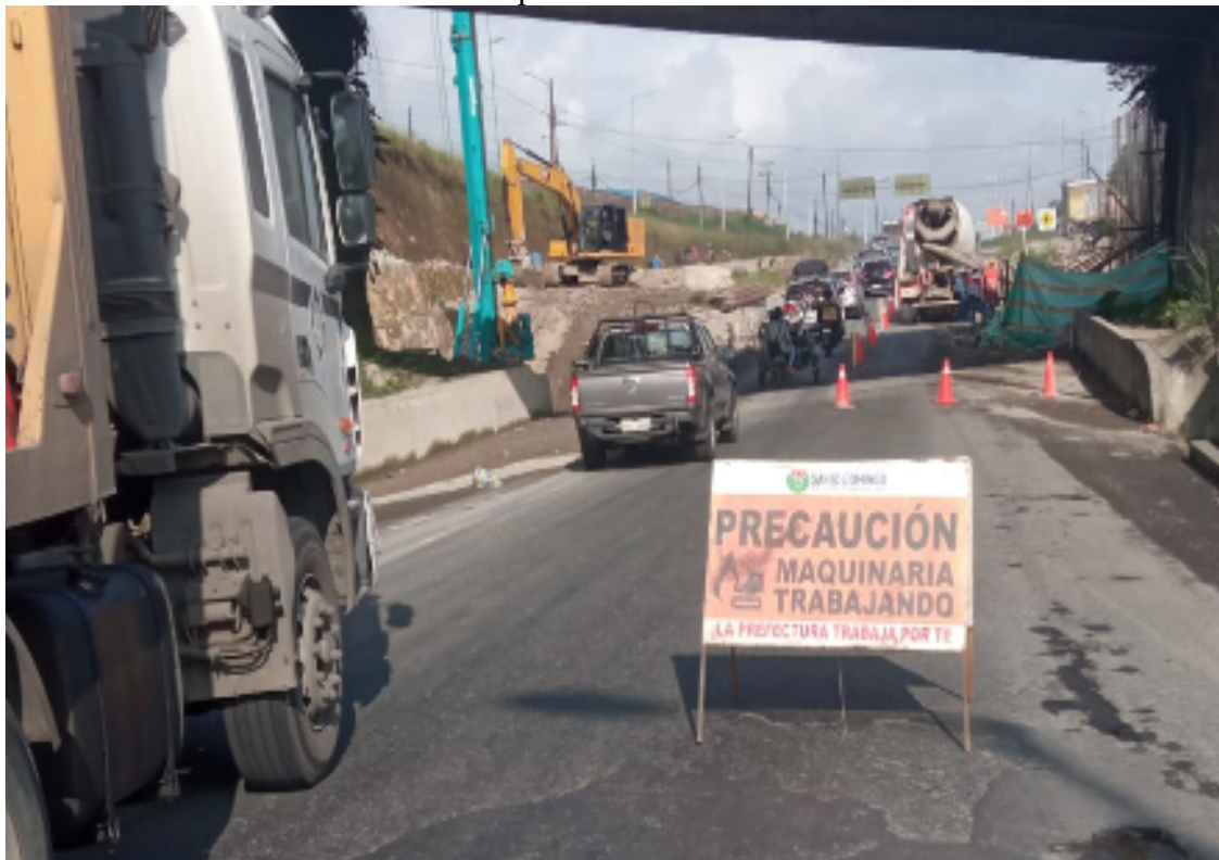
Colocación de conos de prevención en la perforación de los pilotes de acceso al puente
