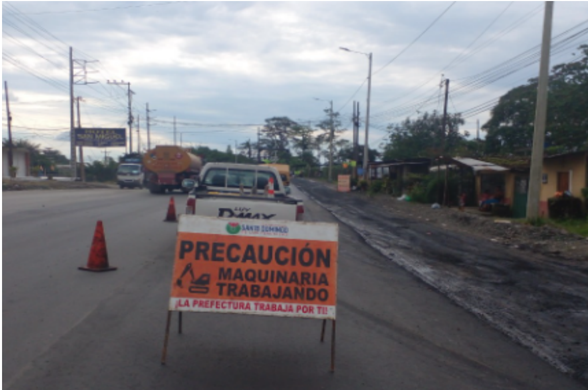
Colocación de señalización preventiva en la aplicación de la carpeta asfáltica sector TURIS-KOL
