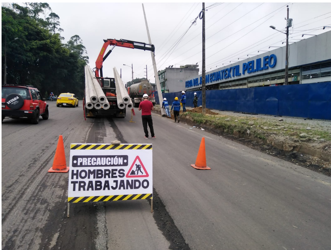
Colocación de letreros de prevención en el frente de obra (colocación de postes 14m x 500kg/cm 2 ) margen derecho sector feria de Pelileo
