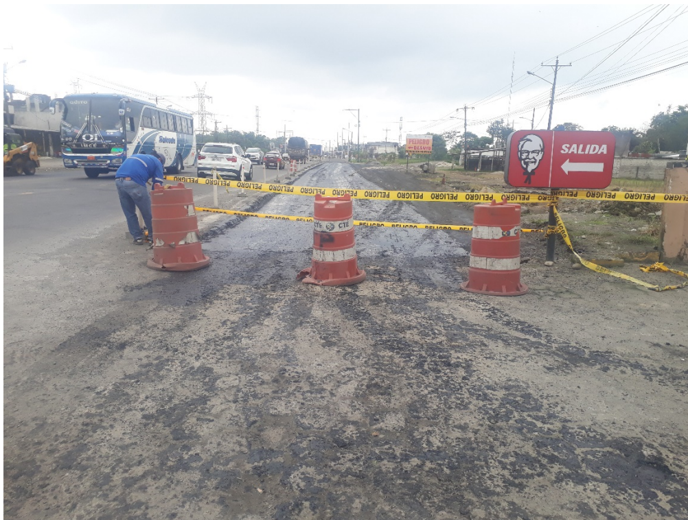
Colocación de señalización -Sector KFC
