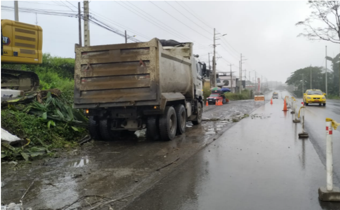
Colocación de conos de prevención en la excavación de la cajonera para mejorar el suelo y continuar con la ampliación de la vía
