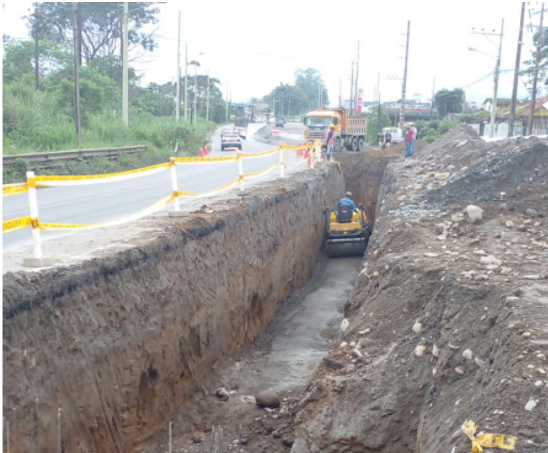
Colocación de cinta de peligro y conos de prevención en la colocación de tubería corrugada para la construcción del alcantarillado pluvial.
