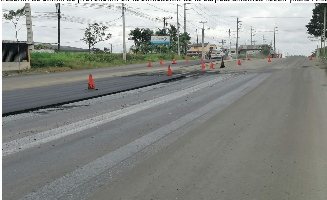
Colocación de conos de prevención en la colocación de la carpeta asfáltica sector plaza Asturias.
