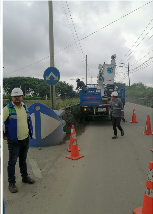
Colocación de conos en la vía en el frente de obra (instalación de luminarias)
