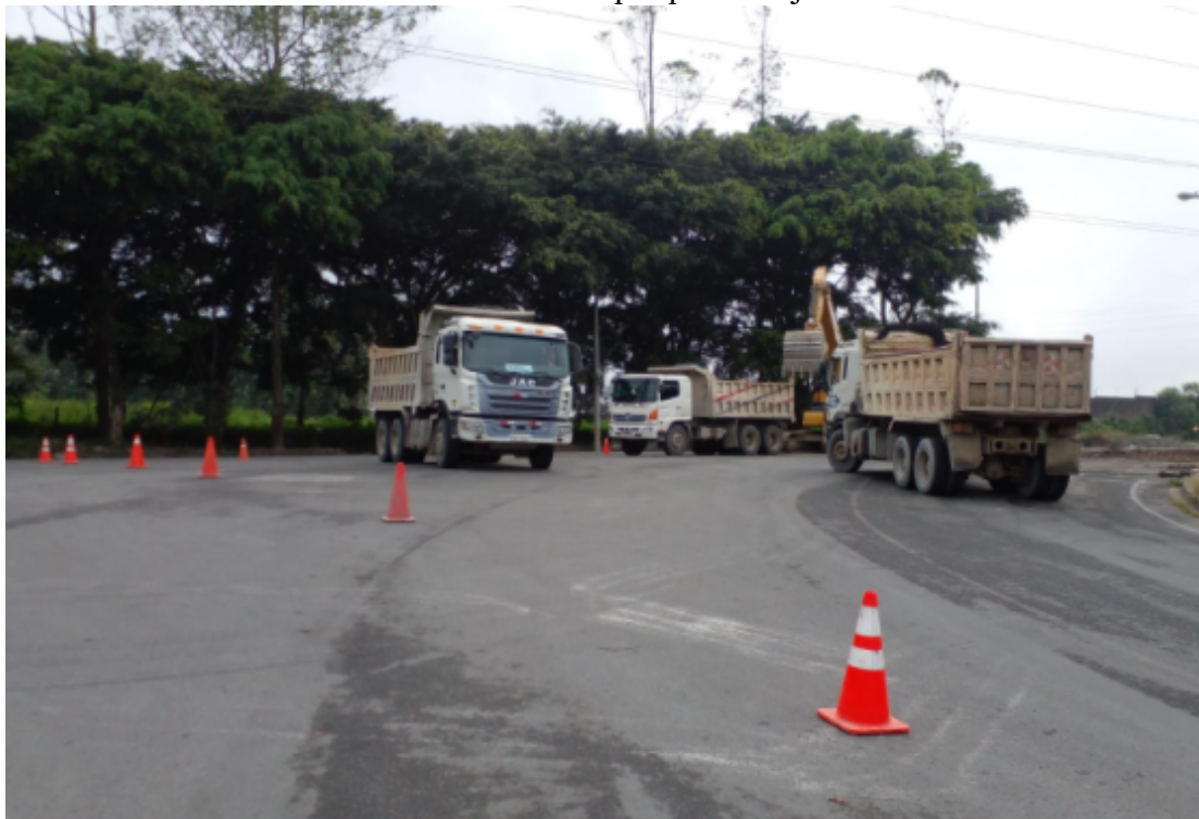
Colocación de conos en la vía en el frente de obra (corte de la cajonera de la entrada de la Av. Yamboya).
