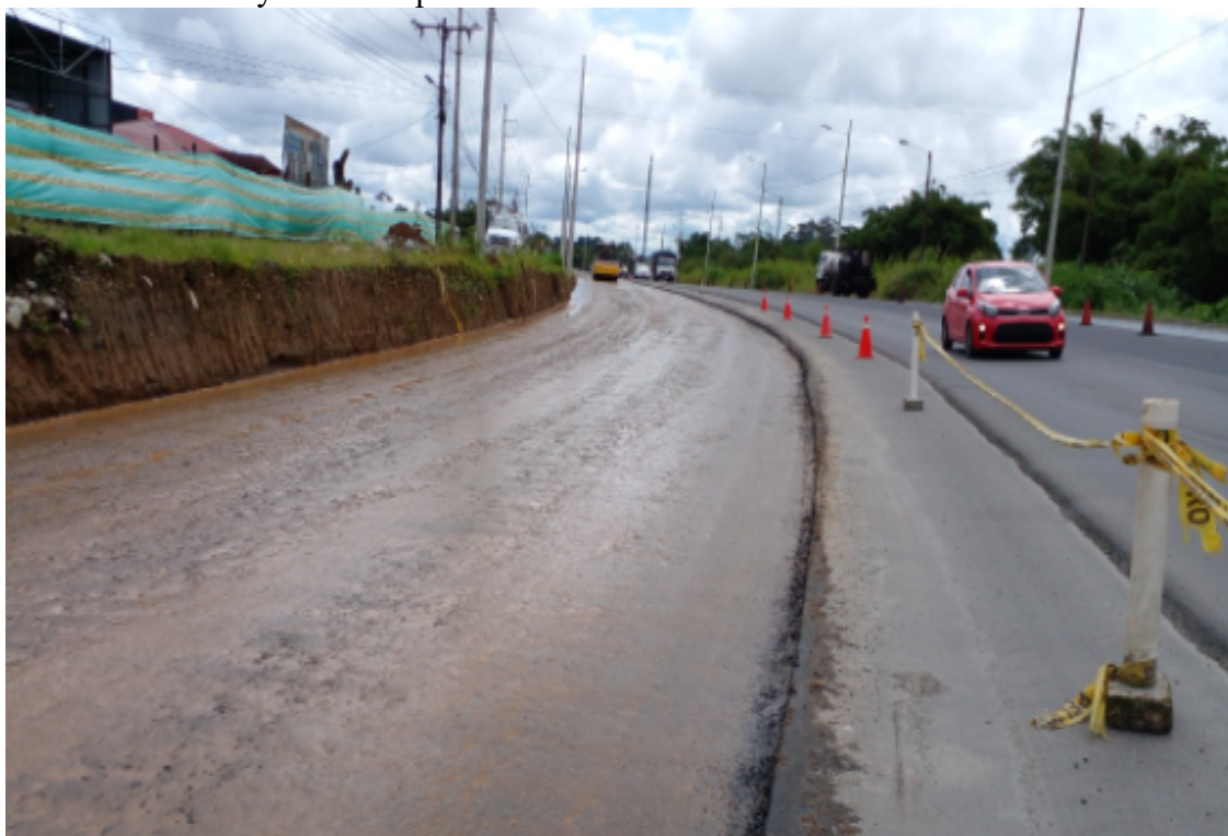
Colocación de señalización preventiva conos y cinta de peligro en el tendido y sellado de base sector TURIS-KOL
