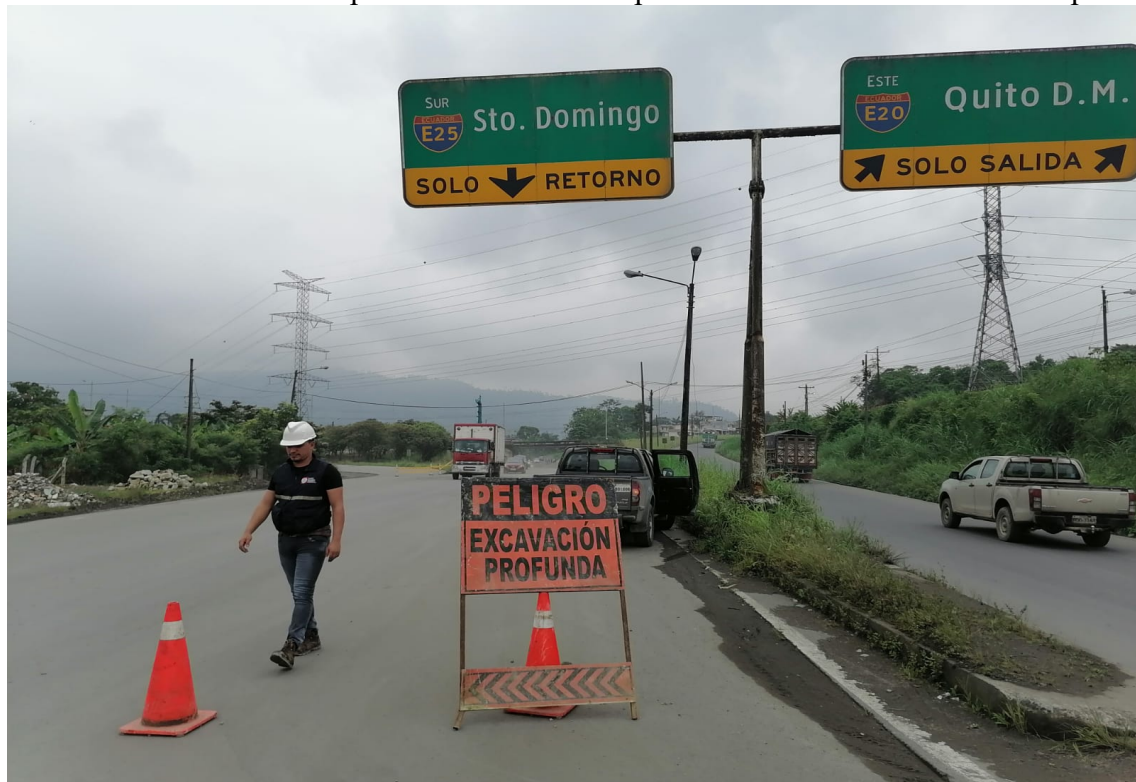
Colocación de señalización preventiva en el corte para el acceso a la cimentación al puente
