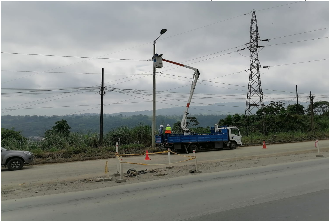
Colocación de conos en la vía en el frente de obra (instalación de luminarias)
