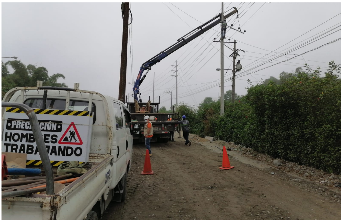
Colocación de conos en la vía en el frente de obra (colocación de estructura trifasica retencion volado VP 14) tramo KFC –Sueño de Bolívar.
