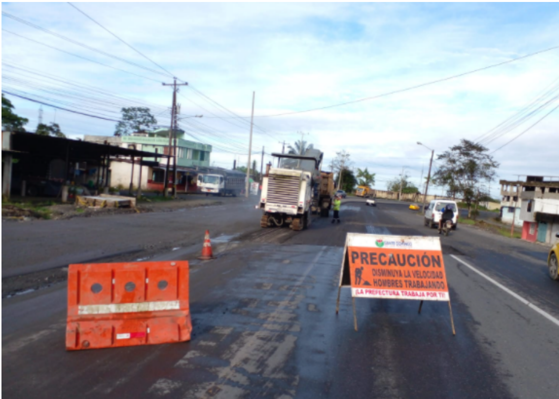
Colocación de letreros de prevención en el frente de obra (fresado de carpeta asfáltica existente abscisa 94+750) carril central tramo KFC –Sueño de Bolívar.
