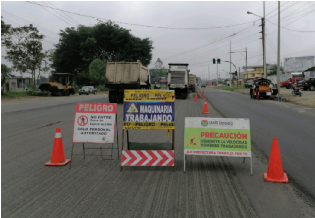
Colocación de letreros de prevención en el frente de obra (fresado de carpeta existente abscisa 98+600) margen izquierdo tramo KFC –Sueño de Bolívar.
