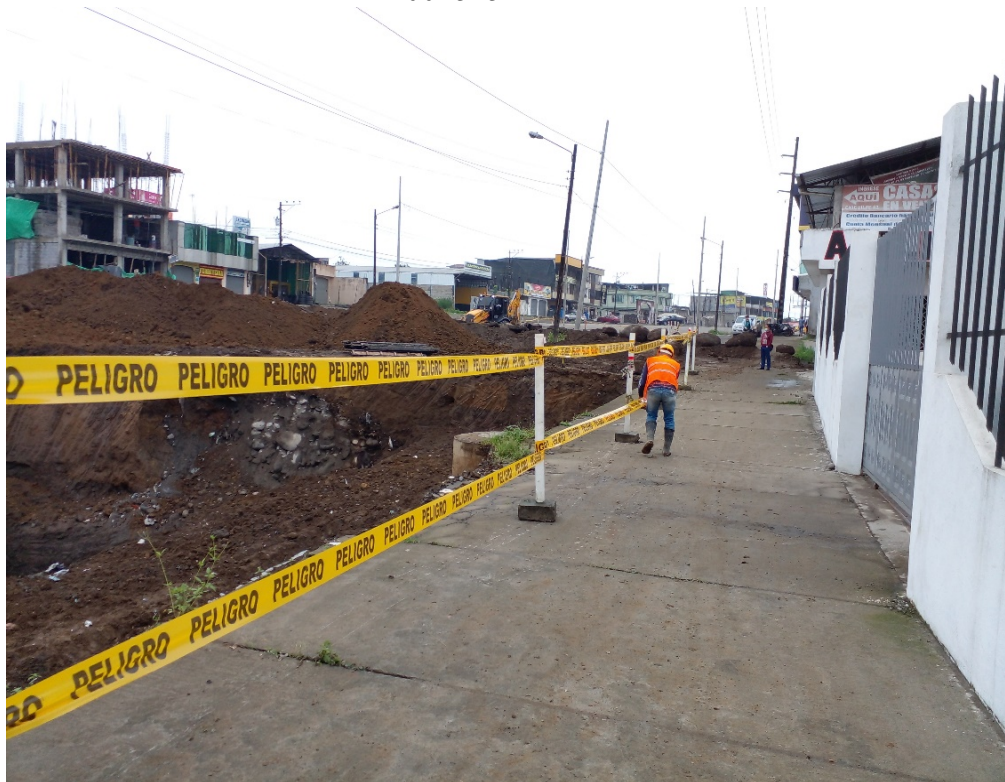
Colocación de cinta de peligro en el corte y excavación para la colocación de alcantarilla ármica abscisa 100+515 KFC – Sueño de Bolívar
