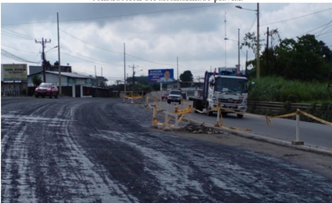
Colocación de cinta de peligro en las tapas de las cámaras del sistema del alcantarillado pluvial.
