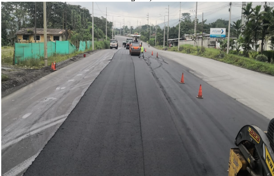
Colocación de conos de prevención en la colocación de la carpeta asfáltica sector plaza Asturias.
