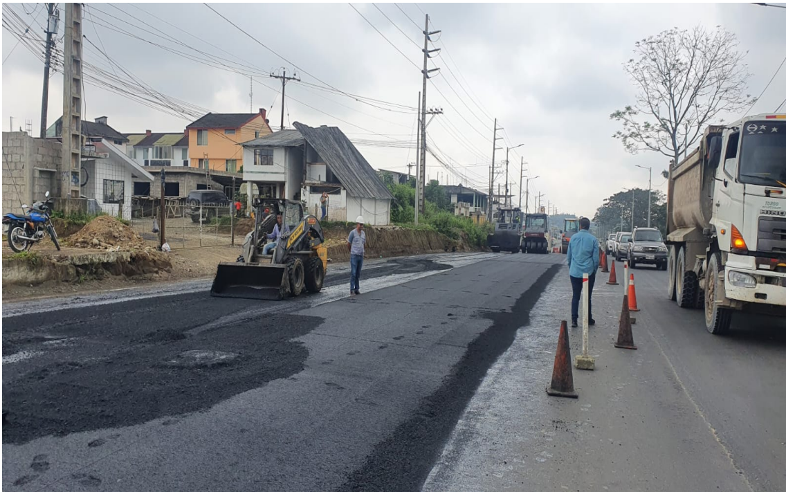
Colocación de conos de prevención en la colocación de la carpeta asfáltica entre el sector portal del lago – plaza Asturias.
