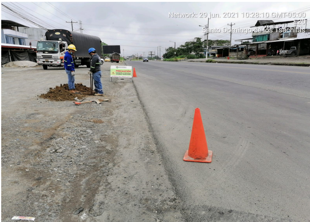
Colocación de conos en la vía en el frente de obra (excavación de huecos para colocación de postes 14m x 500kg/cm 2 ) tramo KFC –Sueño de Bolívar.
