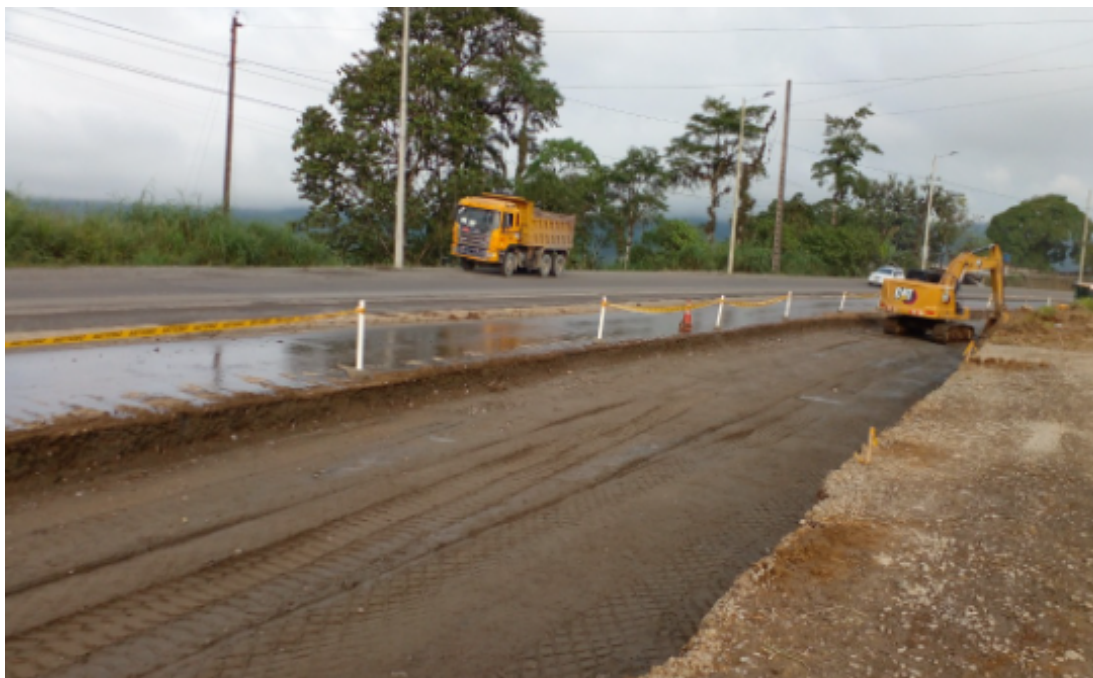
Colocación de cinta de peligro en el corte de la cajonera sector Colibrí.
