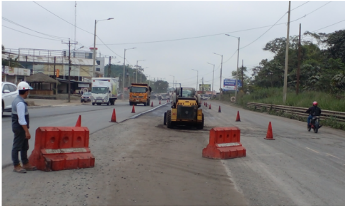
Colocación de conos de prevención en la aplicación de la carpeta asfáltica sector ANT.
