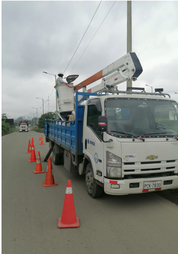
Colocación de conos en la vía en el frente de obra (instalación de luminarias)
