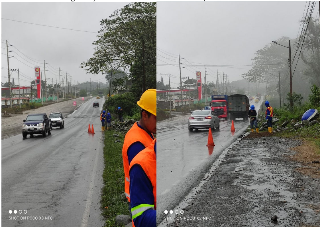
Colocación de conos en la vía en el frente de obra (colocación de postes 14m x 500kg/cm2) tramo Portal del Lago
