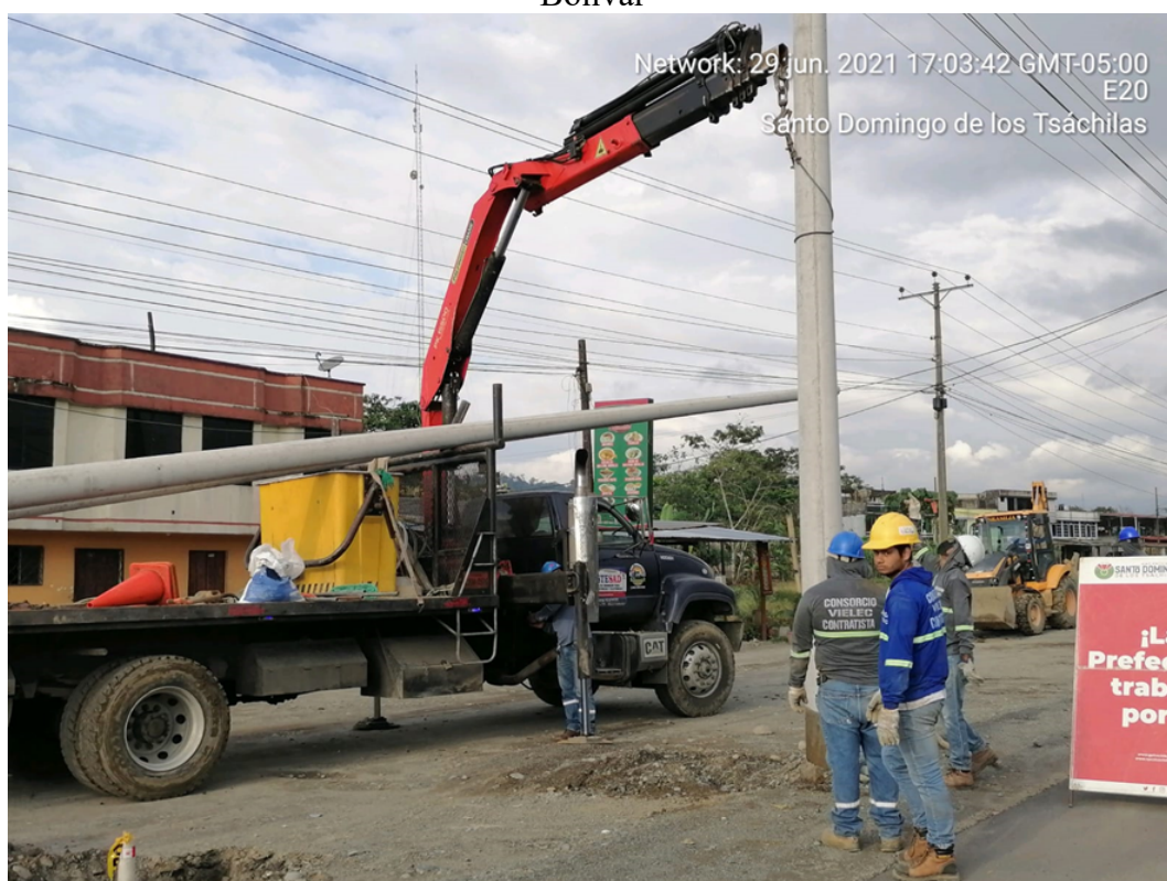
Colocación de letreros de prevención en el frente de obra (excavación de huecos para colocación de postes 14m x 500kg/cm 2 ) margen derecho tramo KFC –Sueño de Bolívar
