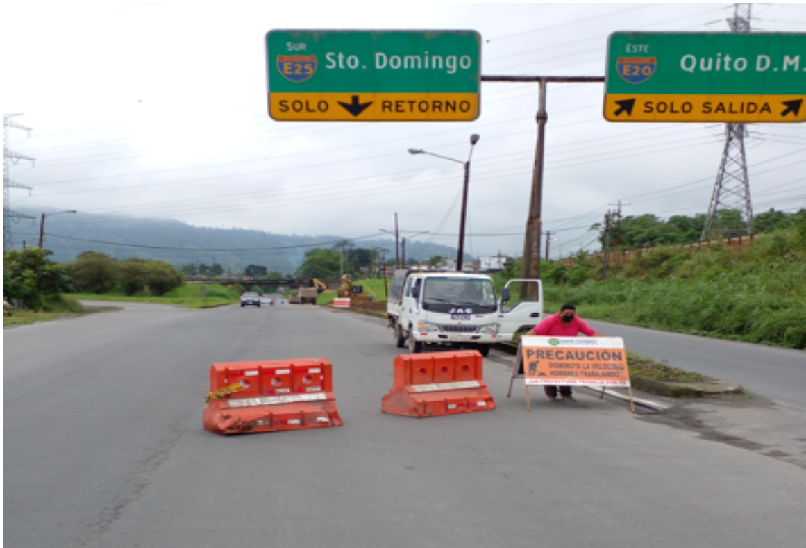
Colocación de señalización preventiva en el corte para el acceso a la cimentación al puente
