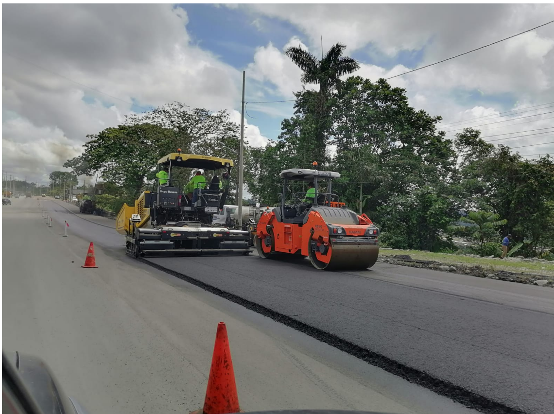
Colocación de conos de prevención en la colocación de la carpeta asfáltica sector plaza Asturias.
