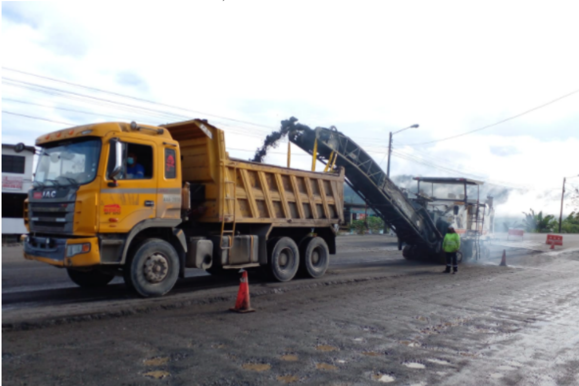
Colocación de letreros de prevención en el frente de obra (fresado de carpeta asfáltica existente abscisa 94+750) carril central tramo KFC –Sueño de Bolívar.
