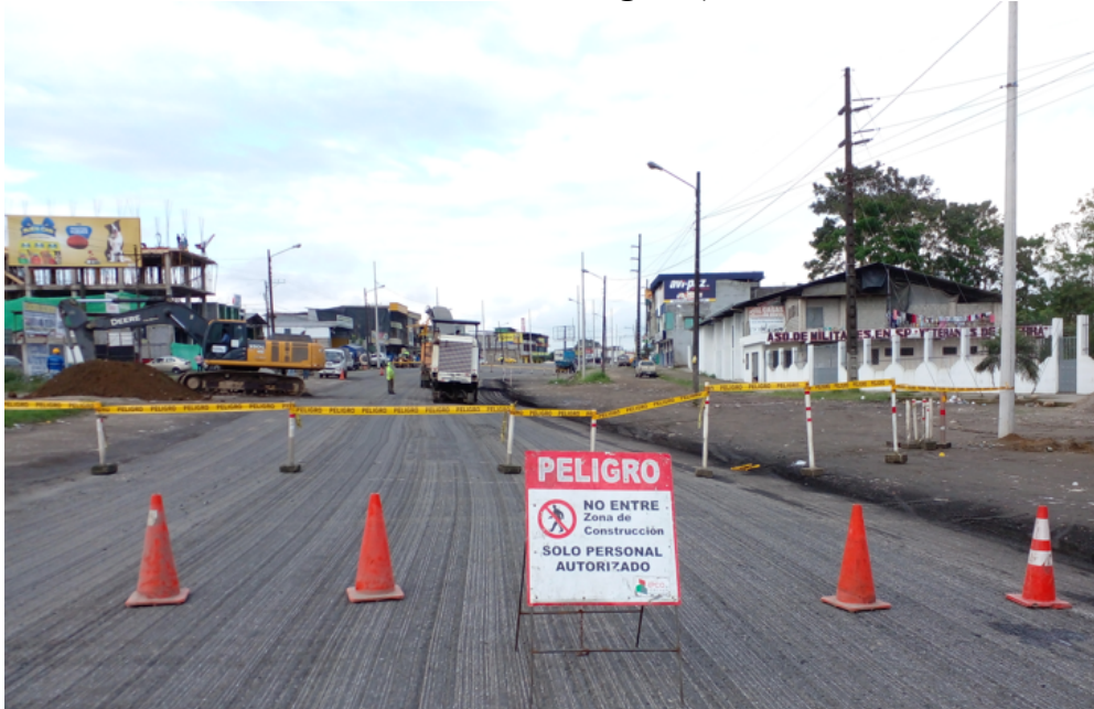
Colocación de cinta de peligro en el fresado y corte para la colocación de alcantarilla ármica abscisa 100+515 KFC – Sueño de Bolívar
