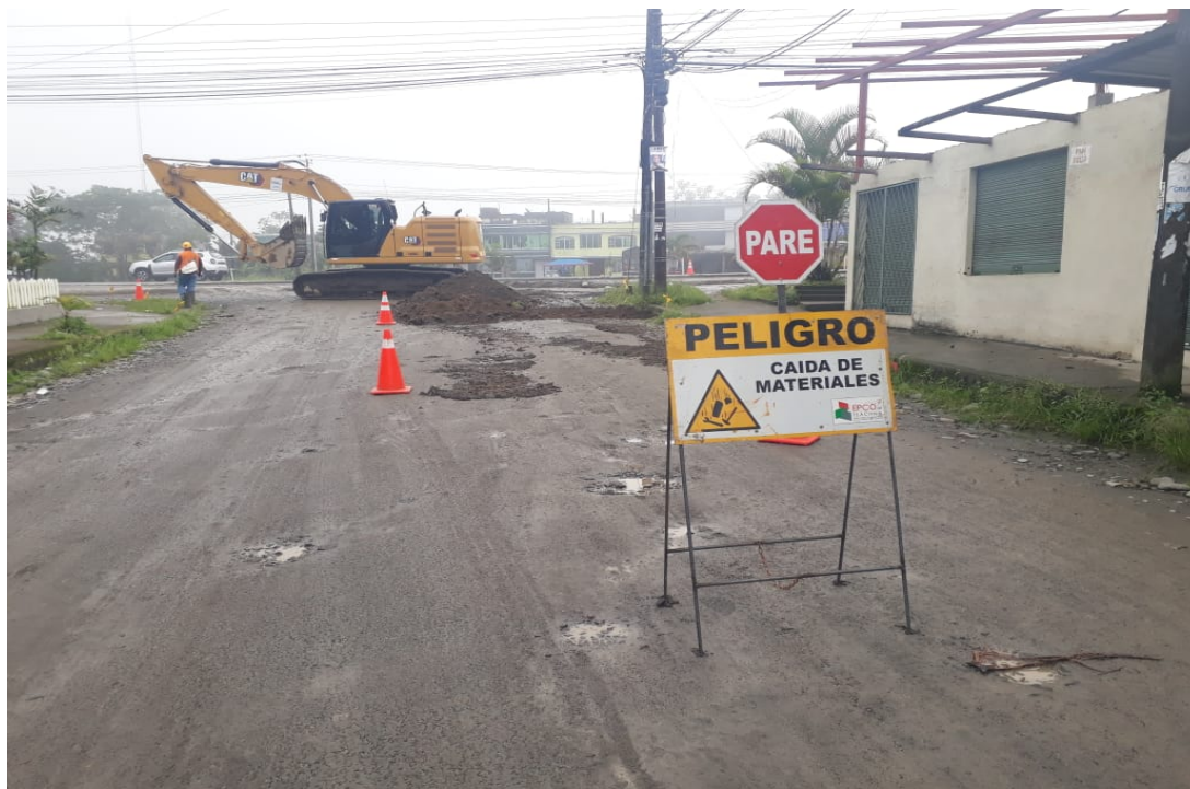
Colocación de letreros de prevención en el frente de obra (colocación de base) tramo KFC –Sueño de Bolívar.
