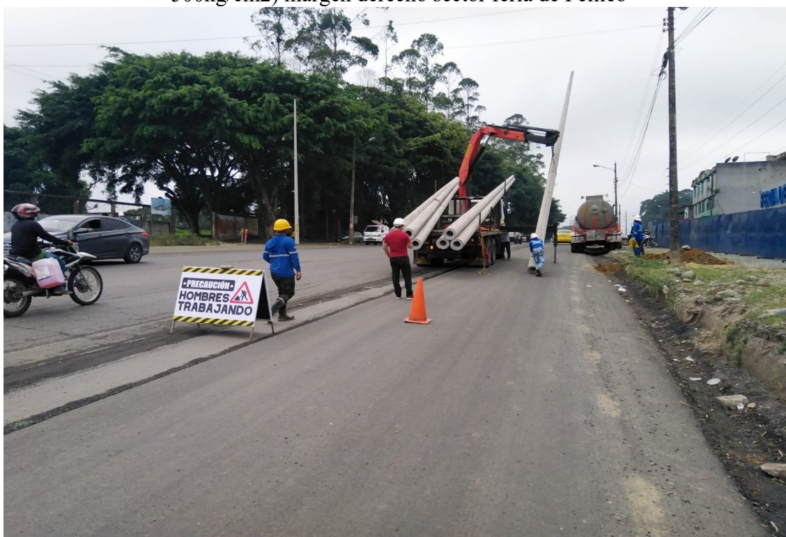
Colocación de letreros de prevención en el frente de obra (colocación de postes 14m x 500kg/cm 2 ) margen derecho sector feria de Pelileo Señalización con conos
