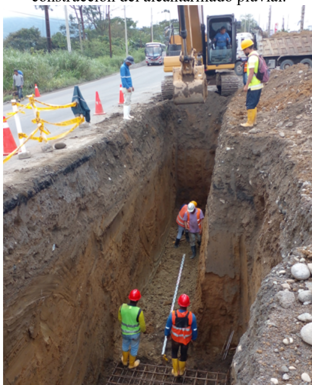
Colocación de cinta de peligro y conos de prevención en la colocación de tubería corrugada para la construcción del alcantarillado pluvial.
