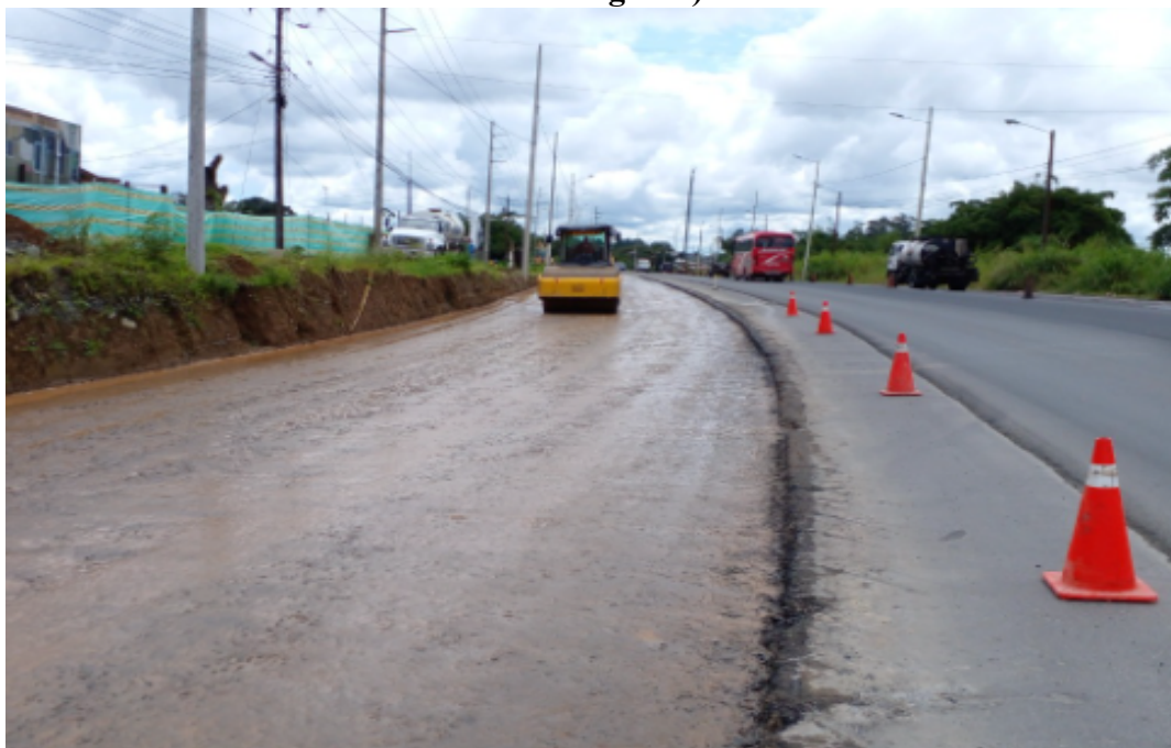
Colocación de conos de prevención en el tendido y sellado de base lado izquierdo sector TURIS-KOL.
