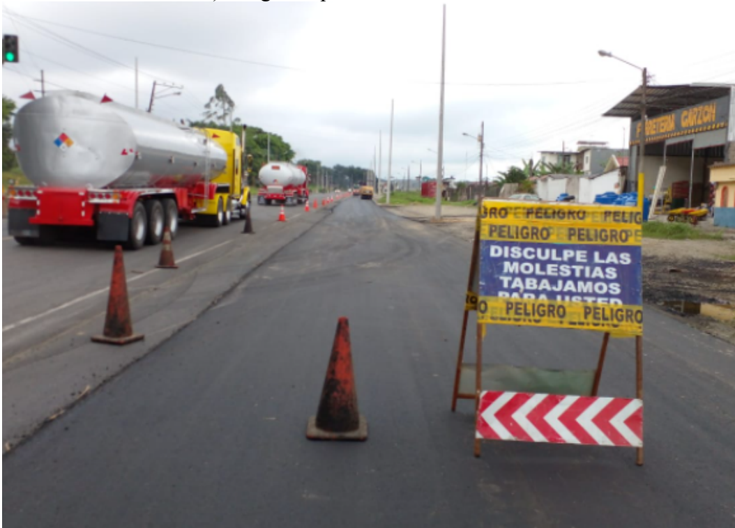
Colocación de letreros de prevención en el frente de obra (aplicación de carpeta asfáltica abscisa 98+580) margen izquierdo tramo KFC –Sueño de Bolívar.
