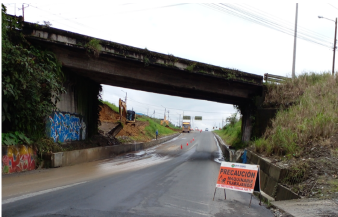
Colocación de letrero y conos de prevención en el corte para el acceso a la cimentación al puente
