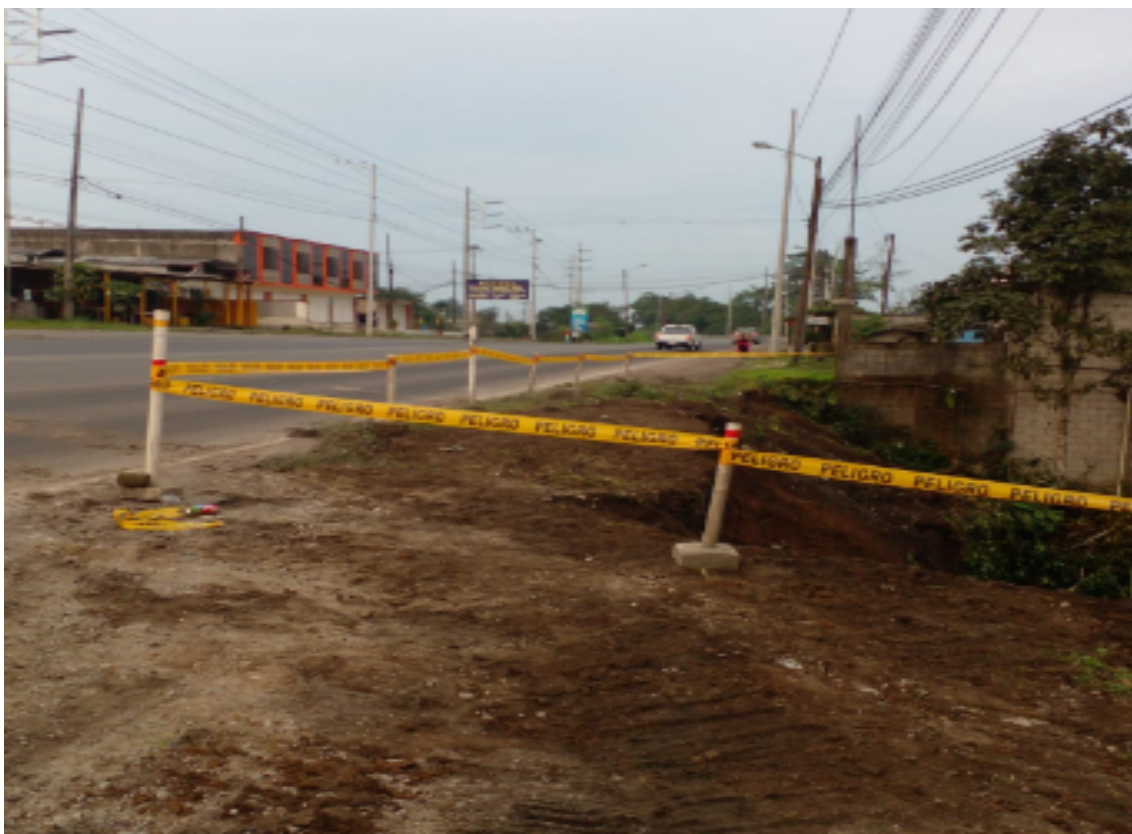
Colocación de cinta de peligro en la excavación para el muro ciclópeo abscisa 95+380.
