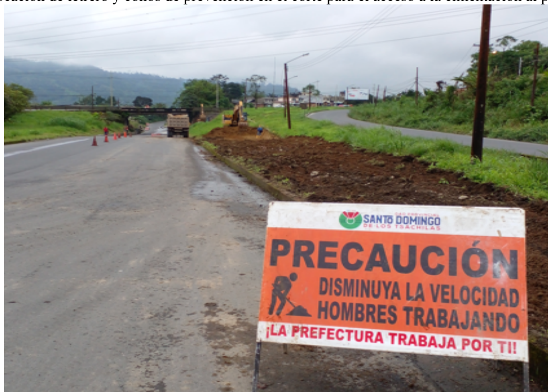
Colocación de letrero y conos de prevención en el corte para el acceso a la cimentación al puente
