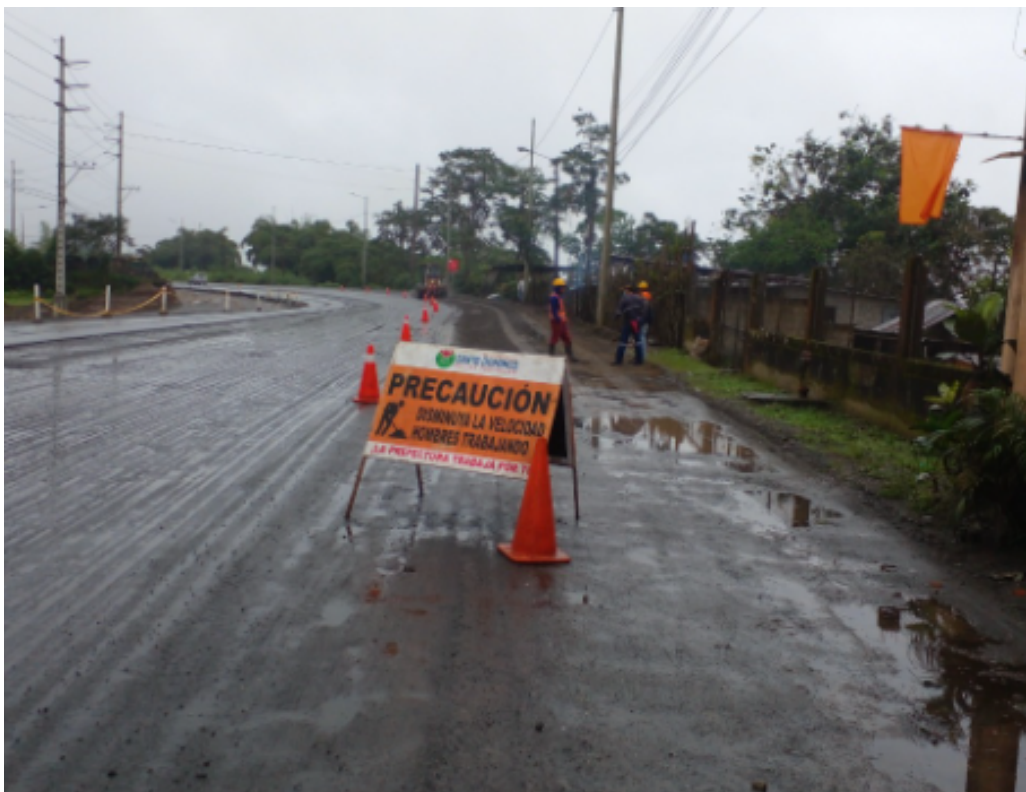
Colocación de letrero y conos de prevención en el reconformado de la base sector TURIS-KOL.
