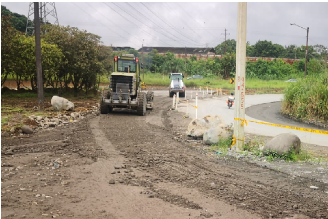
Colocación de señalización preventiva en el paso provisional de desvío
