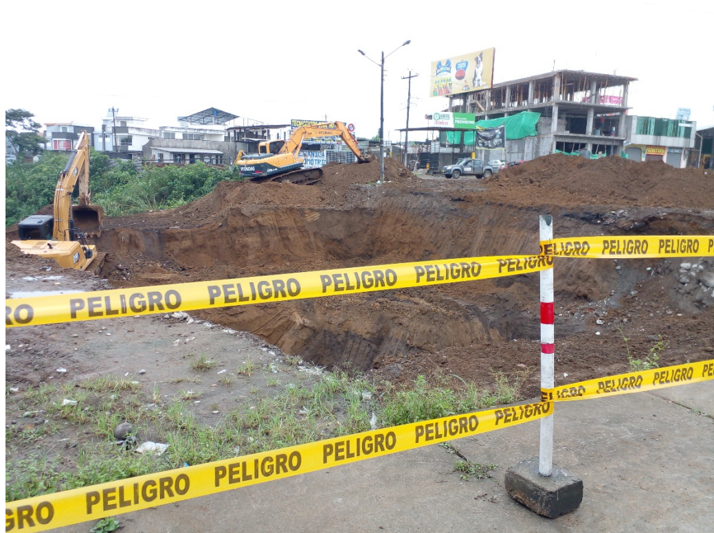
Colocación de conos en la vía en el frente de obra (cajera entrada a las mercedes abscisa 98+370) margen derecho tramo KFC –Sueño de Bolívar.
