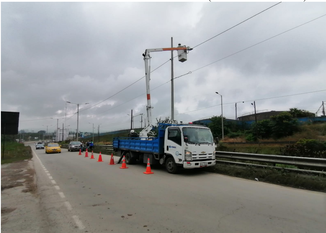
Colocación de conos en la vía en el frente de obra (instalación de luminarias)
