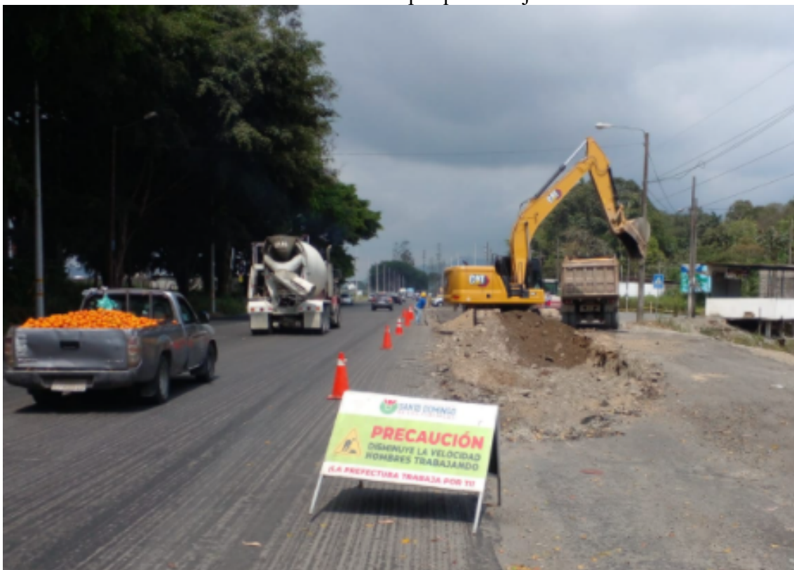
Colocación de letreros de prevención en el frente de obra (corte de la cajonera de la entrada a la Av. Yamboya).
