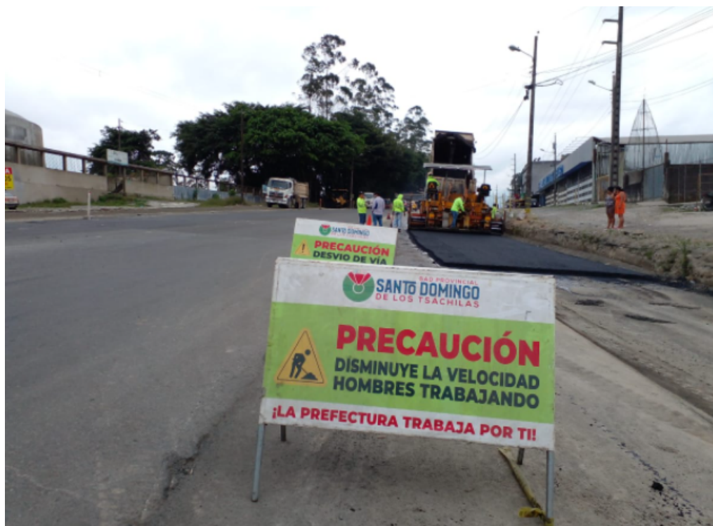
Colocación de letreros de prevención en el frente de obra (aplicación de la carpeta asfáltica abscisa 99+800) margen izquierdo tramo KFC –Sueño de Bolívar.
