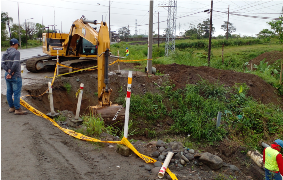
Colocación de cinta de peligro en la excavación para posterior protección de la tubería de agua potable
