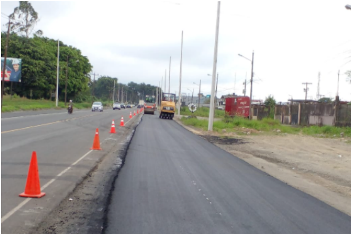
Colocación de conos en la vía en el frente de obra (aplicación de la carpeta asfáltica abscisa 98+560) margen izquierdo tramo KFC –Sueño de Bolívar.
