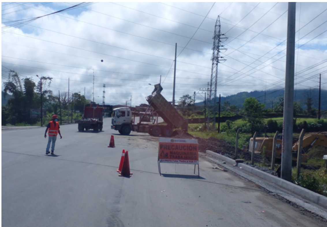
Colocación de letrero y conos de prevención en el relleno con subbase para la protección de la tubería de agua potable
