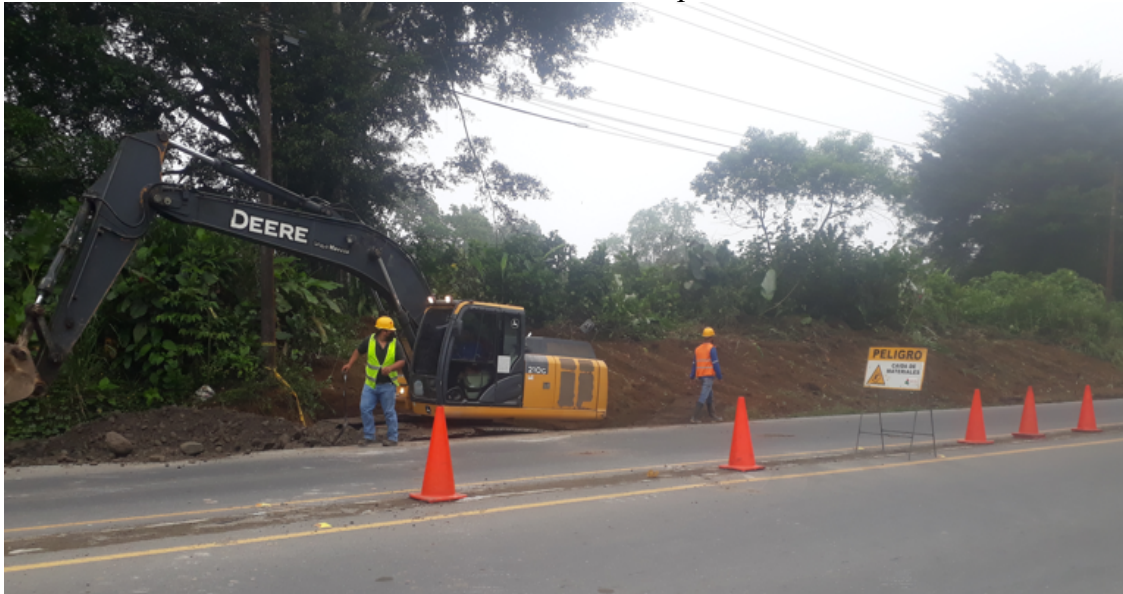
Colocación de letreros de prevención en el frente de obra corte de la cajonera en el intercambiador hacia el parque de la juventud.
