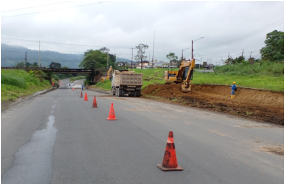
Colocación de señalización preventiva en el desalojo de material del puente.
