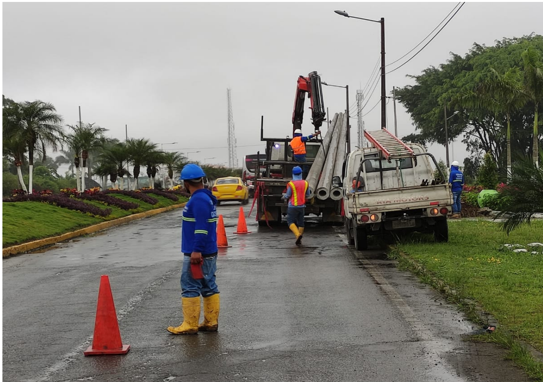
Colocación de conos en la vía en el frente de obra (colocación de postes 14m x 500kg/cm2) tramo intercambiador al Parque de la Juventud.
