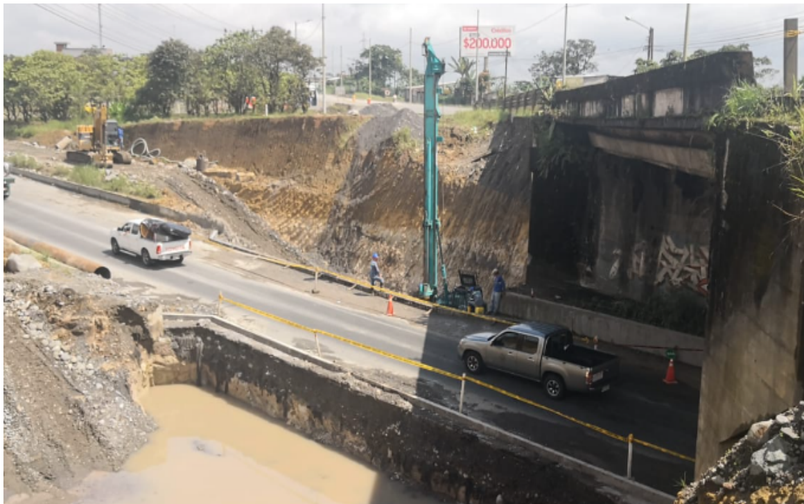
Colocación de señalización preventiva en la perforación de los pilotes del puente
