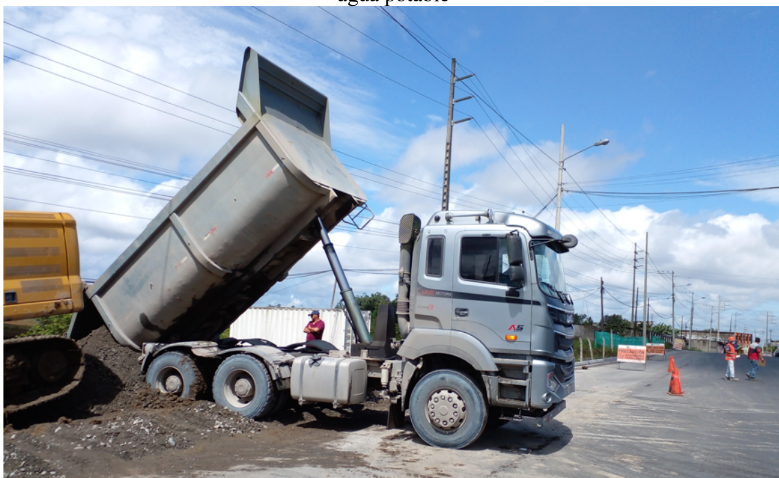
Colocación de letrero y conos de prevención en el relleno con subbase para la protección de la tubería de agua potable
