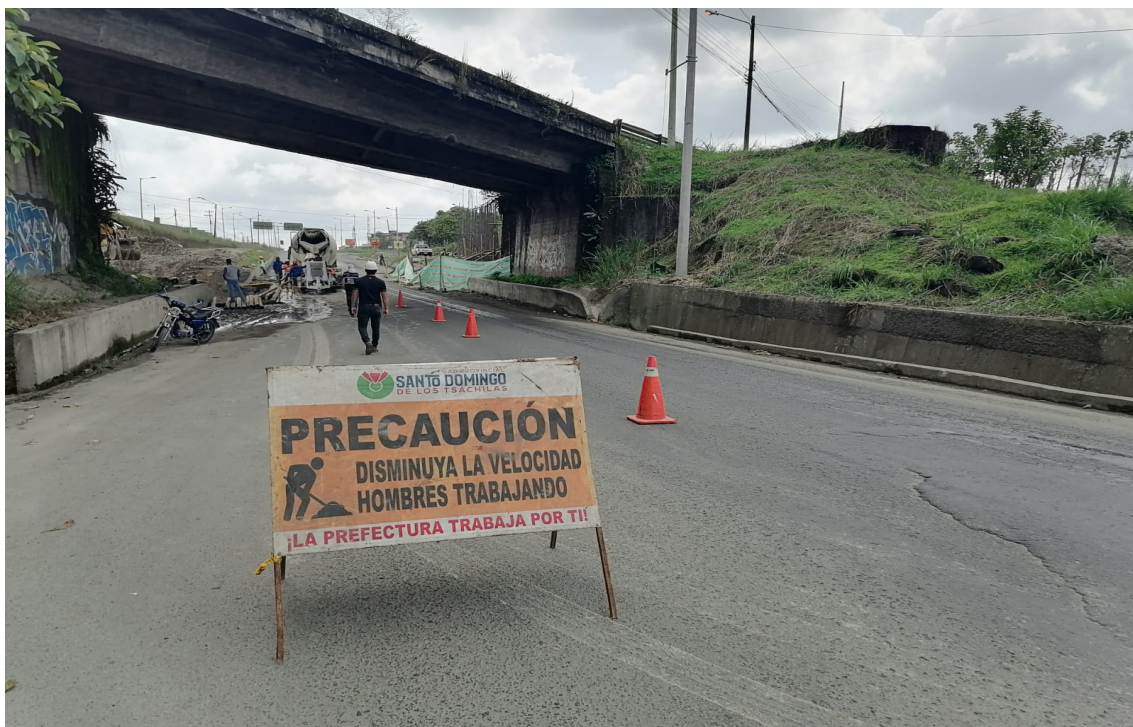
Colocación de letreros de prevención en la perforación de los pilotes de acceso al puente
