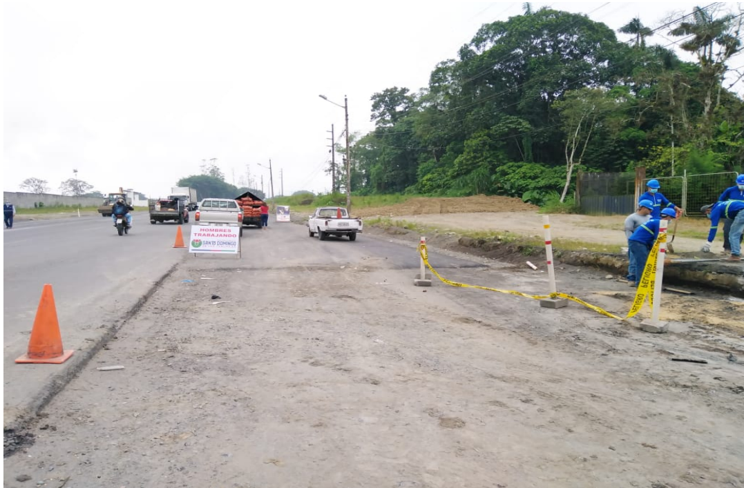
Colocación de letreros de prevención en el frente de obra (replanteo de postes) tramo KFC –Sueño de Bolívar.
