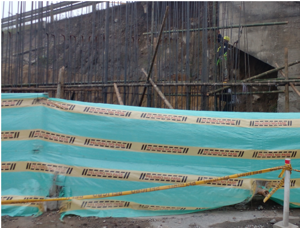
Colocación de sarán como medio de prevención de los trabajos realizados en la estructura del puente
