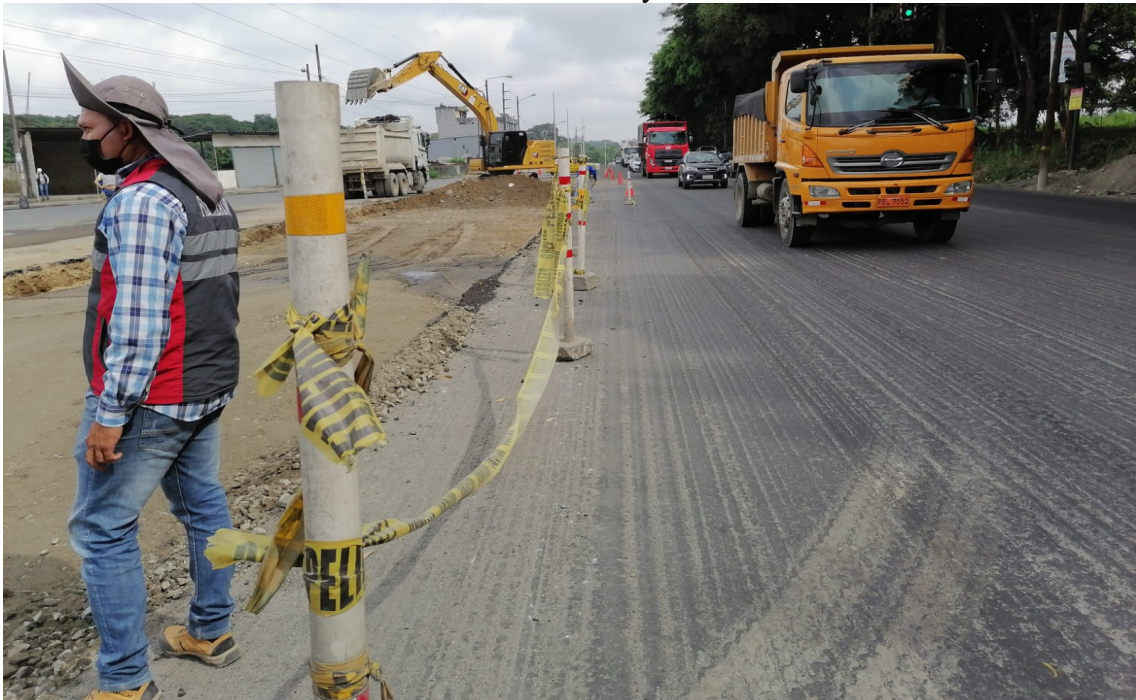
Señalización con cinta de peligro en el corte para el cambio de estructura del ingreso a la Av. Yamboya.
