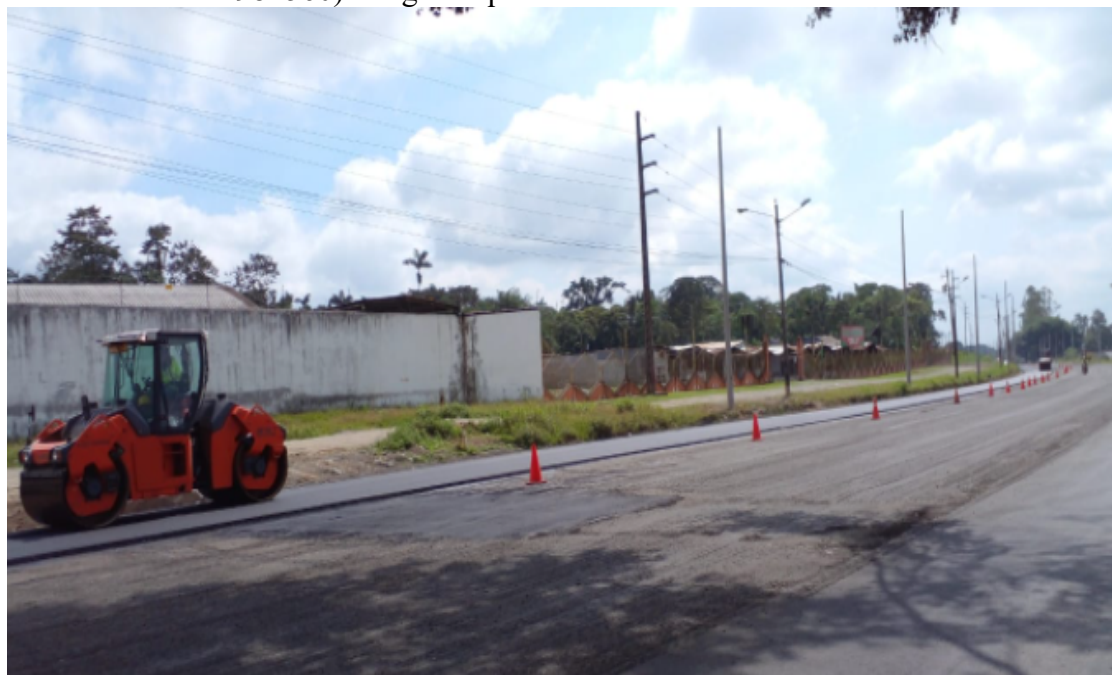
Colocación de conos en la vía en el frente de obra (aplicación de la carpeta asfáltica abscisa 98+880) margen izquierdo tramo KFC –Sueño de Bolívar.
