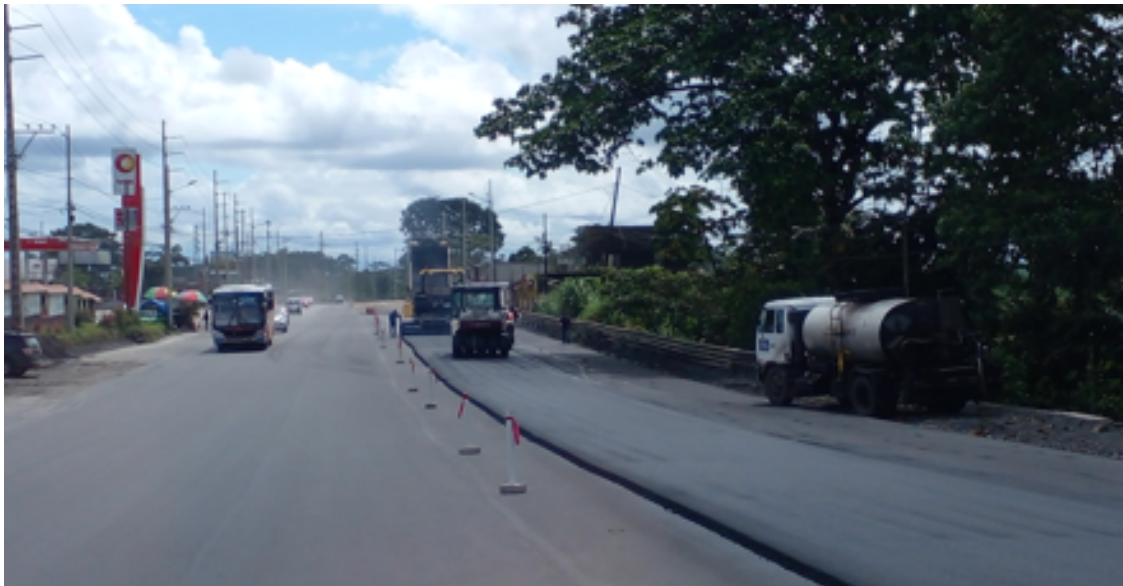
Colocación de conos de prevención en la aplicación de la segunda capa de asfalto sector el Doral
