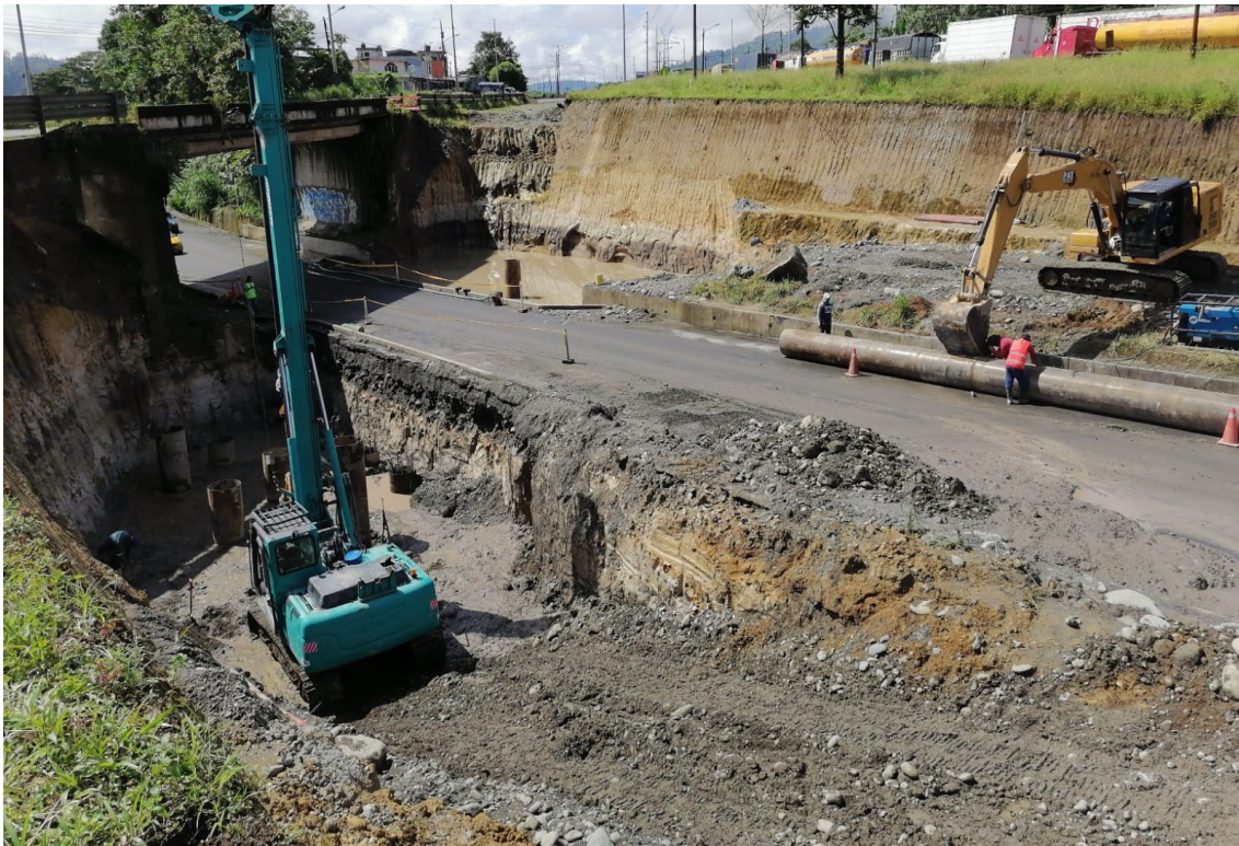
Colocación de señalización preventiva en la perforación de los pilotes del puente
