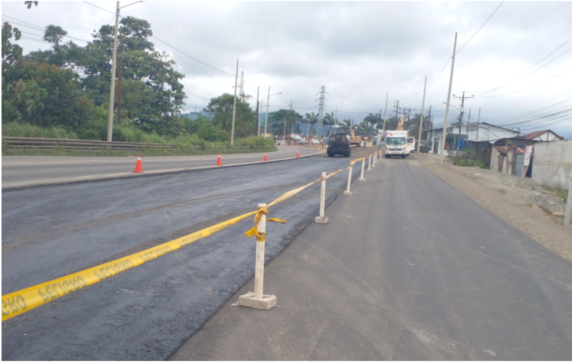
Colocación de cinta de peligro en la aplicación de la carpeta asfáltica sector ANT.
