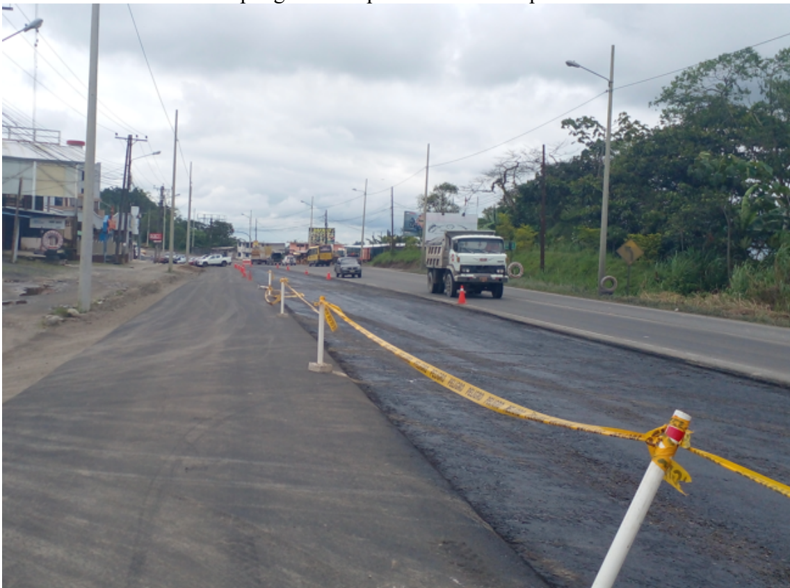
Colocación de cinta de peligro en la aplicación de la carpeta asfáltica sector ANT.
