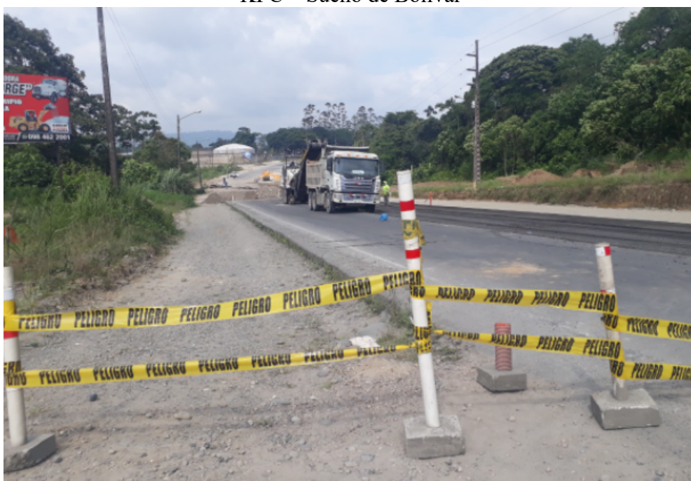
Colocación de cinta de peligro en el fresado y corte para la colocación de alcantarilla ármica abscisa 99+995 KFC – Sueño de Bolívar
