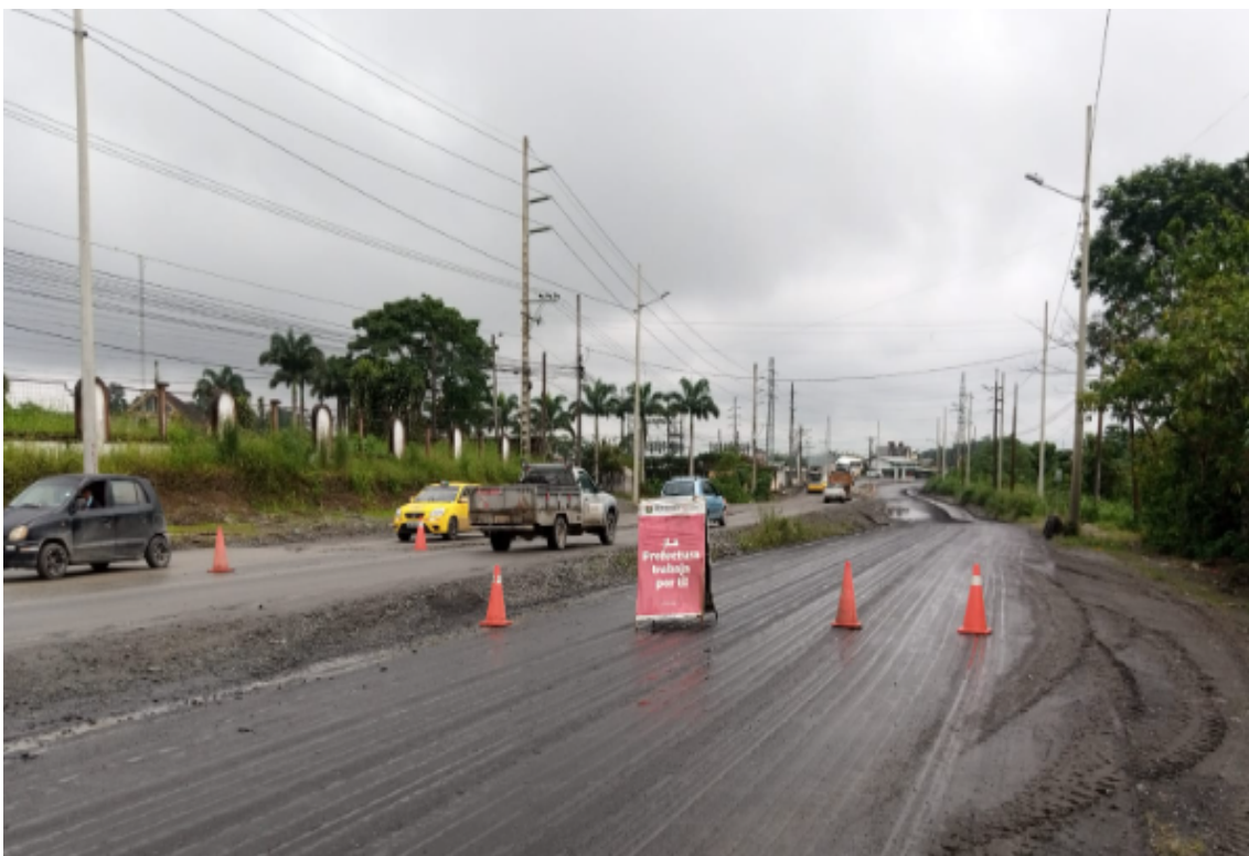
Colocación de señalización preventiva en el fresado de la vía existente
