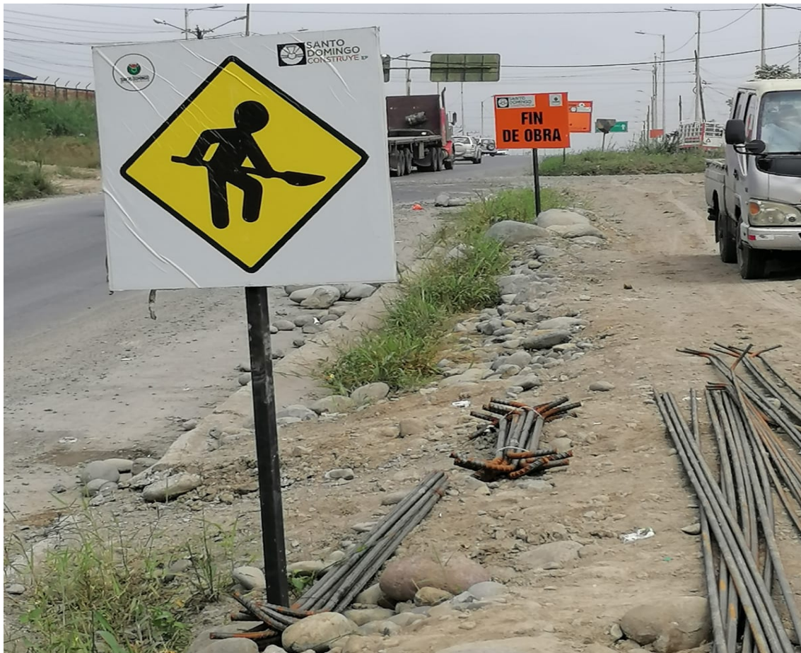
Colocación de letreros de prevención en la perforación de los pilotes de acceso al puente
