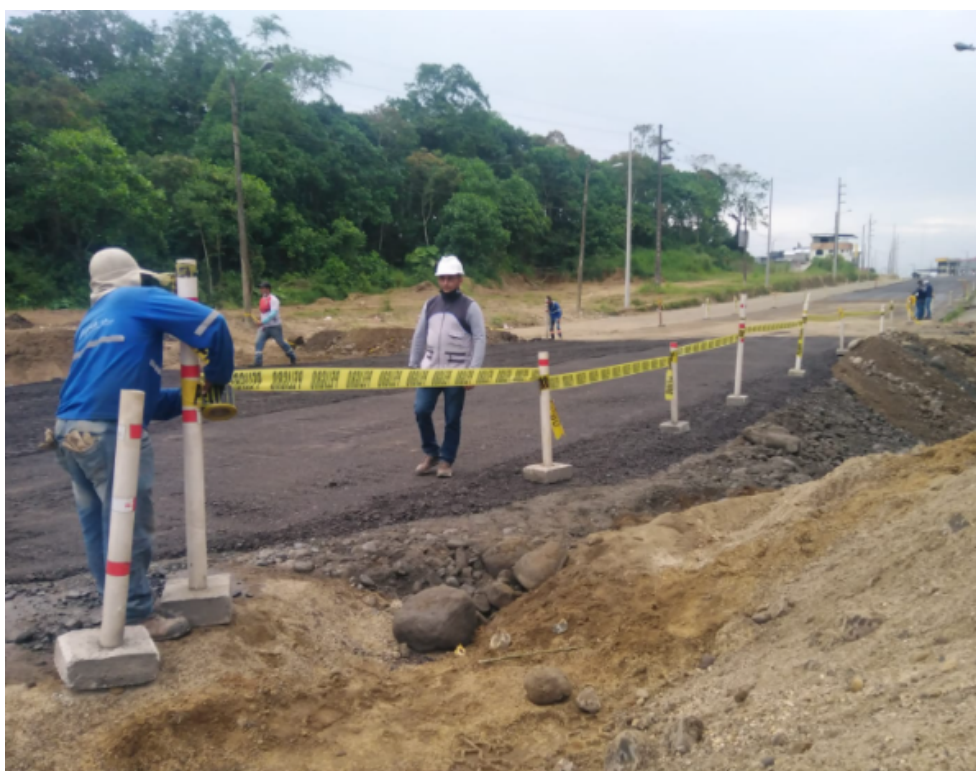
Colocación de cinta de peligro en el relleno sobre la alcantarilla ármica abscisa 99+995 KFC – Sueño de Bolívar
