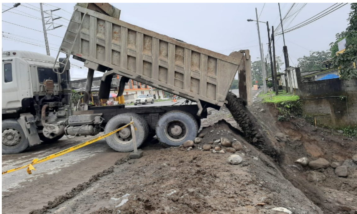
Colocación de cinta de peligro en la excavación para el muro ciclópeo abscisa 95+380.
