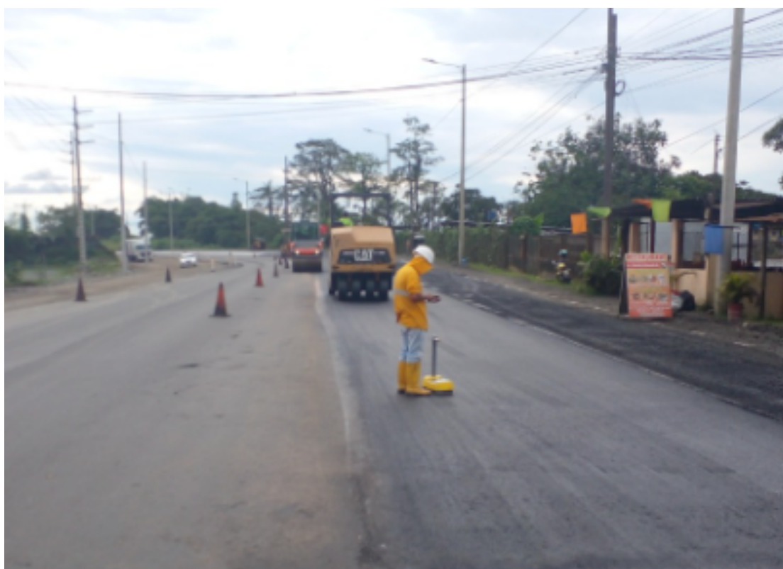
Colocación de señalización preventiva en la aplicación de la carpeta asfáltica sector TURIS-KOL
