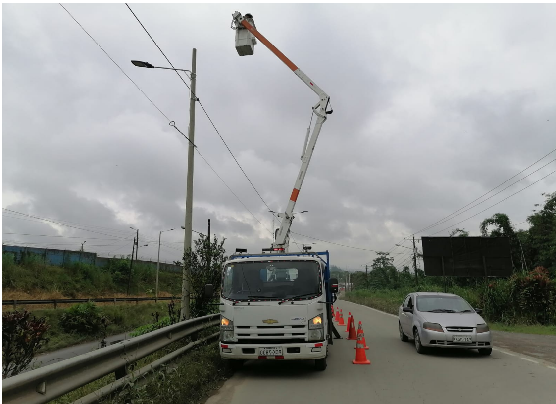
Colocación de conos en la vía en el frente de obra (instalación de luminarias)
