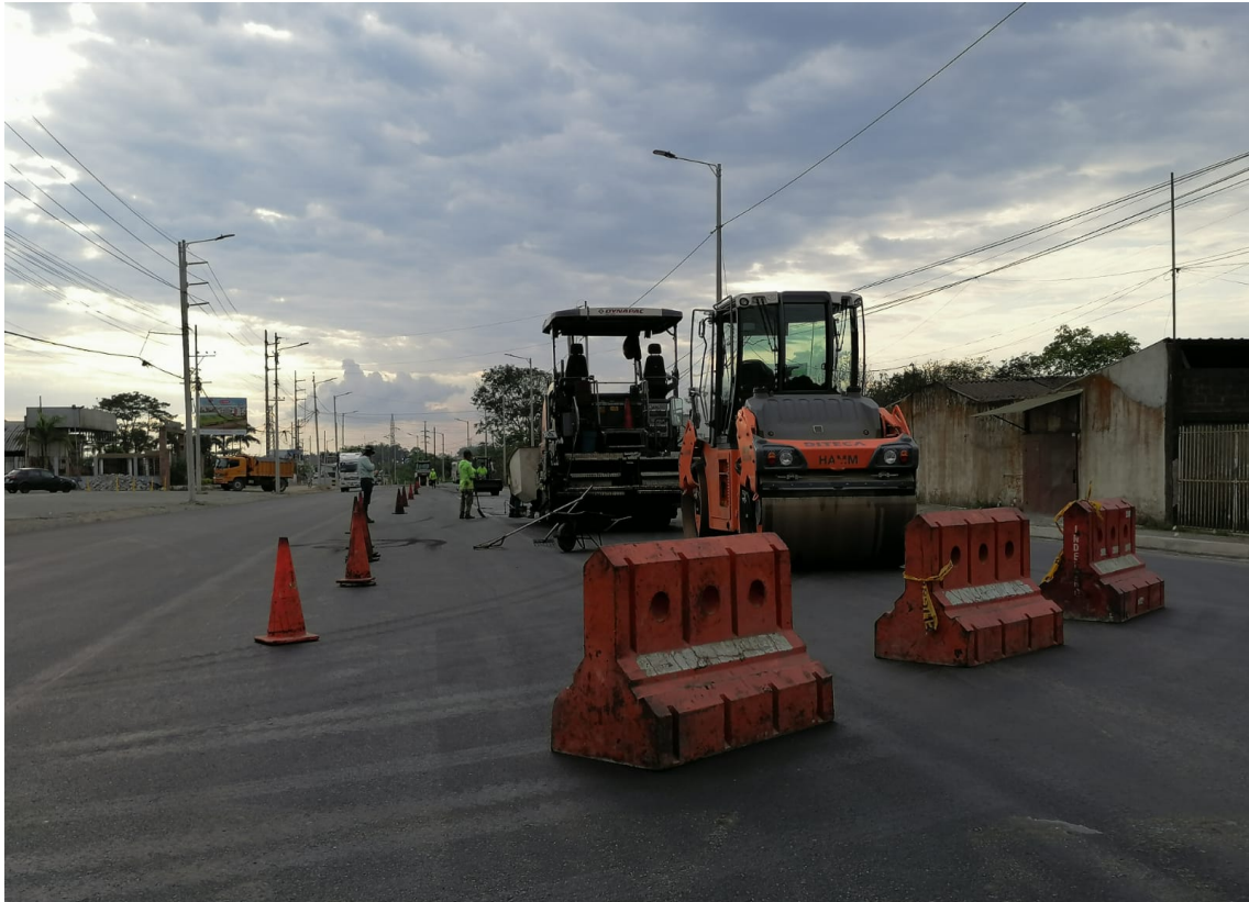
Colocación de conos de prevención en la colocación de la carpeta asfáltica entre el sector portal del lago – plaza Asturias.
