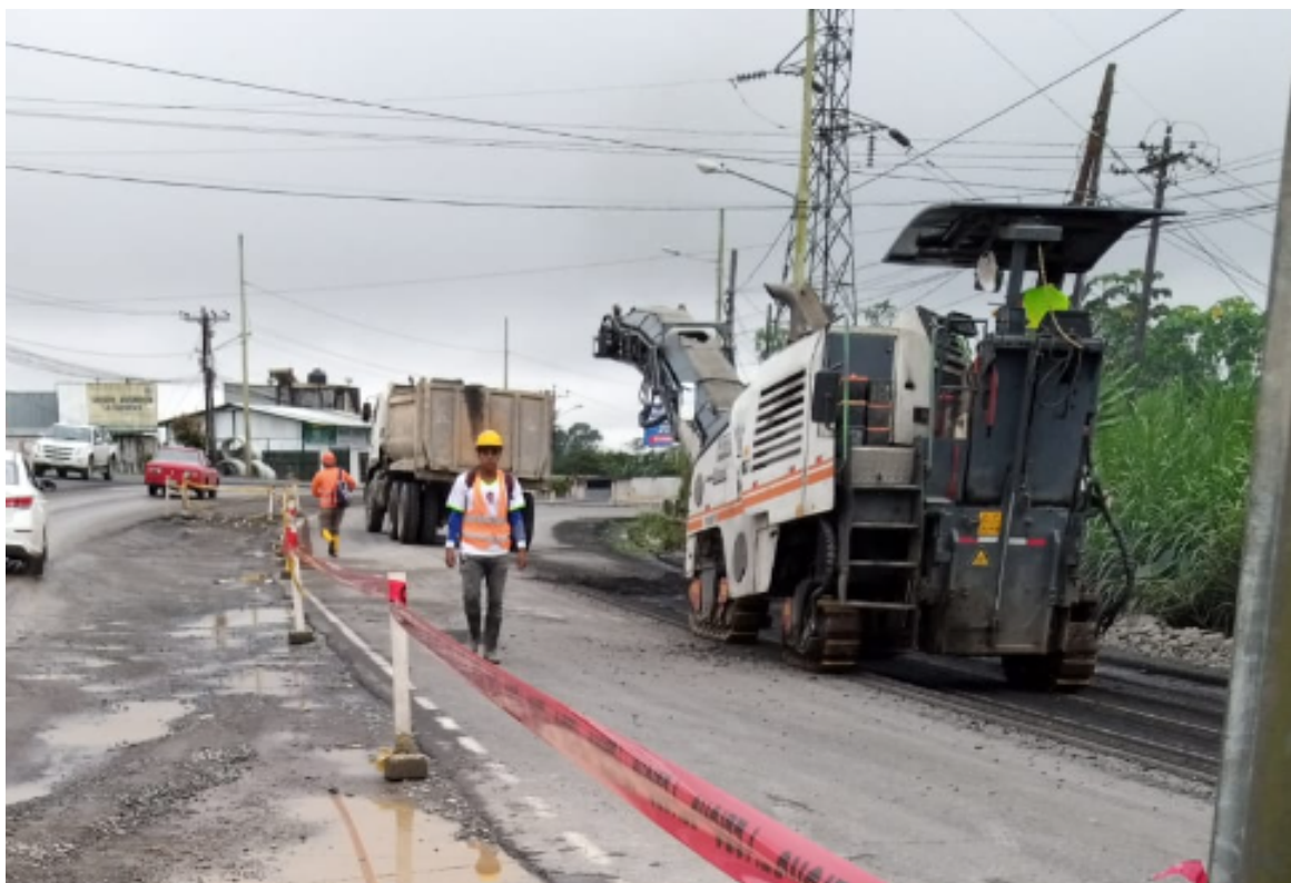
Colocación de cinta de peligro en el fresado de la vía existente.
