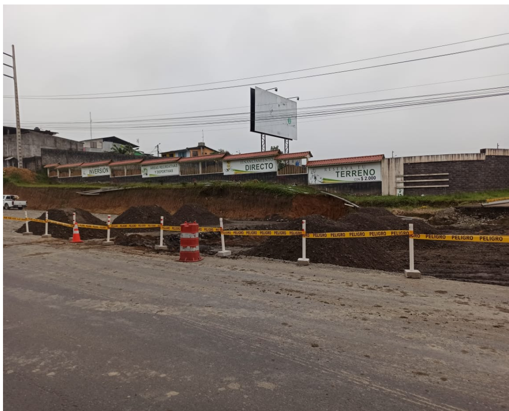
Colocación de cinta de peligro en la colocación de base – KFC-Sueño de Bolívar
