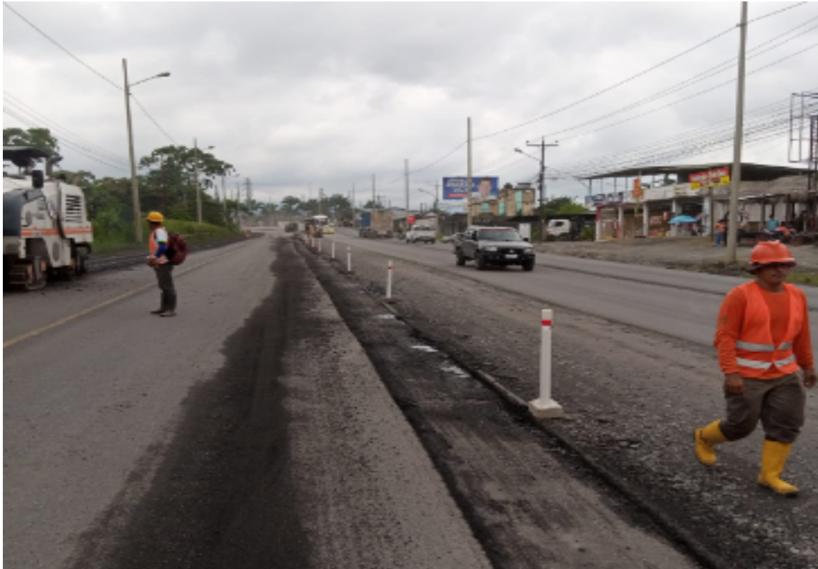
Colocación de pitutos y cinta de peligro en el fresado de la vía existente.
