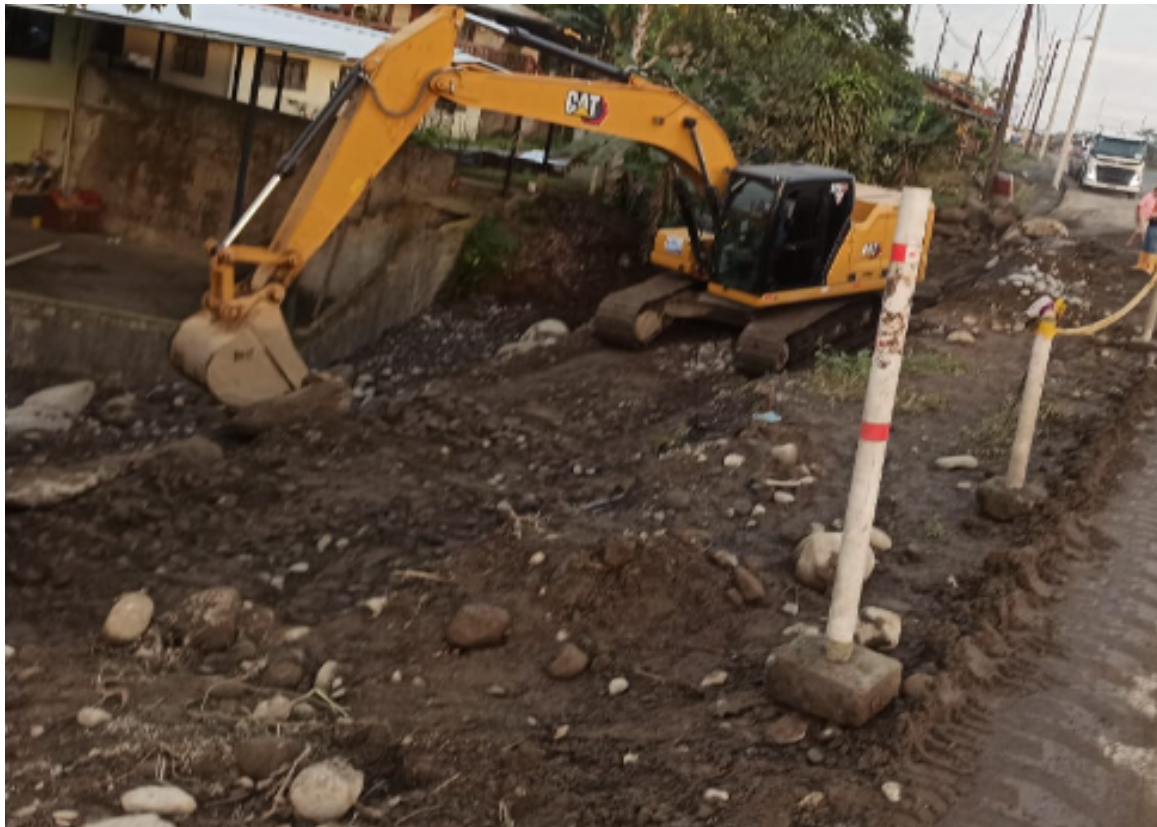
Colocación de cinta de peligro en la excavación para el muro ciclópeo abscisa 95+380.
