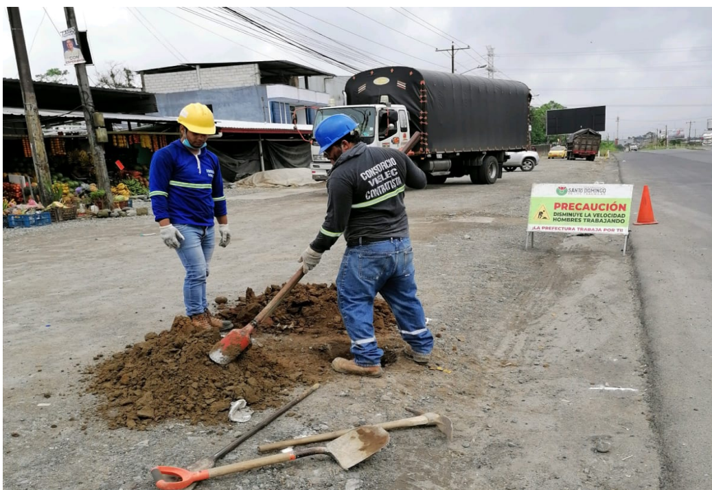
Colocación de letreros de prevención en el frente de obra (excavación de huecos para colocación de postes 14m x 500kg/cm 2 ) margen izquierdo tramo KFC –Sueño de Bolívar
