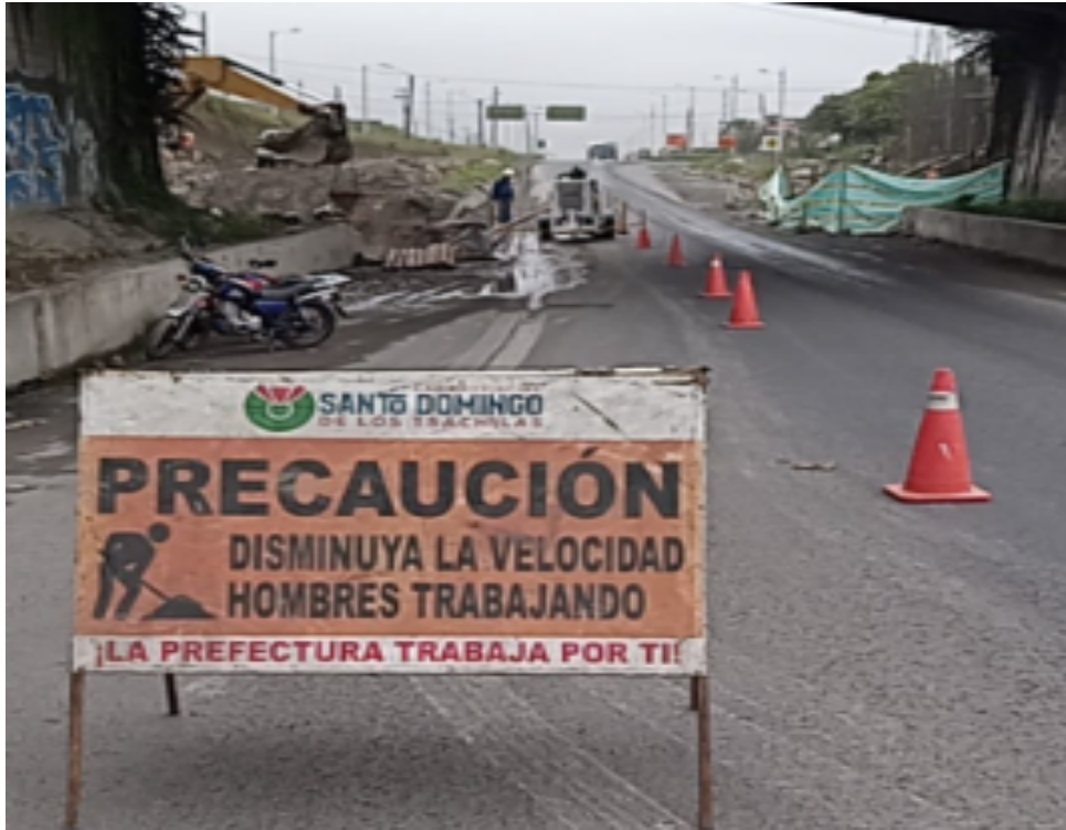
Colocación de letrero y conos de prevención en la fundición de pilotes en el puente
