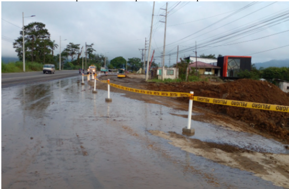
Colocación de señalización preventiva en el desalojo de material sector Colibrí.
