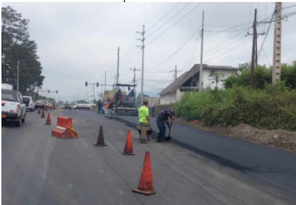
Colocación de conos de prevención en la colocación de la carpeta asfáltica entre el sector portal del lago – plaza Asturias.
