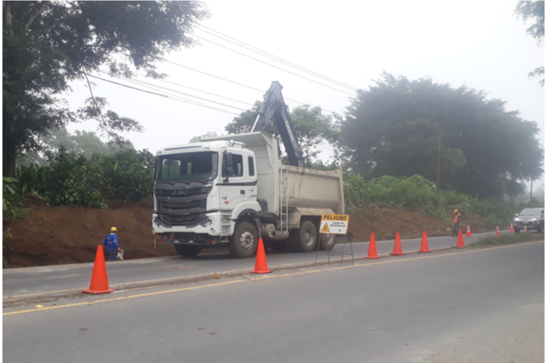
Colocación de conos en la vía en el frente de obra corte de la cajonera en el intercambiador hacia el parque de la juventud.
