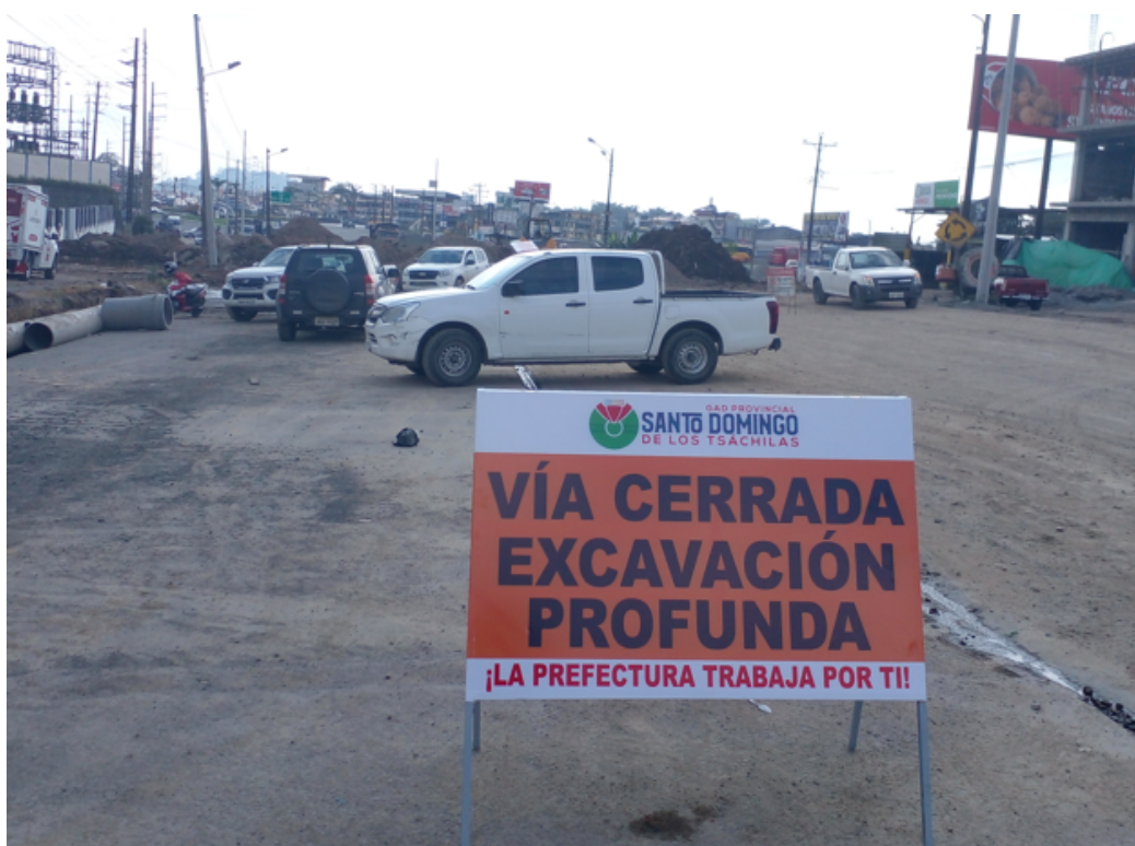
Colocación de letreros de prevención en el corte para la colocación de alcantarilla ármica abscisa 100+515 KFC – Sueño de Bolívar
