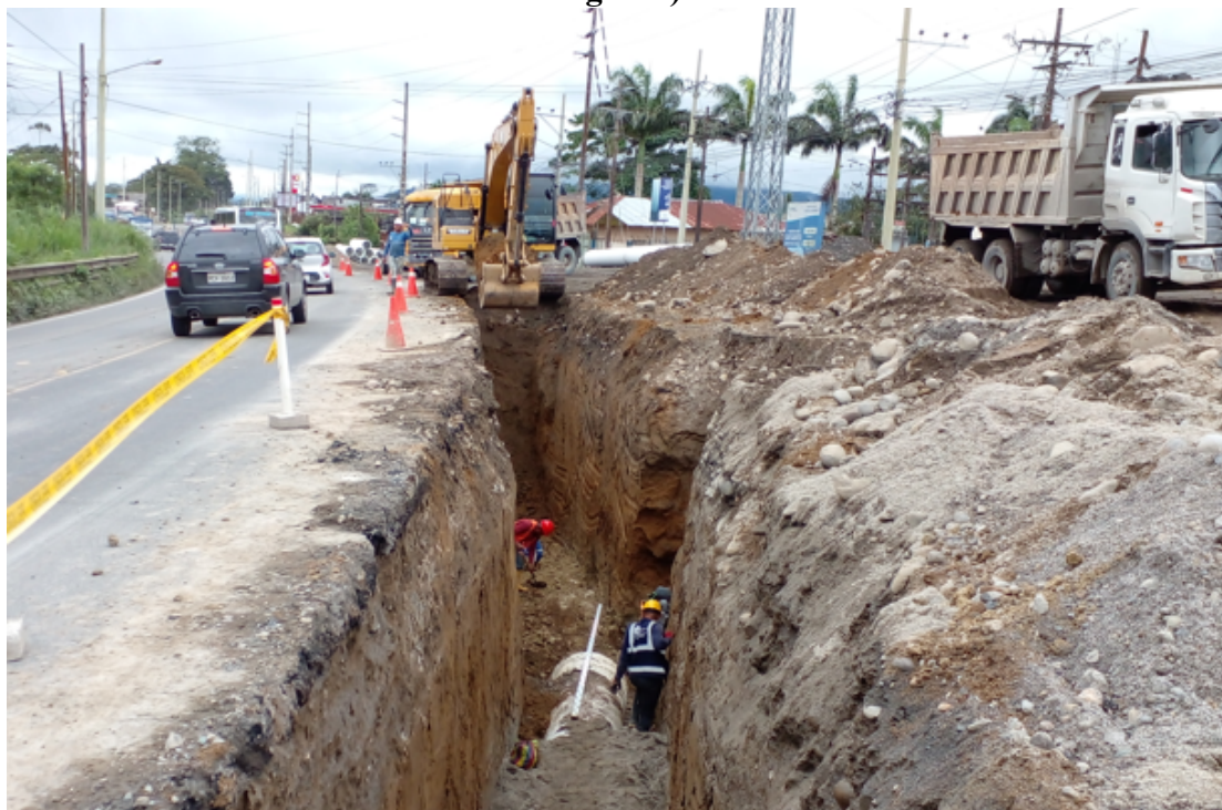
Colocación de cinta de peligro y conos de prevención en la colocación de tubería corrugada para la construcción del alcantarillado pluvial.
