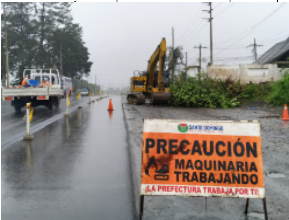
Colocación de conos y letreros de prevención en la excavación de la cajonera para mejorar el suelo y continuar con la ampliación de la vía
