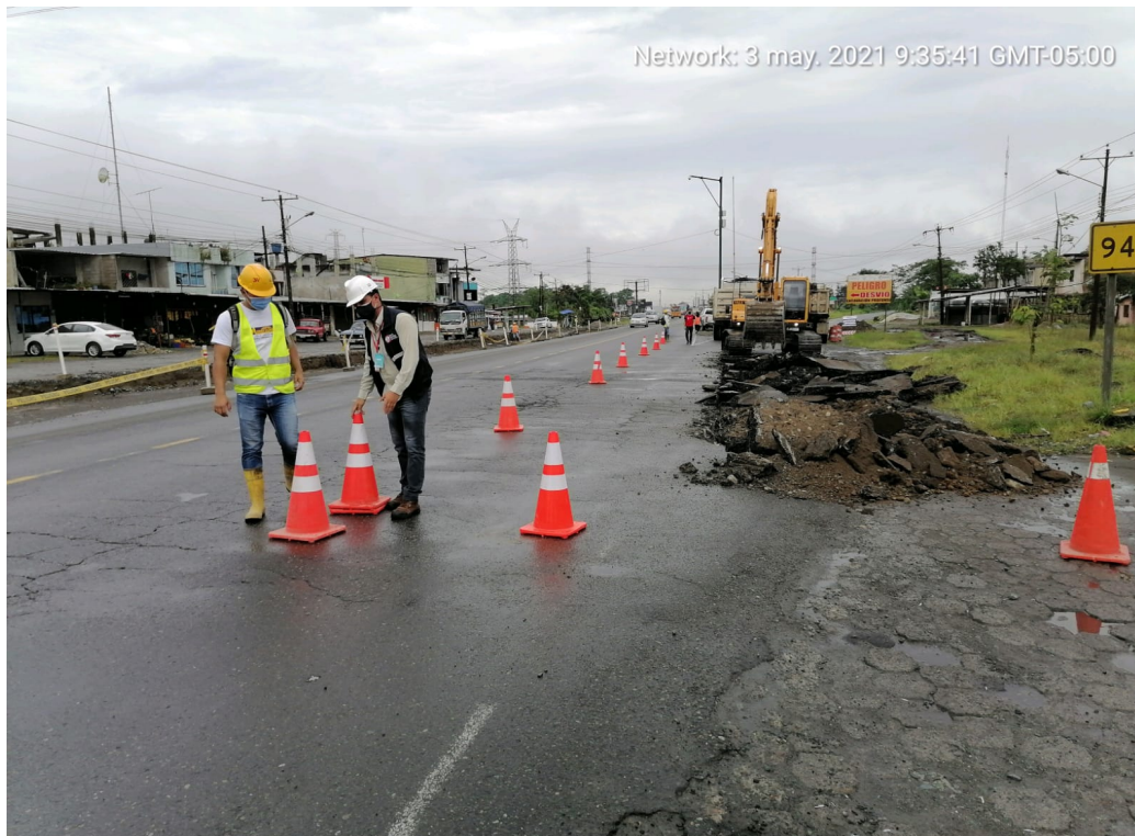
Colocación de conos en el corte de asfalto abscisa 93+720 KFC – Sueño de Bolívar
