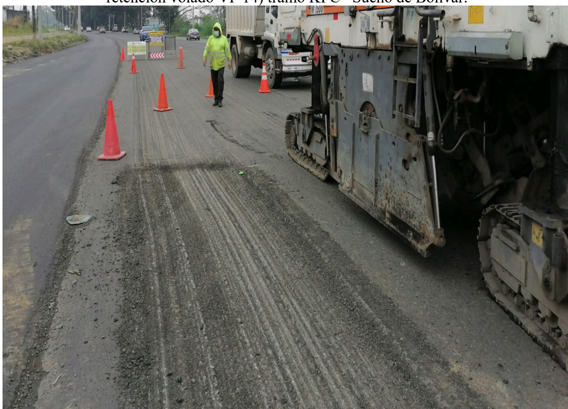
Colocación de conos en la vía en el frente de obra (fresado de carpeta asfáltica existente abscisa 94+750) tramo KFC –Sueño de Bolívar.
