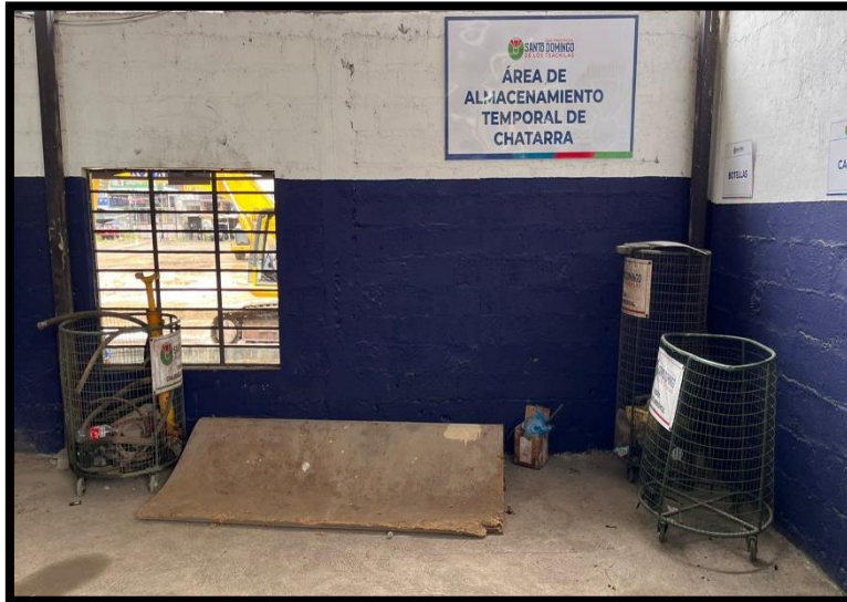
Área de Almacenamiento - 2 Contenedores de vidrio y 1 contenedor de botella
