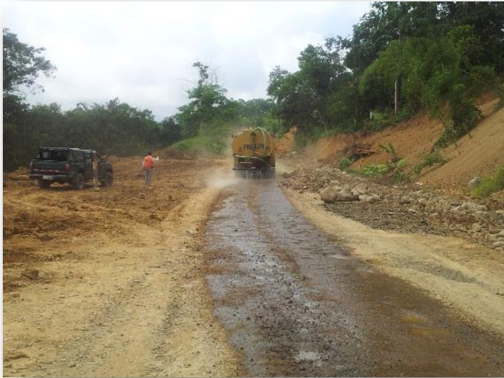
Disposición de agua con tanquero
