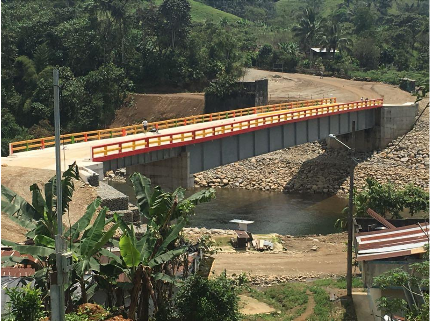
Puente sobre el río Mulaute construido,
