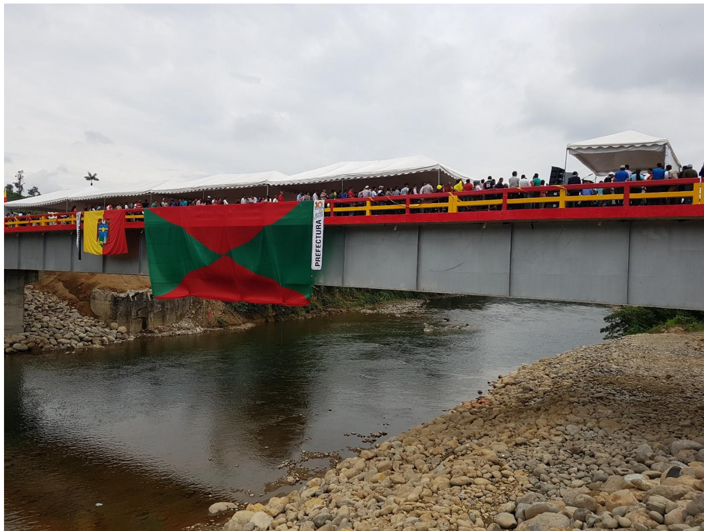
Inauguración del Puente sobre el Río Mulaute
