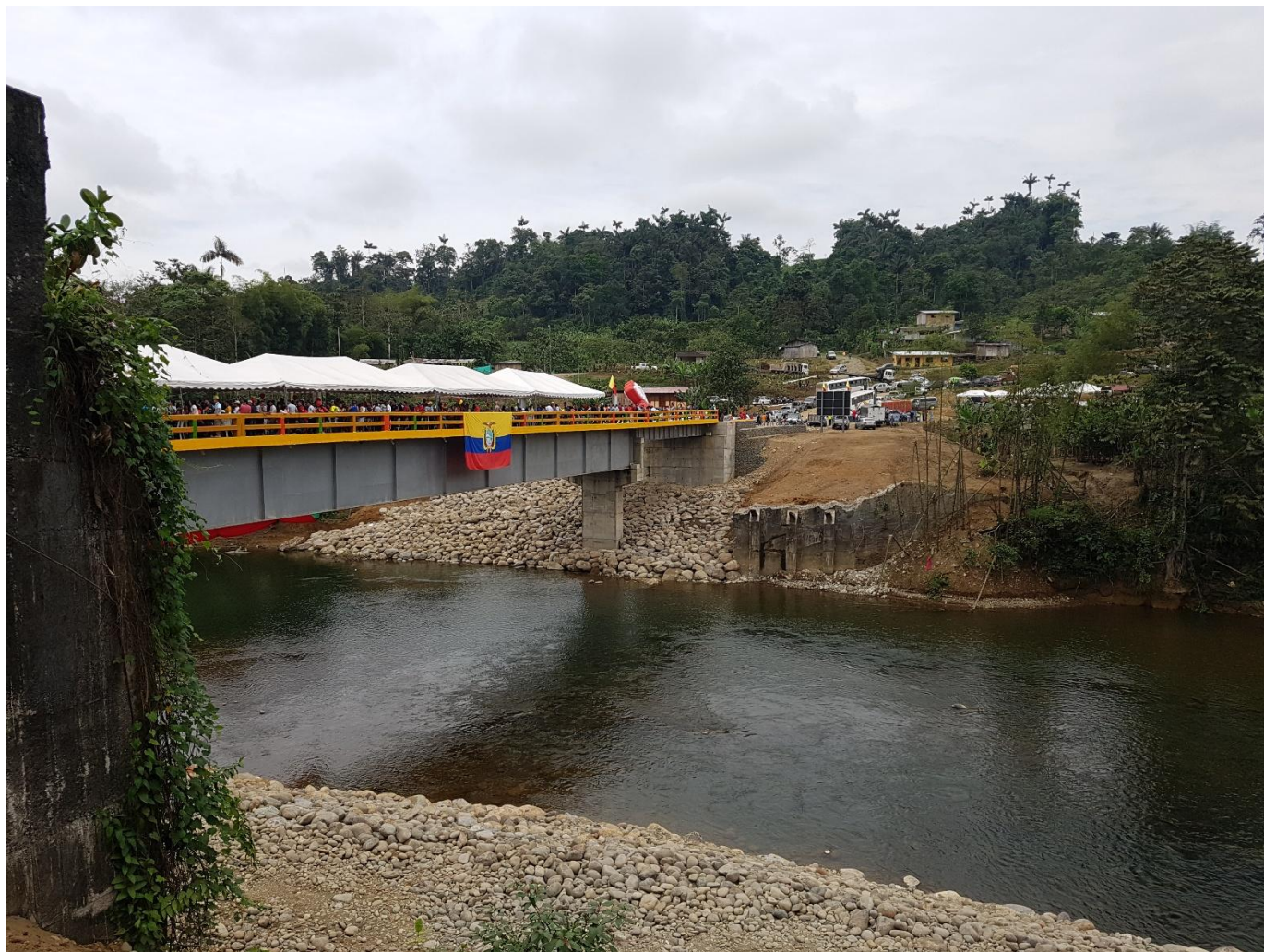
Inauguración del Puente sobre el Río Mulaute
