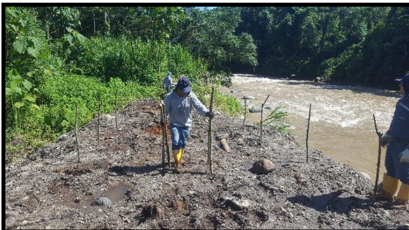
Colocación de Balizas
